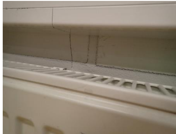
Kuva 20. Normaalisti ja alipaineistettuna tiilimuurauksen saumoissa merkittävää ilmavuotoa.
