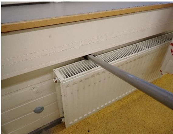
Kuva 33. Normaalissa ja alipaineistetussa tilassa patterikannakkeessa pistemäistä ilmavuotoa.
