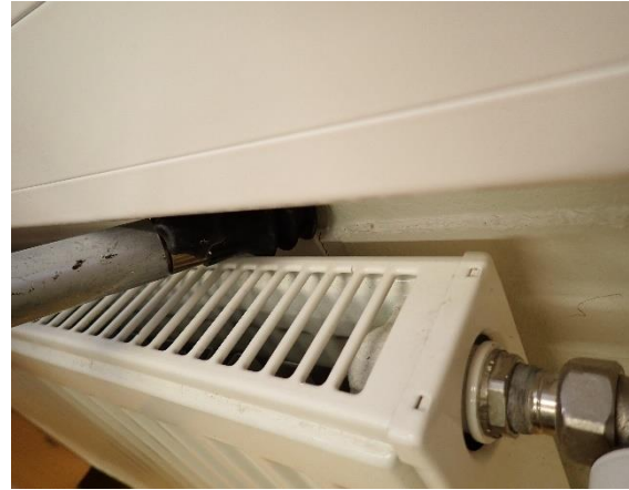
Kuva 25. Normaalisti / alipaineistetussa tilassa, tiilimuurauksen halkeamassa merkittävää ilmavuotoa.
