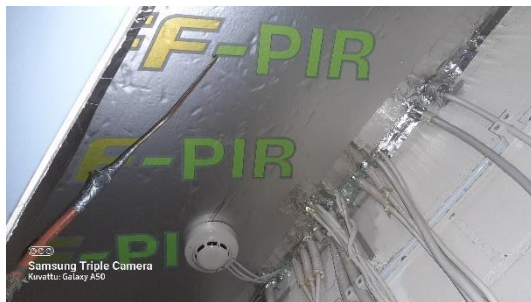
Kuva 5 Katon levy tiivistetty alumiiniteipillä. Teip-paukset ovat tiiviit
