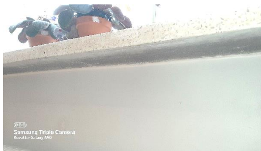
Kuva 8 Ikkunalaudan alapuolelta on tiivistetty ja työn jälki on hyvä. Mittauksissa ei havaittu vuotoja.
