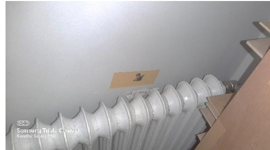
Kuva 12 Molemmat patterikannakkeet vuotavat
