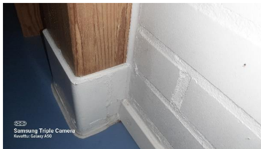
Kuva 2 Pilarinjuuren 1 tiivistys on hyvä. Pilarin ja seinän tiivistys on hyvä.
