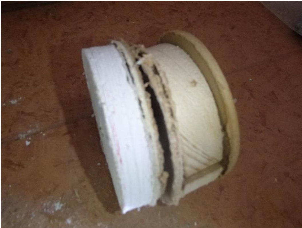
Kuva 3. Rakenneavauksen RAK1 rakenteet.
