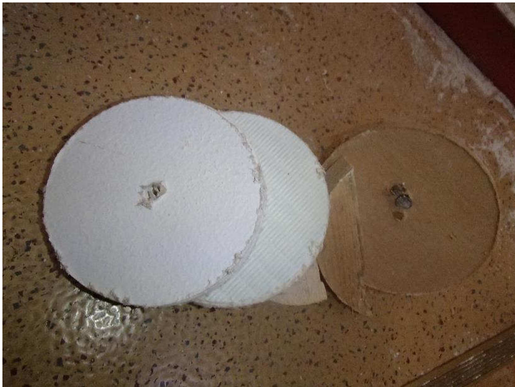
Kuva 13. Rakenneavauksen RAK6 rappukäytävän ulkoseinärakenteet.
