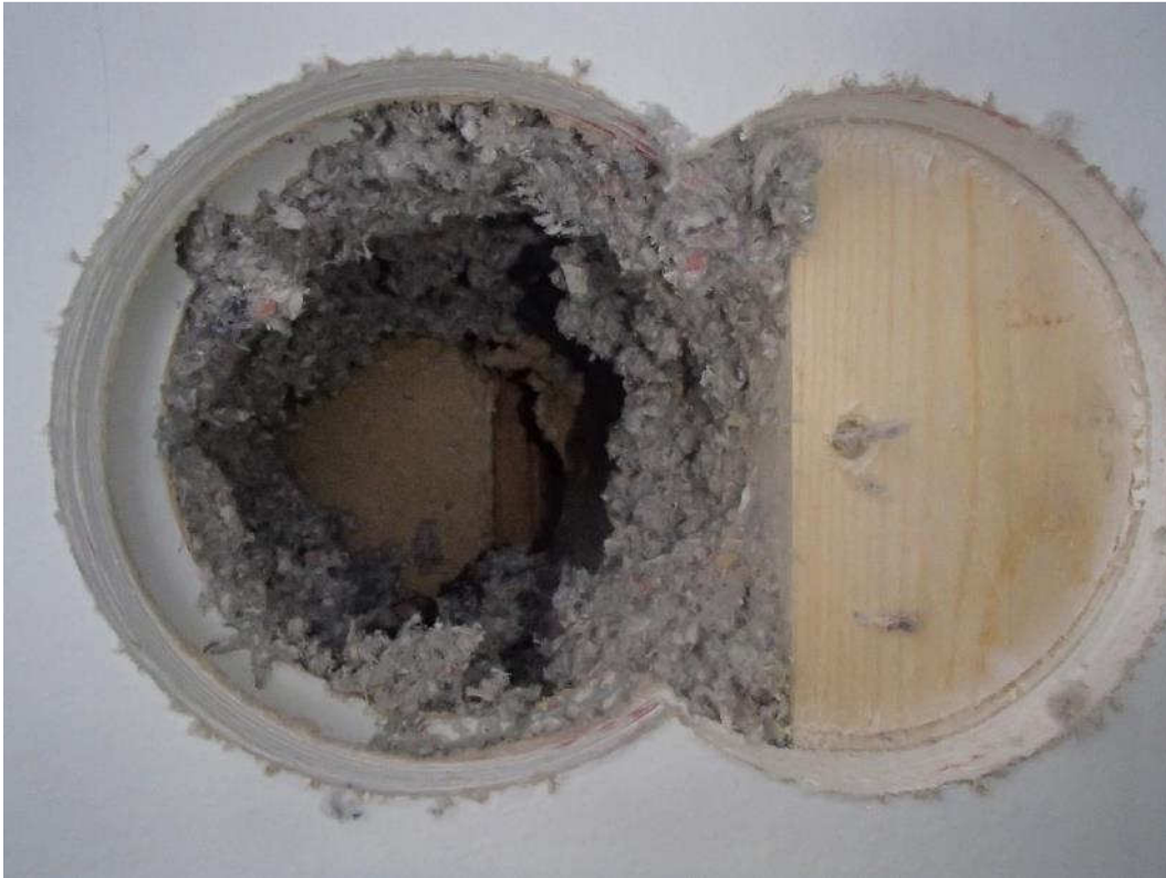
Kuva 8. Rakenneavaus RAK3 2.kerroksen vinokattorakenteeseen.
