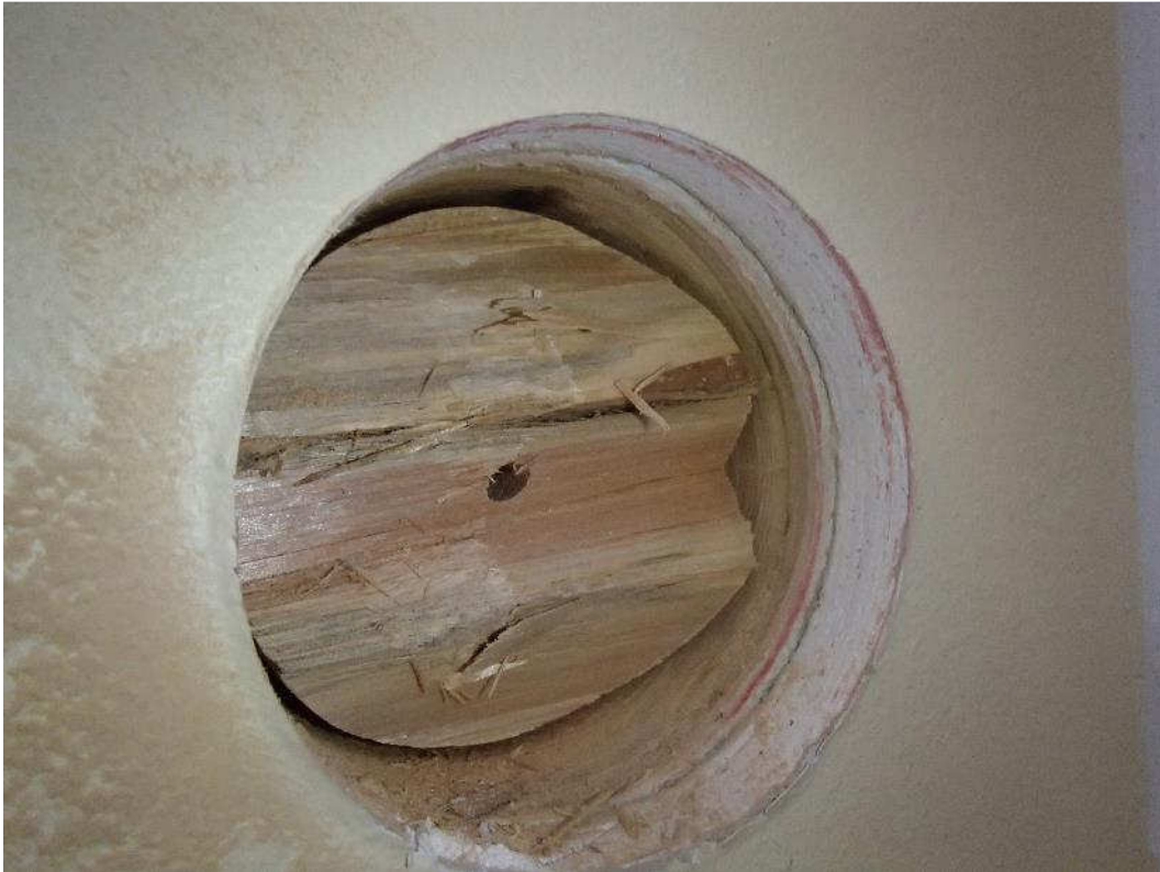
Kuva 11. Rakenneavaus RAK5 rappukäytävän ulkoseinärakenteeseen (pohjoissivu).
