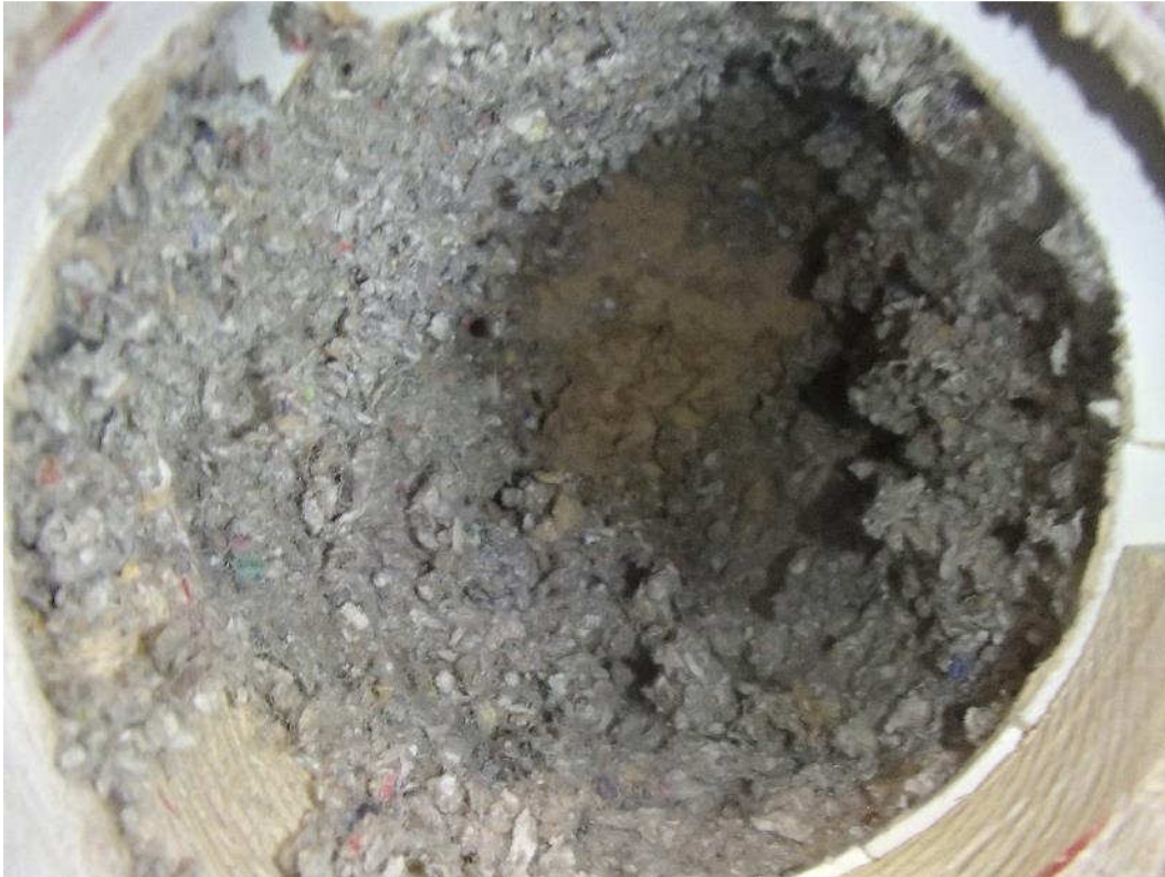
Kuva 10. Rakennearaus RAK4 2.kerroksen ulkoseinärakenteeseen.
