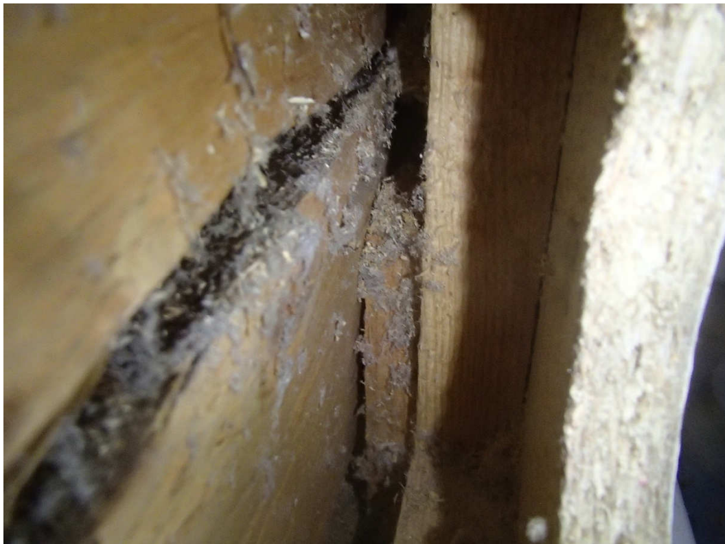
Kuva 18. Rakenneavaus RAK12 luokkahuoneen ja käytävän väliseen väliseinään.
