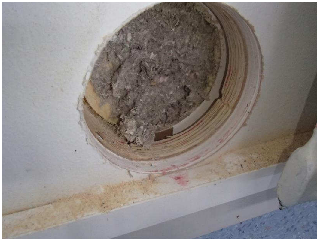
Kuva 5. Rakenneavaus RAK2 2.kerroksen ulkoseinärakenteeseen.
