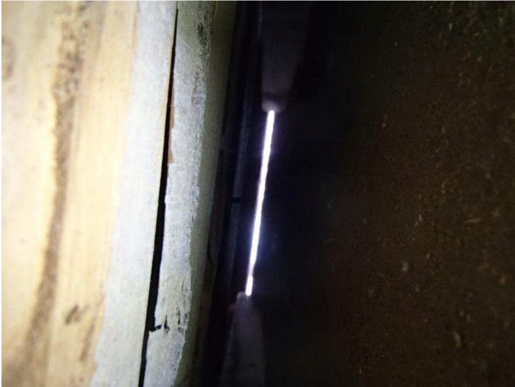
Kuva 9. Rakenneavaus RAK3 2.kerroksen vinokattorakenteen tuuletusväli.
