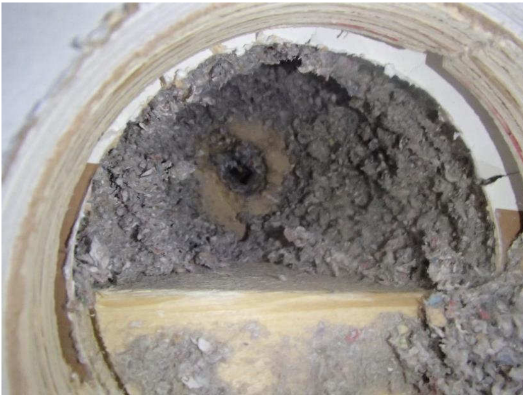
Kuva 6. Rakenneavaus RAK2 2.kerrosen ulkoseinärakenteeseen.
