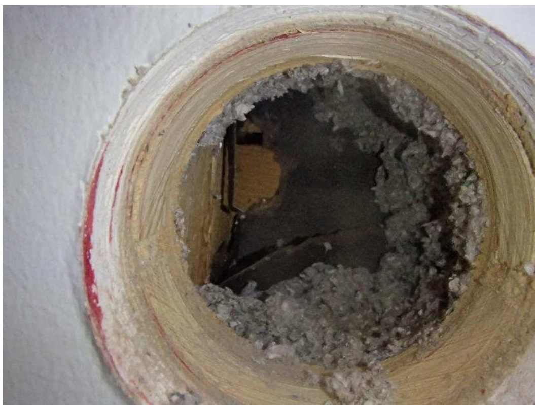
Kuva 2. Rakenneavaus 2. kerroksen ulkoseinärakenteeseen.
