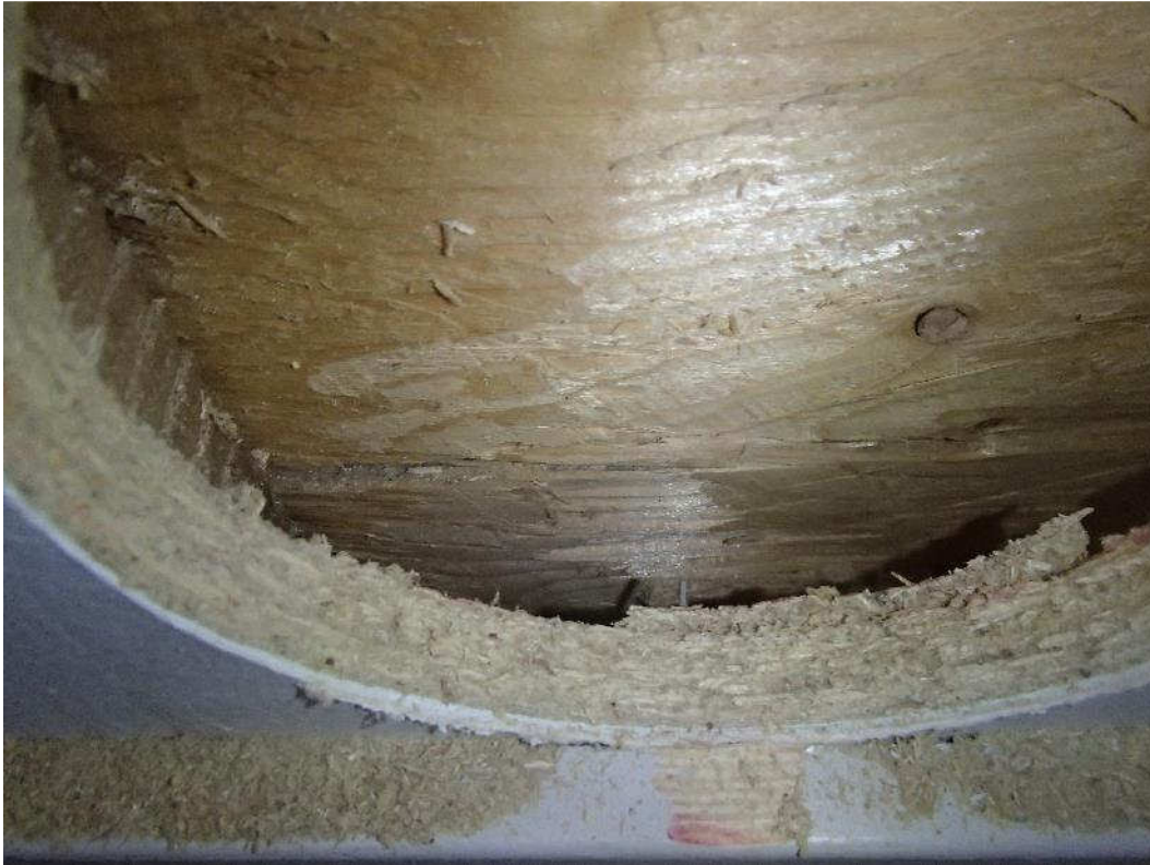
Kuva 17. Rakenneavaus RAK12 luokkahuoneen ja käytävän väliseen väliseinään.
