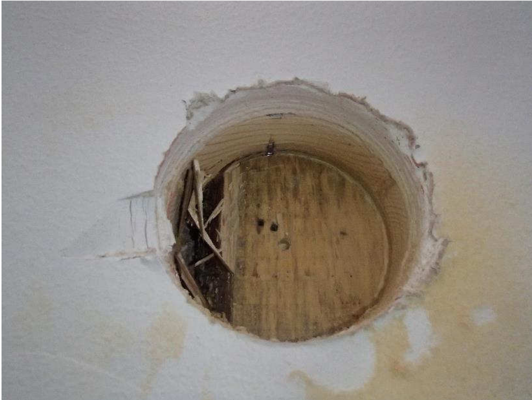
Kuva 12. Rakenneavaus RAK6 rappukäytävän ulkoseinärakenteeseen (itäsiivu).
