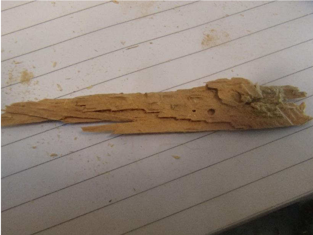
Kuva 16. Rakenneavaus RAK7...11 tyhjässä tilassa havaittiin vanhaa hirsimateriaalia.
