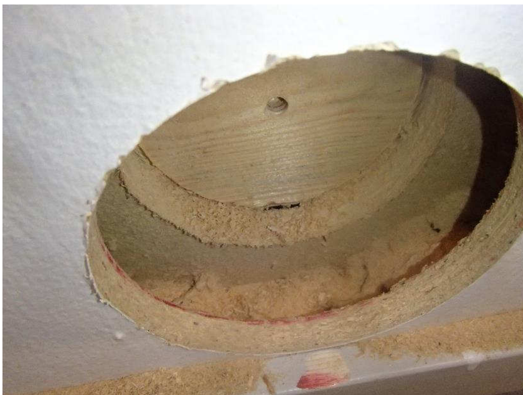
Kuva 14. Rakenneavaus RAK7 luokkahuoneen 104 ulkoseinärakenteeseen.
