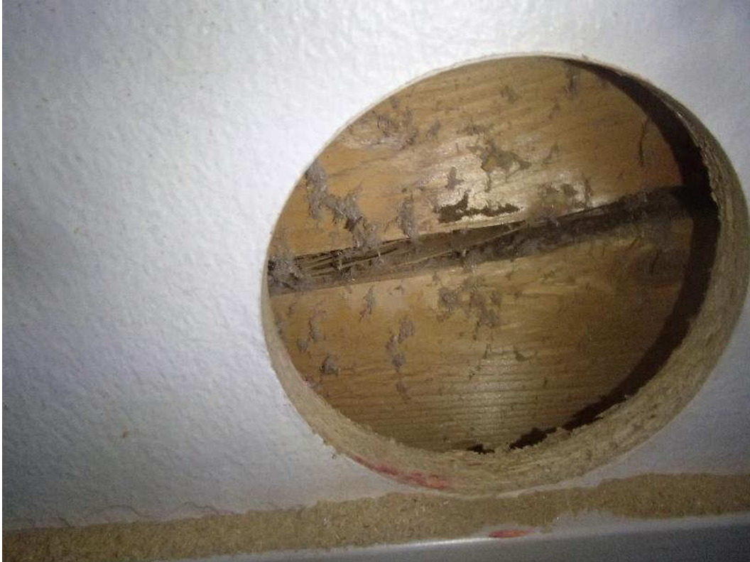
Kuva 15. Rakennevaivaus RAK10 luokkahuoneen 102 ulkoseinärakenteeseen.
