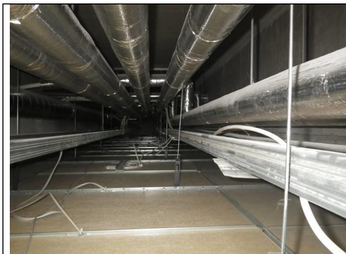
5. Alaslasketun sisäkaton yläpuolista tilaa alakerroksen käytävällä
