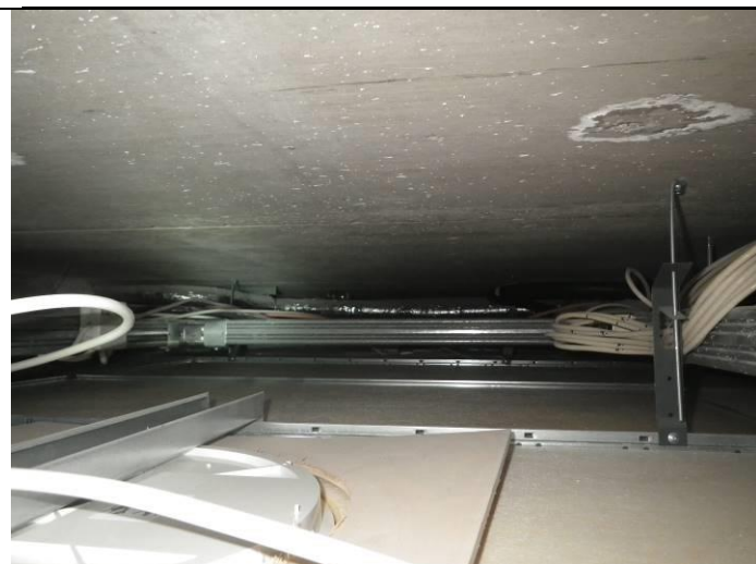
7. Alaslasketun sisäkaton yläpuolista tilaa yläkerroksen käytävällä
