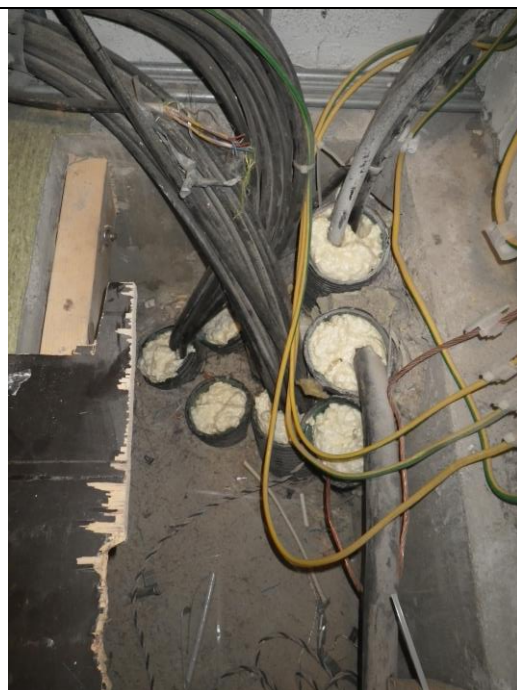
17. Sähköpääkeskuksen lattian läpivientien tiivistyksiä
