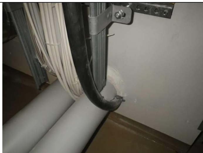
13. IV-koneen seinän tiivistettyjä läpivientejä
