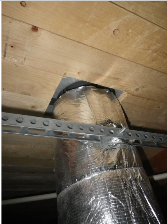
3. Vesikaton alapuolista laudoitusta ja läpivientä
