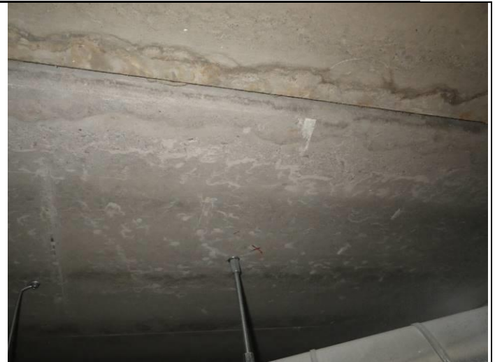
4. Yläpohjan ontelolaataston alapintaa
