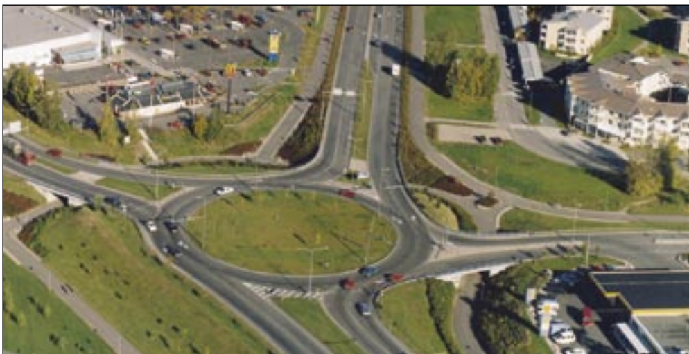
Kuva 5.4-2: Kiertoliittymä on turvallinen liittymämuoto.
