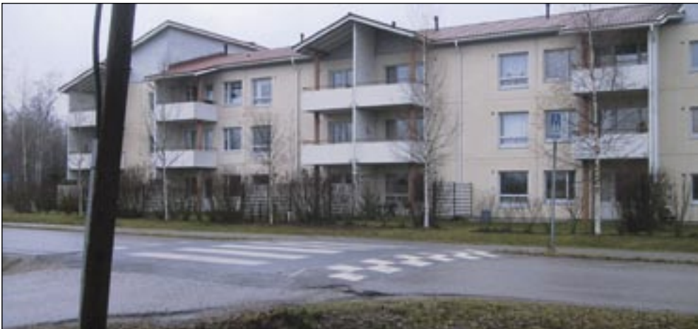
Kuva 5.3-3: Korotettu suojatie Omenalahdentiellä.
