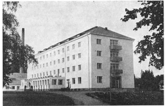
Talousrakennus alkuperäisessä asussaan. Kuva Hänninen 1965, s. 49.
