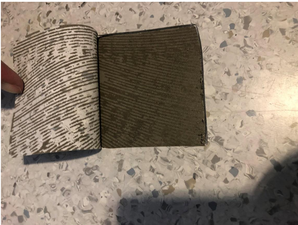
Kuva 15. Luokassa 22 matto oli hyvin kiinnittynyt alustaansa. Liimassa havaittiin lievä kemikaalimainen haju.
