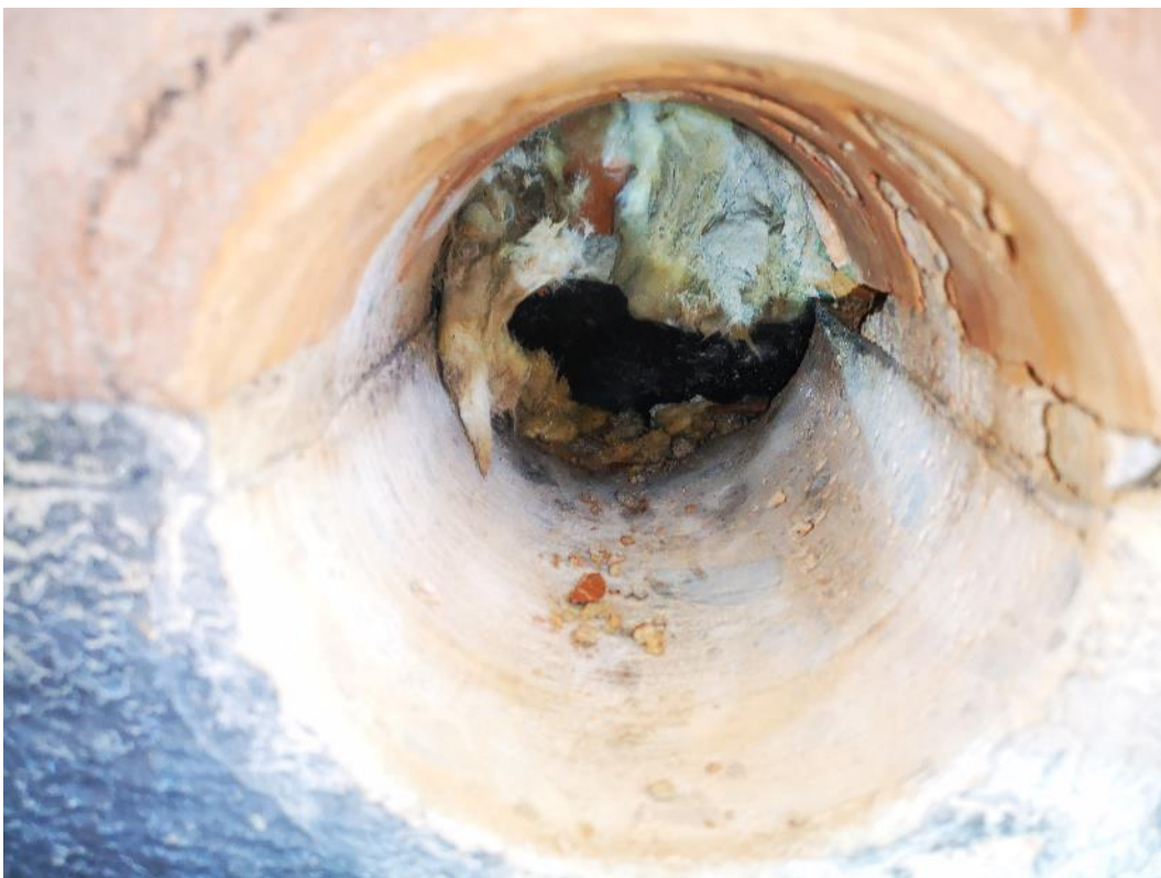
Kuva 3. Rakenneavaus J2 kuraattorin huoneen ulkoseinärakenteeseen sokkelin ja tiilimuurauksen rajapinnasta.
