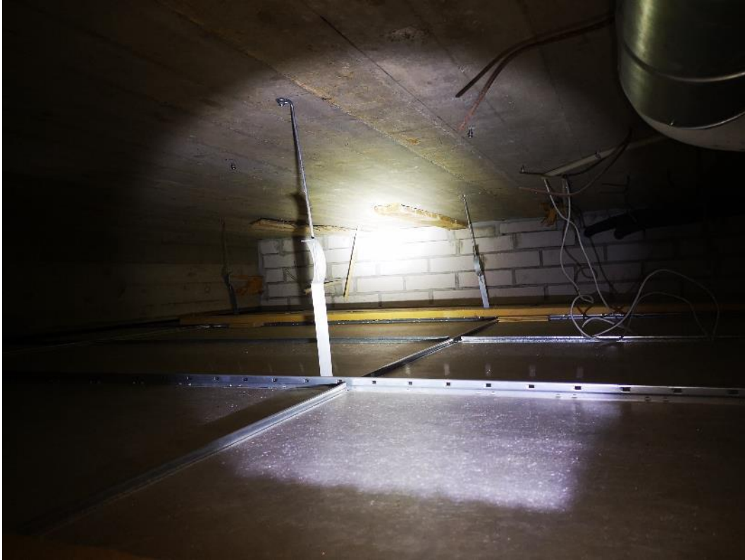
Kuva 6. Alaslasketunkaton yläpuolella havaittiin vanhoja muottilautoja.
