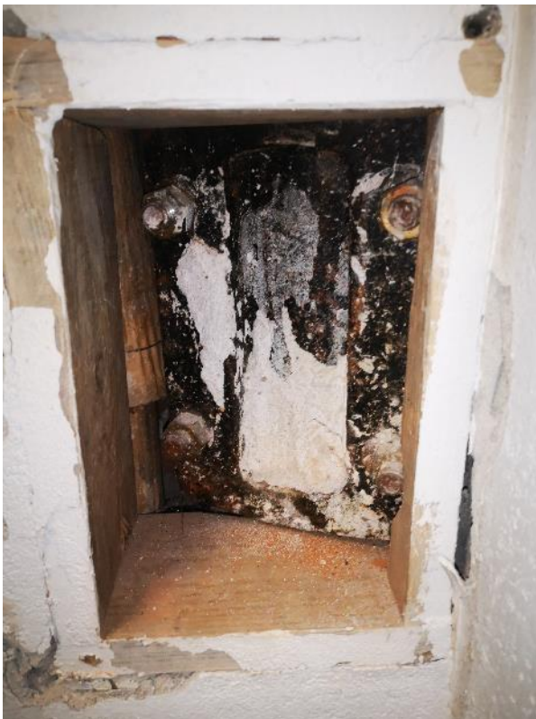
Kuva 5. Kuraattorin huoneen putkikuilu tarkastusluukun takaa.
