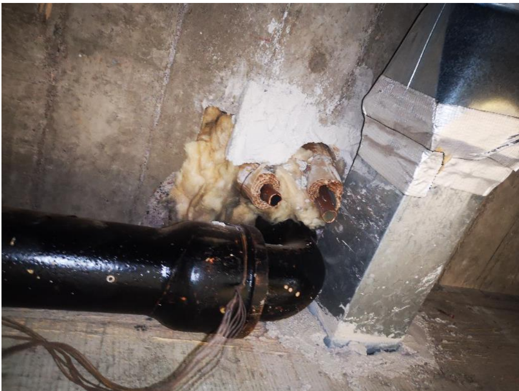
Kuva 7. Alaslasketun katon yläpuolella havaittiin läpivientejä, jotka on tukittu mineraalivillalla.
