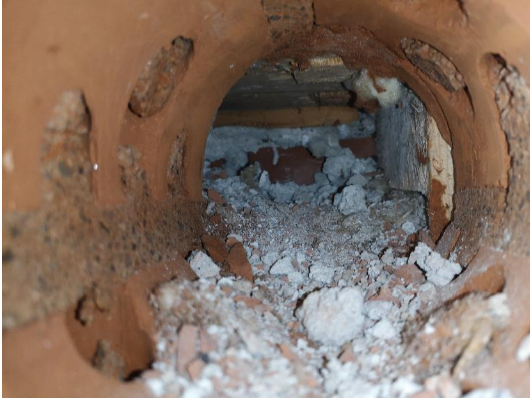
Kuva 2. Rakenneavaus J1 kuraattorin huoneen ulkoseinärakenteeseen ikkunan alapuolelta.
