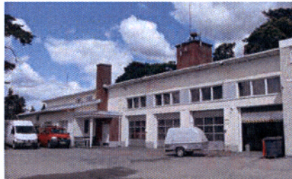
32C Hyrylän vanha paloasema, vasemmalla miehistöosa, etualalla autohallit. 32_C_paloasema_SDC11425.jpg
