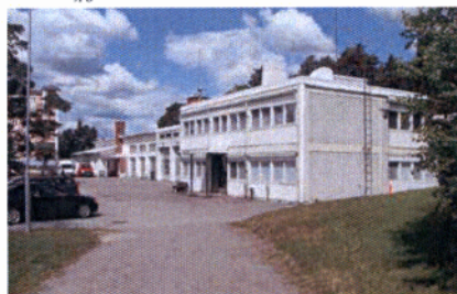
32 B Hyrylän vanhan paloaseman uudisosa 32_C_paloasema_SDC11424.jpg
