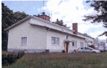
32 B Hyrylän paloaseman vanhan puolen palopäällikön asunto edustaa 1950-luvulle tyypillistä rapattua tiilirakentamista. 32_C_paloasema_SDC11427.jpg
