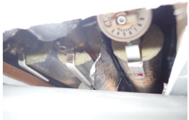
Kuva 14: Alaslaskettujen kattojen tekniikkatiloissa paikoin pinnoittamatonta mineraalivillaeristettä.
