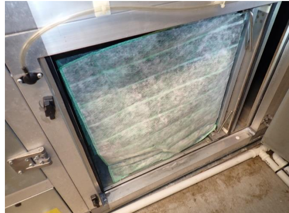
Kuva 22: Tuloilmasuodatin likaantunut.
