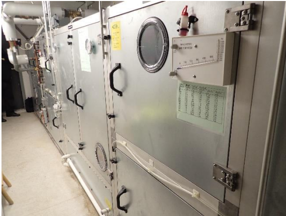
Kuva 21: Rakennuksen ilmanvaihtokone.
