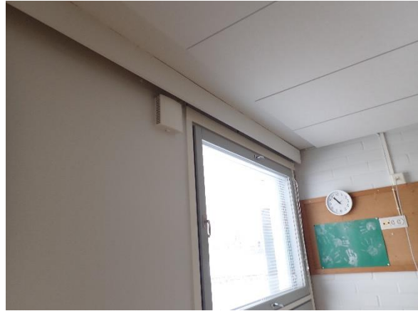
Kuva 24: Palaverihuoneessa korvausilmaventtiili.
