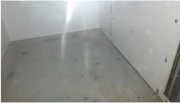
Kuva 18 Hissin pohjalla hydraulioöljytahroja
