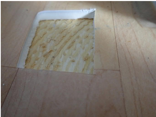
Kuva 16 Liikuntasalin parkettikuvioinen joustomatto on liimattu lattialaudoituksen päälle.
