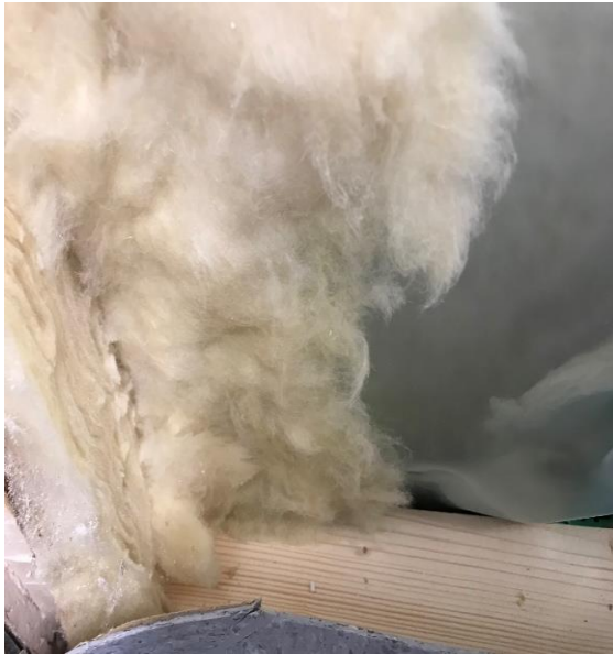
Kuva 3 Alajuoksupuoli oli siisti ja ei havaittu vaurioita materiaalissa.
