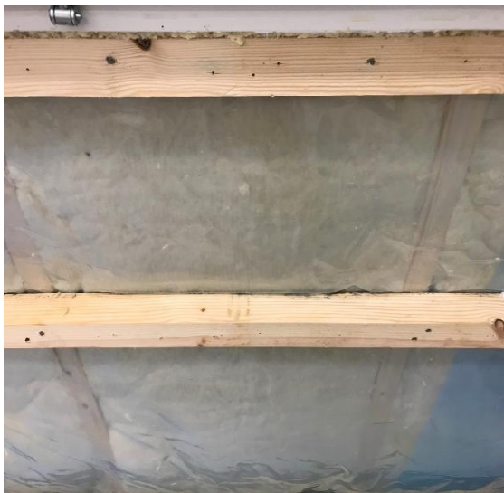
Kuva 5 Runkorakenteet näyttivät hyväkuntoisilta.
