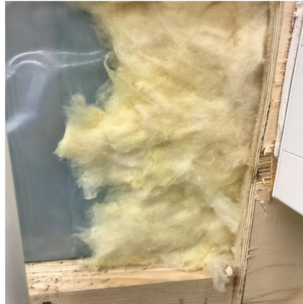
Kuva 4 Ulkoseinän alaosa. Materiaaleissa ei havaittu vaurioon viittaavia jälkiä tai hajuja
