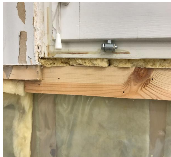
Kuva 6 Ulkoseinän ikkunan alapuolella höyrynsulkumuovin sisäpuoleisessa runkokuussa ei havaittu vaurioita.
