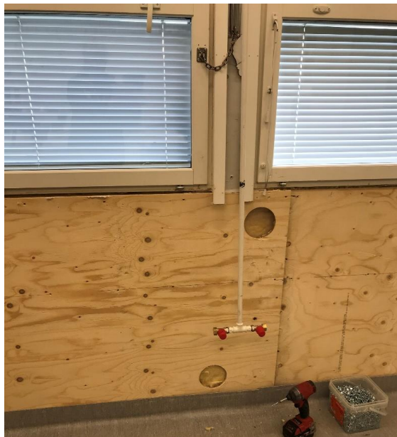
Kuva 1 Ulkoseinän sisäpuolisessa vanerilevyssä ei havaittu vaurioita
