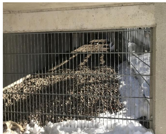
Kuva 4 Rakennuksen vierustalla on sorakaista.
