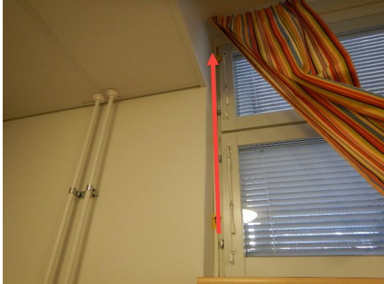
Kuva 23 Rungon ja ikkunan välillä on suora ilmayhteys ulkoilmaan.
