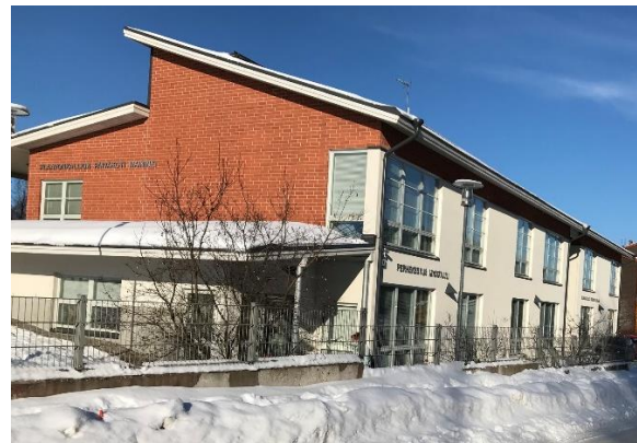
Kuva 2 Rakennuksen kaakkoissivun ulkoseinät ovat rapattua.
