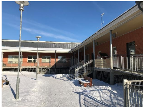
Kuva 1 Kiinteistössä osa ulkoseinistä tiiliverhoiltuja
