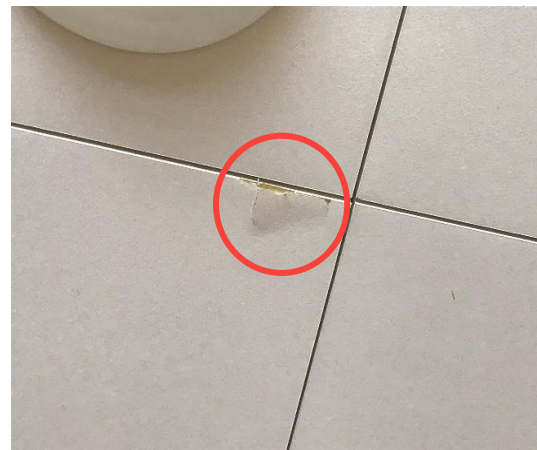
Kuva 11 Alakattolevyssä havaittiin pieniä vaurioita
