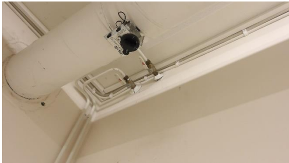
Kuva 8. Sulkuventtiilit ovat tyydyttävässä kunnossa.
