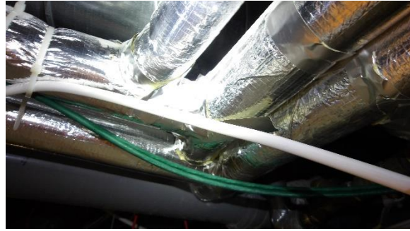
Kuva 5. Paikoin eristeet ovat alumiini/villaa.
