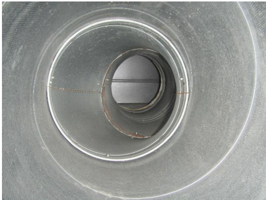
Kuva 38. Pyöreässä tuloilmakanavassa (pohjakerros) ei ole merkittävää pölykertymää.
