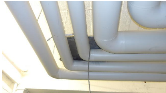
Kuva 29. Kuvauskohta 14. (Huoltomiehen tila)
