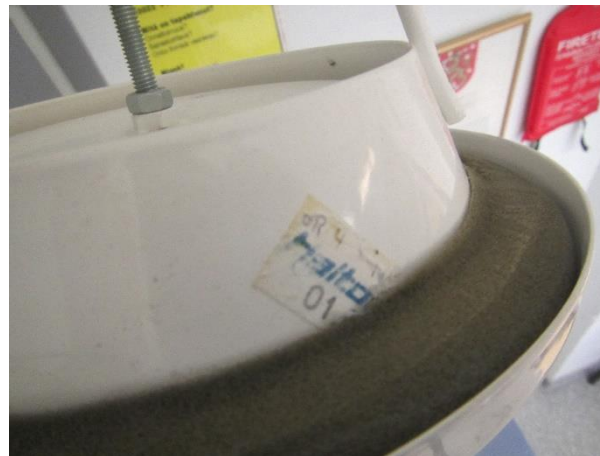
Kuva 45. Poistovenntiili (URH).
