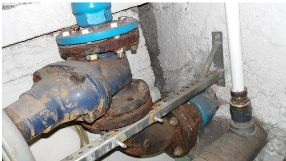
Kuva 10. Tonttivesijohto on muovia.
