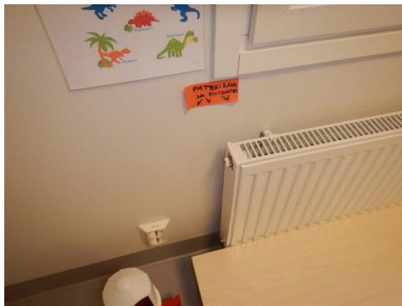
Kuva 5. Pistemäiset vuodot patterikannakkeista ja pistorasiasta.
