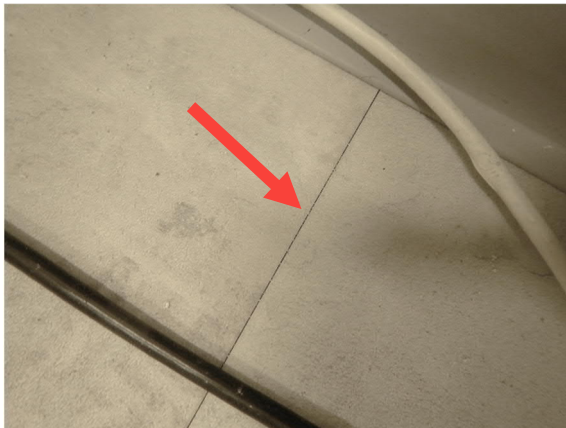
Kuva 12. Lattiamateriaalin saumojen kautta saattaa tulla hyvin vähäistä vuotoa ulkoseinän vieressä. Tutkimuksessa saatiin toistuvia, mutta heikkoja viitteitä.
