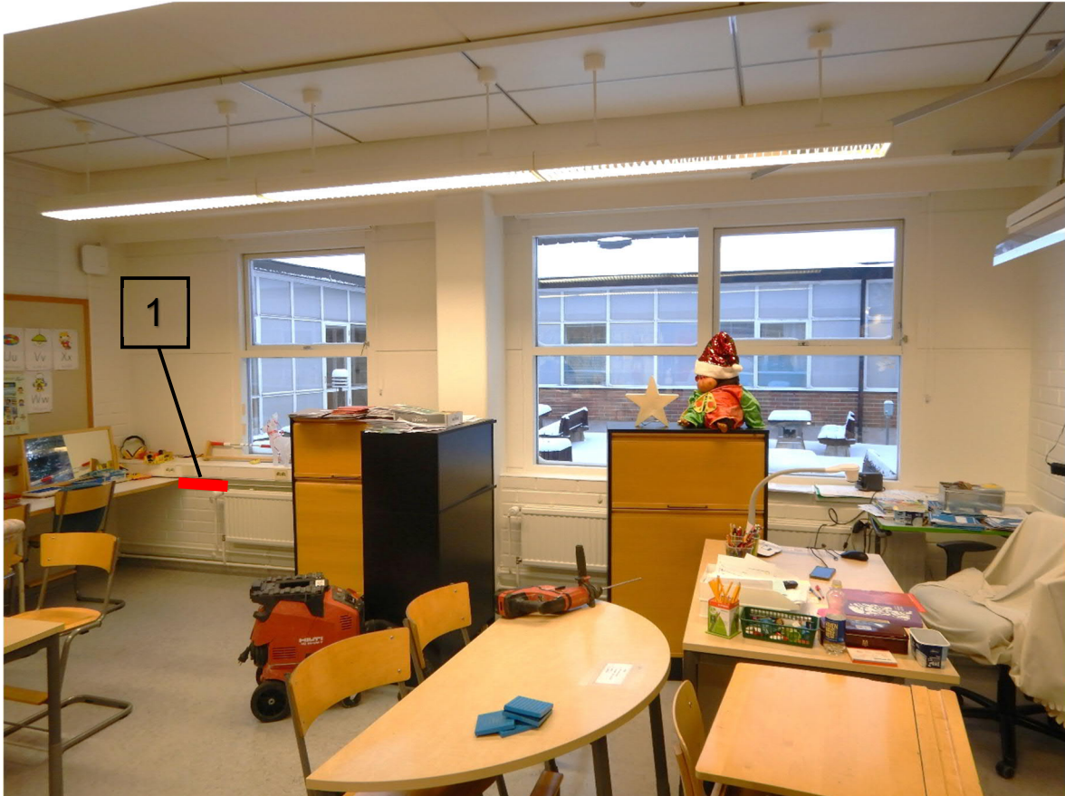
Kuva 3. Havaitut ilmavuotokohdat tilassa 1011.
