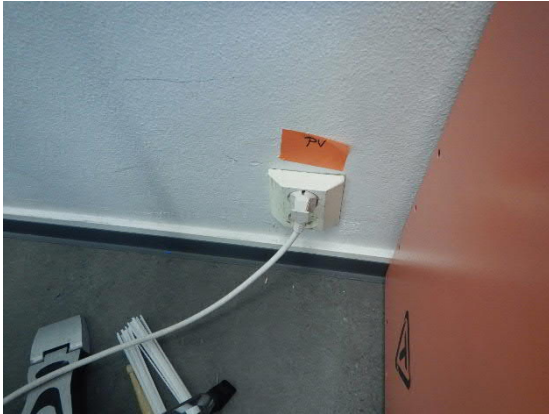
Kuva 4. Pistemäistä vuotoa pistorasiasta (3).
