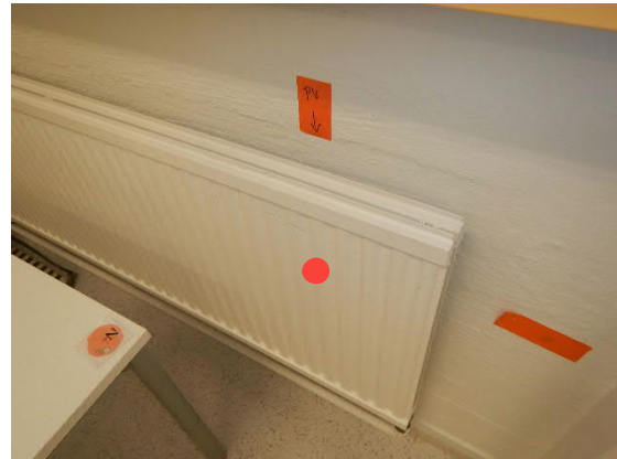
Kuva 24. Pistemäistä vuotoa patterikannakkeesta (4).
