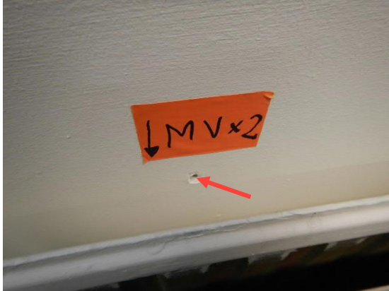
Kuva 35. Merkittävää vuotoa patterikannakkeen vanhoista rei'istä 2 kpl (2).
