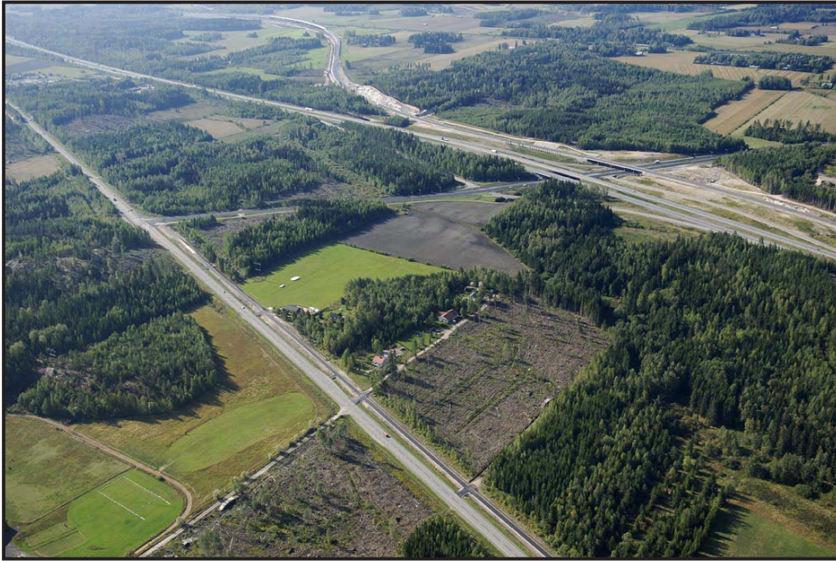
Kuva 5: VIISTOILMAKUVA SUUNNITTELUALUEELTA (POHJOISESTA)
