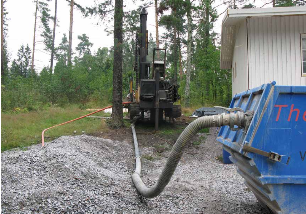
Kuva 20. Porauspöly kannattaa kerätä talteen. (Kuva: Janne Juvonen)
