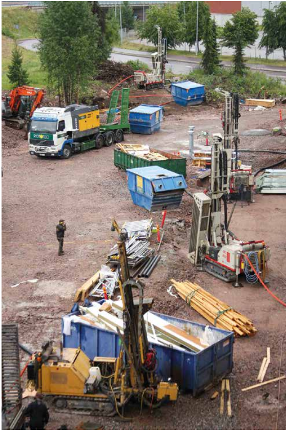
Kuva 10. Suurkohteessa työmaajärjestelyt on tehtävä taiten (Kuva: Jouni Salakari).
