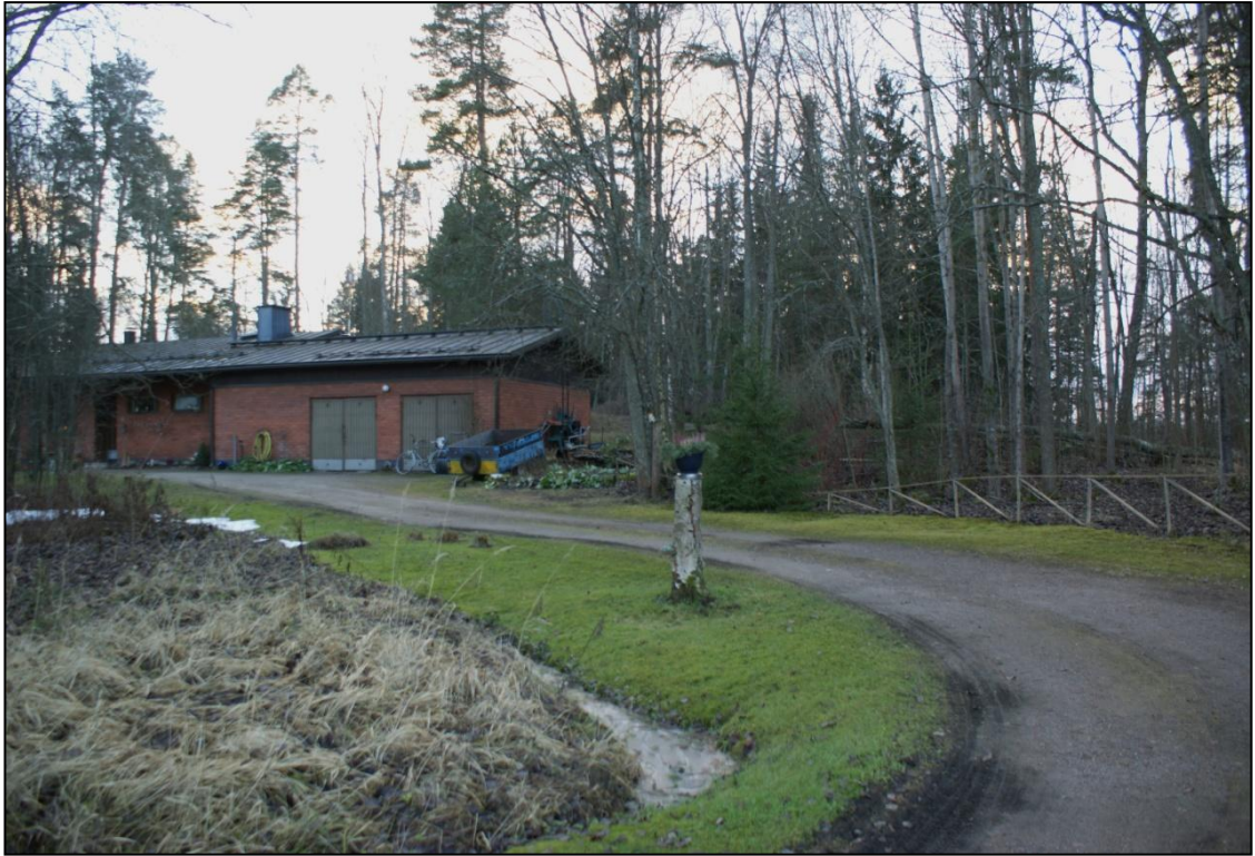
Kuva 18. Kunnan maalla oleva omakotitalo.
