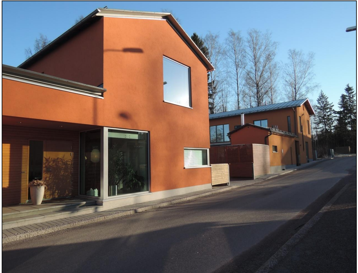
Kuva 26. Maantasossa oleva kadulle suunnattu suuri ikkuna.
