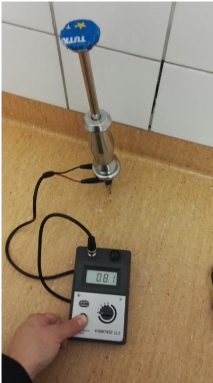
Kuva 4. Carita Larjovuori suorittamassa WC:n lattian kosteusmittausta 12.5.2017.
