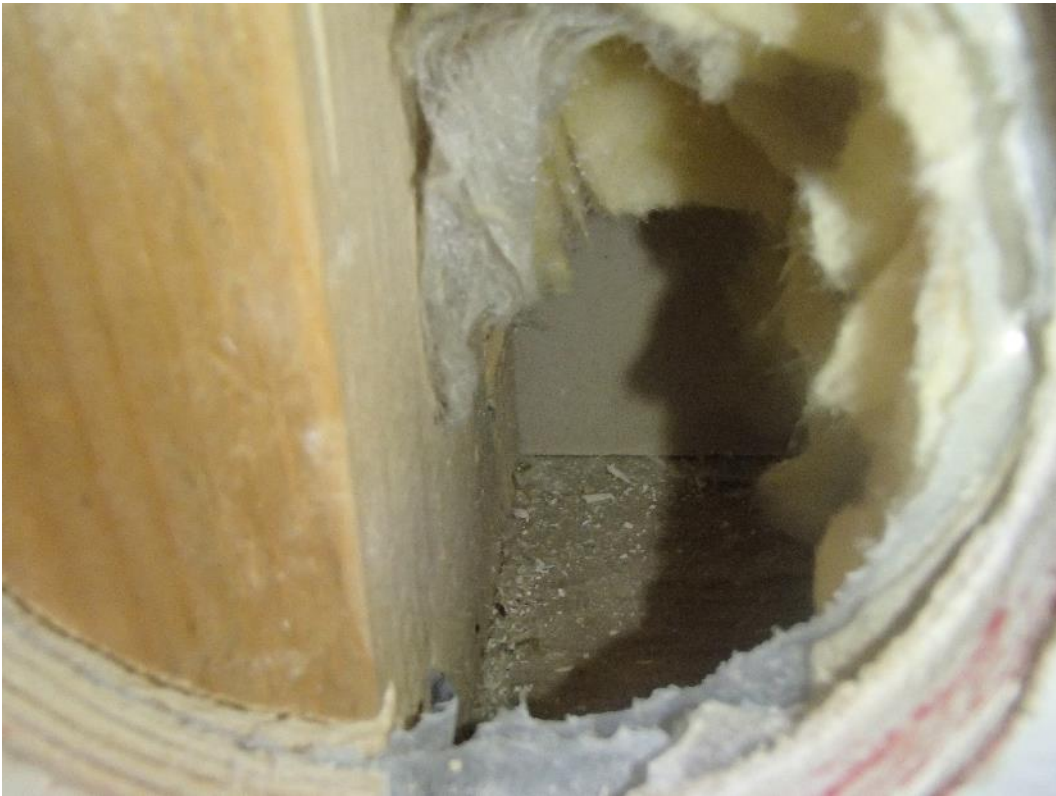
Kuva 5. Rakenneavauskohdassa RAKS3 ei aistinvaraisesti havaittu vaurioita.
