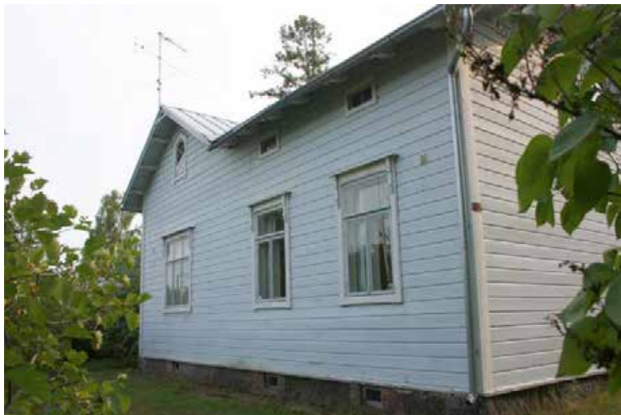
182 Asemapäällikön talon itäjulkisivu.
