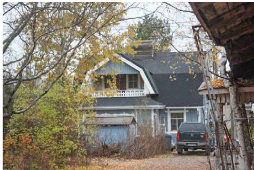
191Ä Siljalantie 19a.
