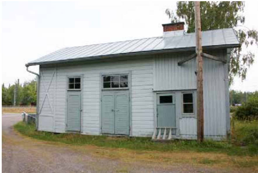
182A Asemapäällikön talon piharakennus pohjoisesta.
