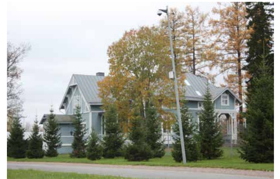
175 Sininen huvila pohjoisesta.
