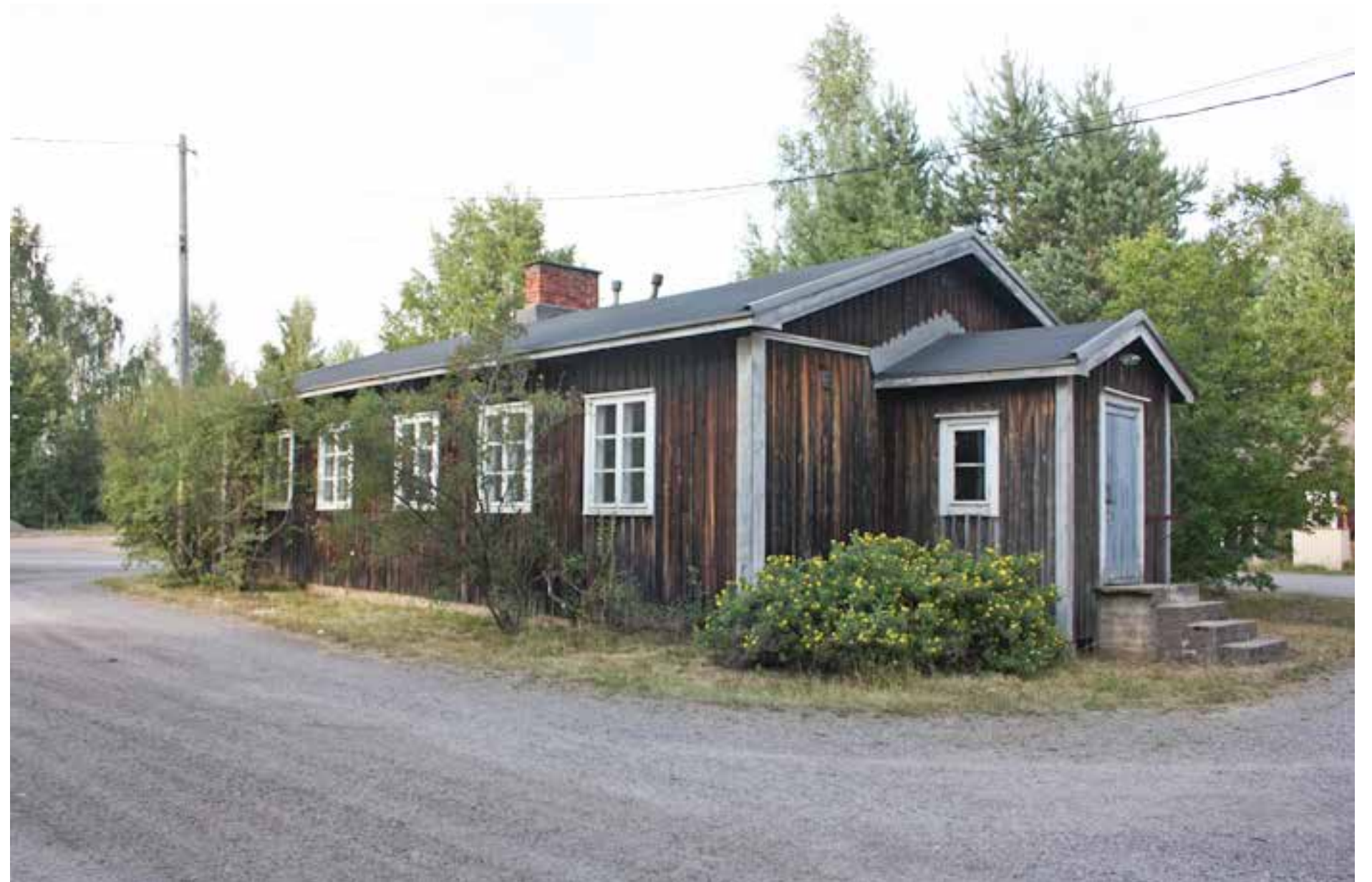
176A Tiilitehtaan ruokala pohjoisesta.
