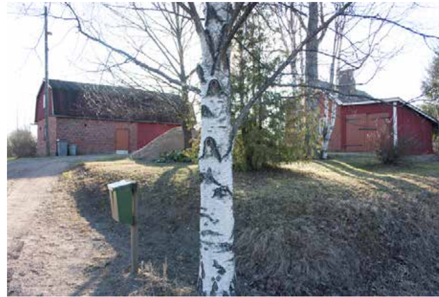
191 Z Vaihdemiehentie 6 eli Rauhalan tiilirakenteinen ulkorakennus ja 191 V pihasauna.
