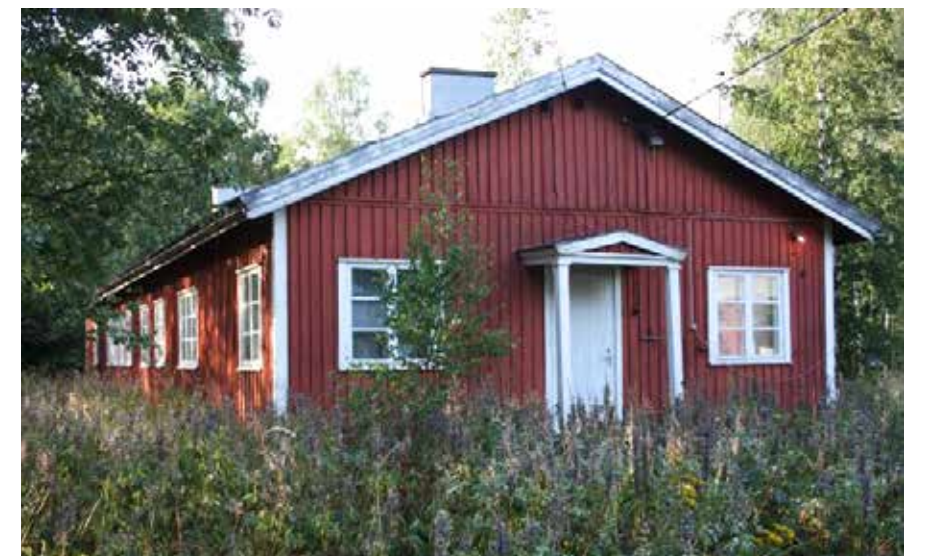
179C Elementtirakenteinen toimisto- ja taukorakennus.
