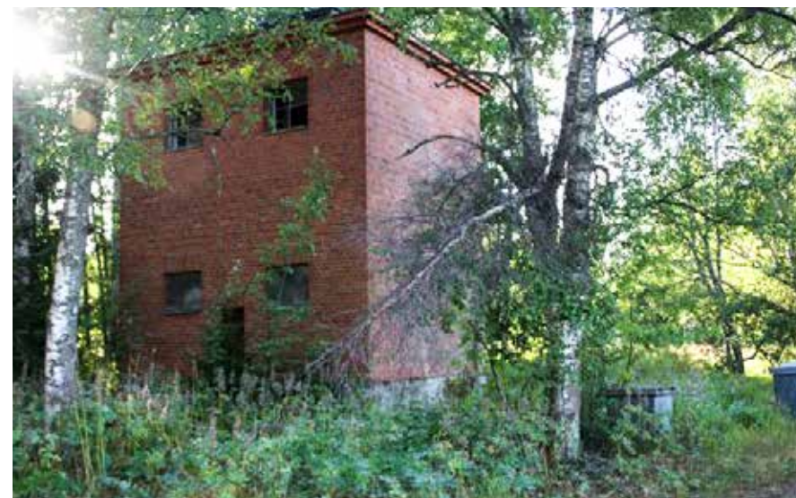
179D Laatikkotehtaan muuntamorakennus.
