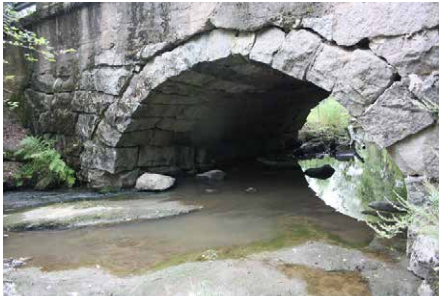
191 Siljalantien silta eli Rämäkosken silta alkuperäisessä asussaan. Silta on uudistettu täysin 2011.
