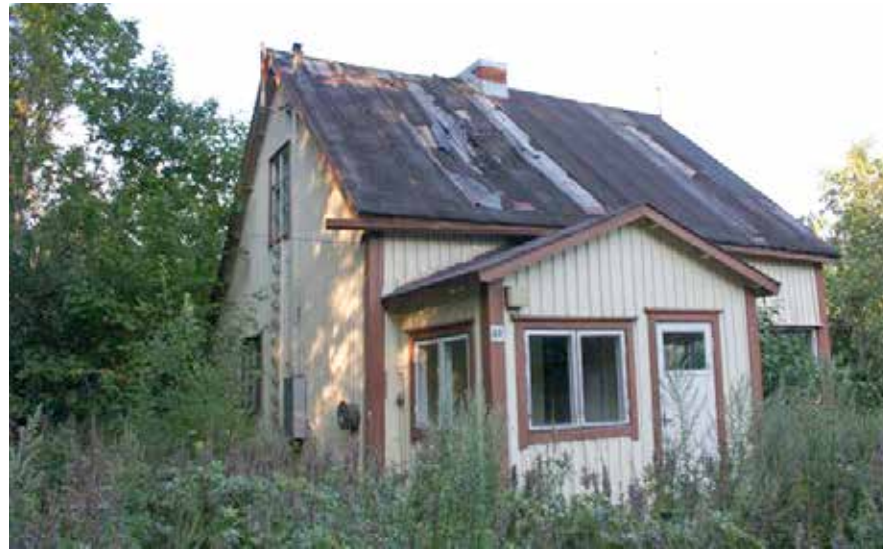
183B Laatikkotehtaantie 48 on autio ja huonossa kunnossa.
