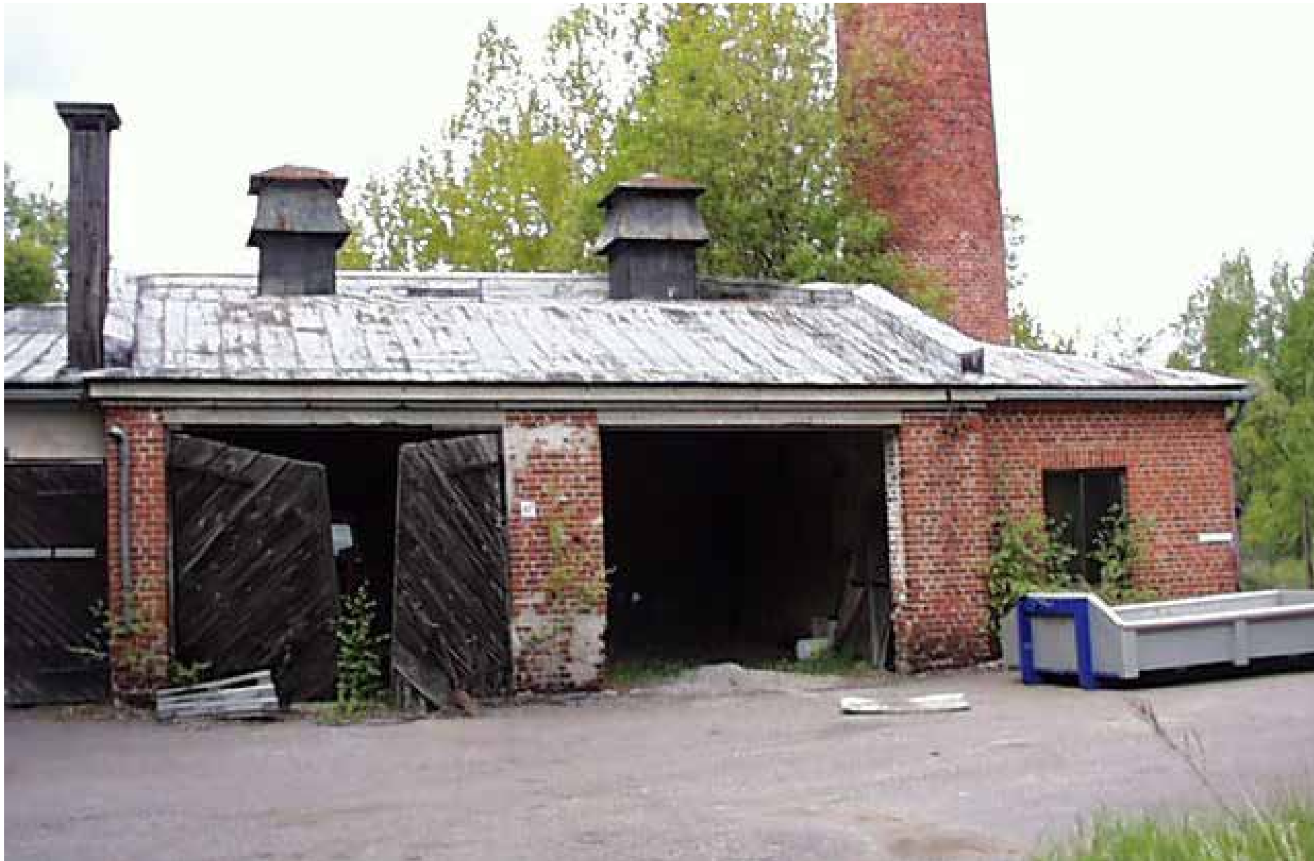
179 E Laatikkotehtaan lämpökeskus PS.
