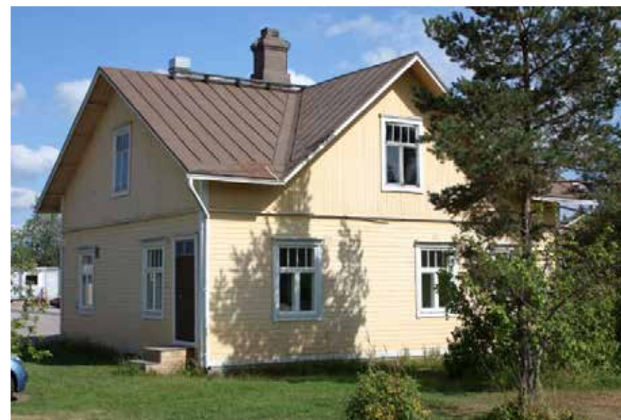
193A Lepolan tilan vanha päärakennus.
