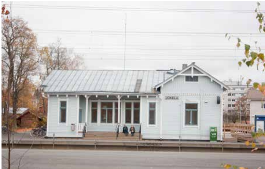
185 Jokelan aseman pääjulkisivu. Lipputanko poikkipäädyn huipusta puutuu.
