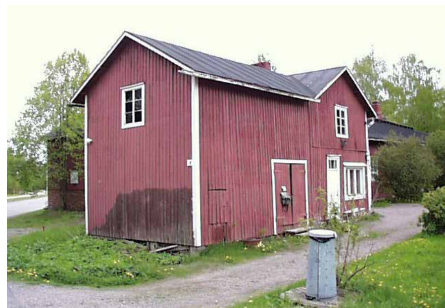
178 B Tiilitehtaan konttorin ulkorakennus PS.
