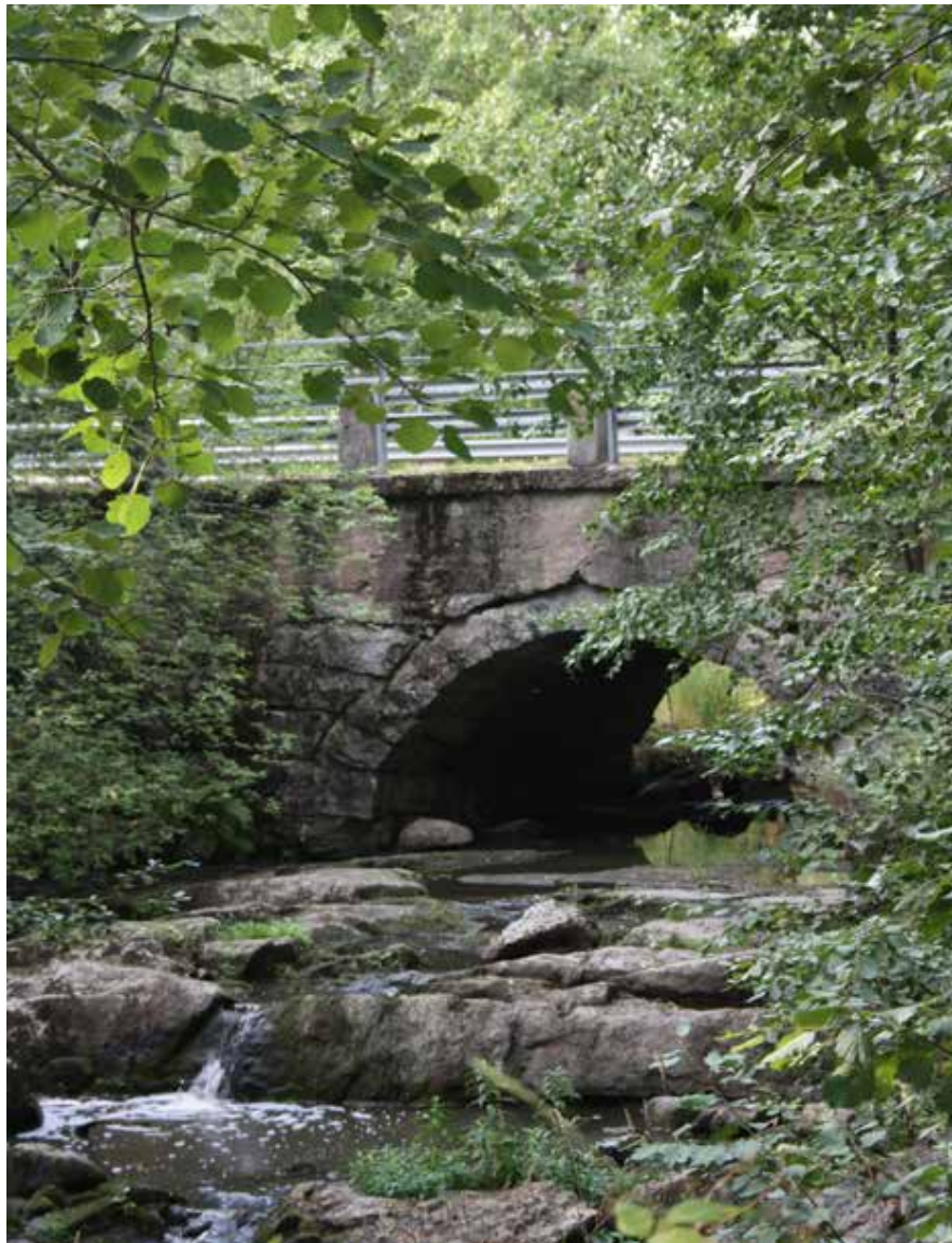
191 Rämäkosken silta Palojoen ylitse. Siltaa on vahvistettu betonoimilla.
