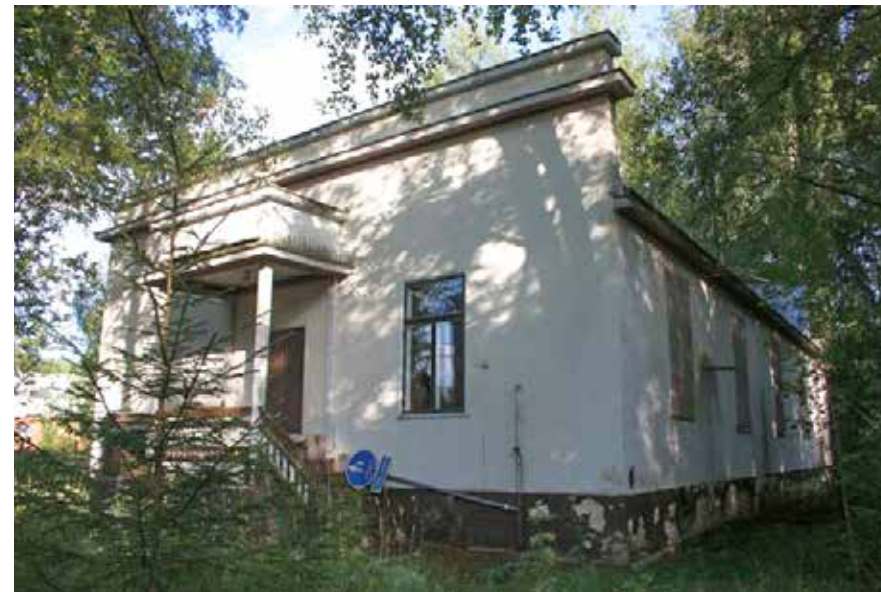
180 Laatikkotehtaan konttorin pohjoispääty ja länsijulkisivu.
