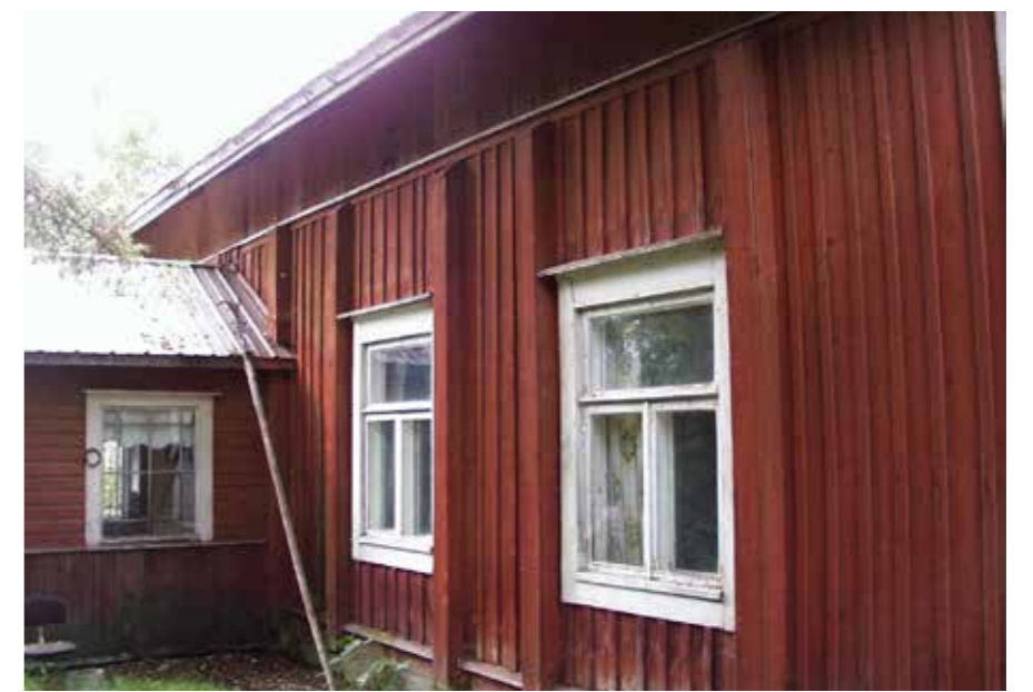
118 Laurin julkisivu ennen kunnostustöitä vuonna 2005. PS.
