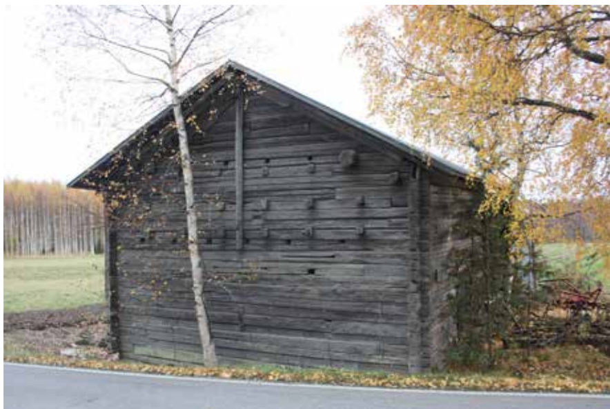
122B Kaukon riihi latoineen.
