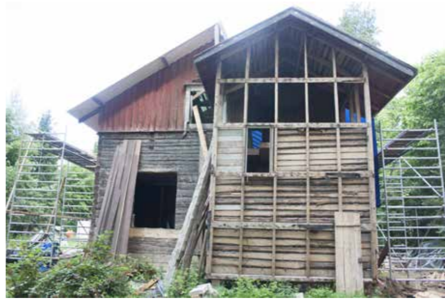
118 Laurin eteläpäädyn kaksikerroksista porrashuonekuistia on purettu rankaan asti.
