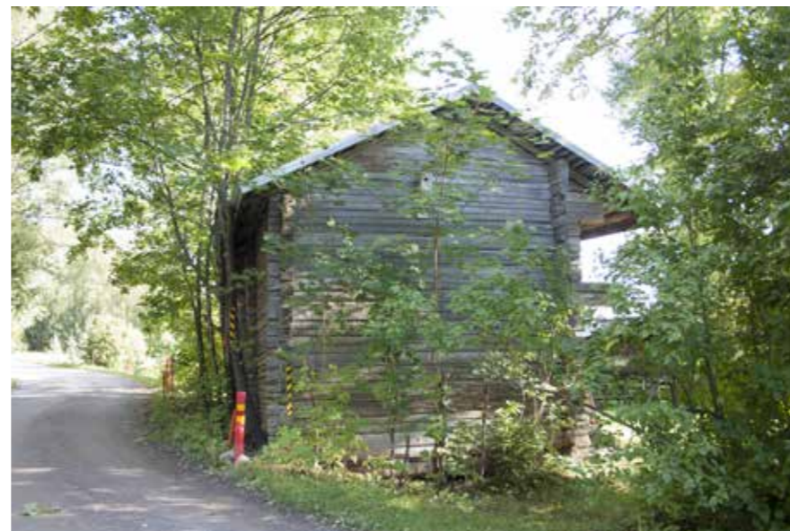
110A Marjalan aitan pääty.
