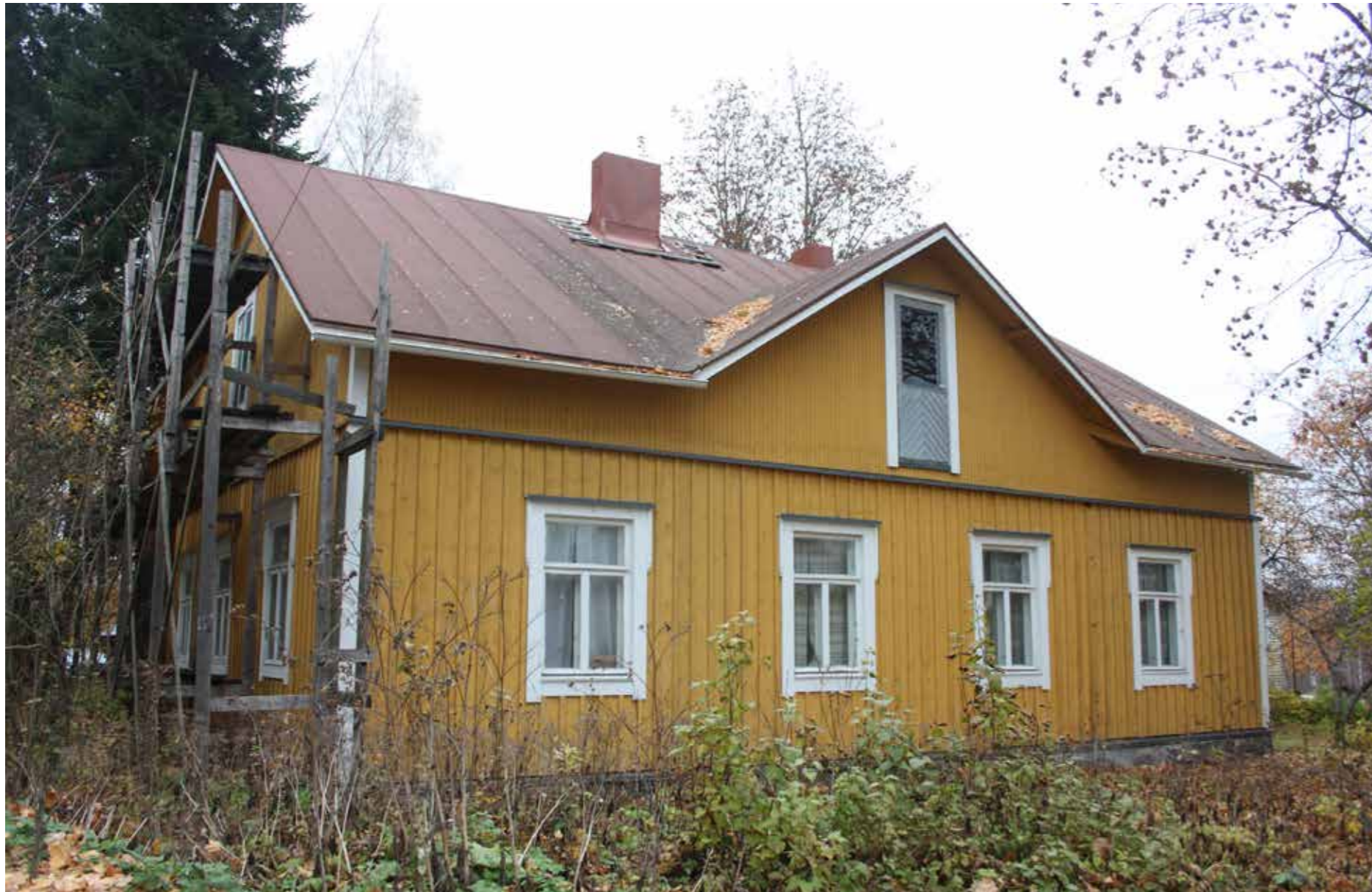
122 Kaukon päärakennus kunnostuksen jälkeen lännestä.
