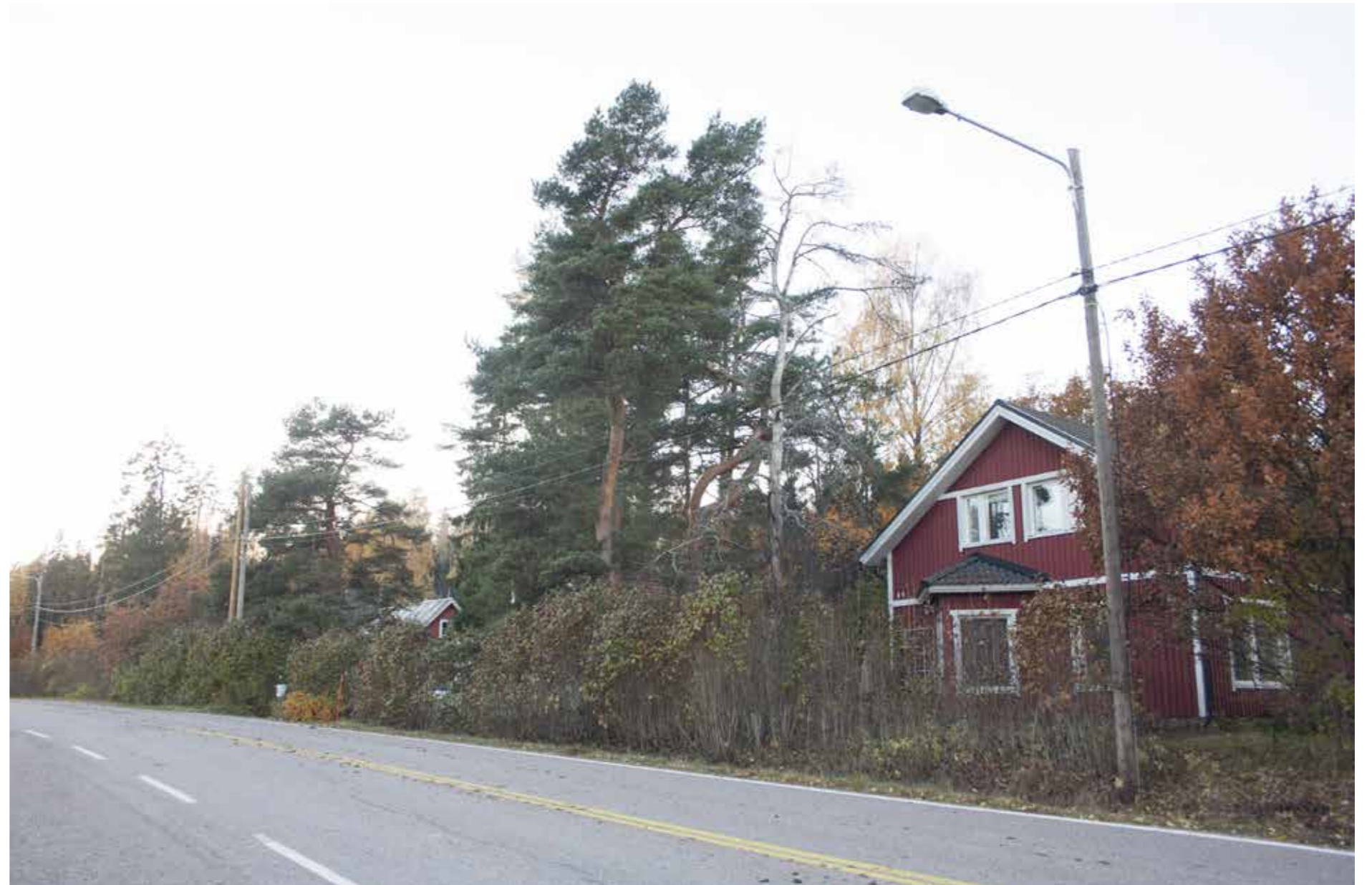
116K Kotimäen vanha asuinrakennus on vasemmalla; asutus on vanhalla peltomaalla.
