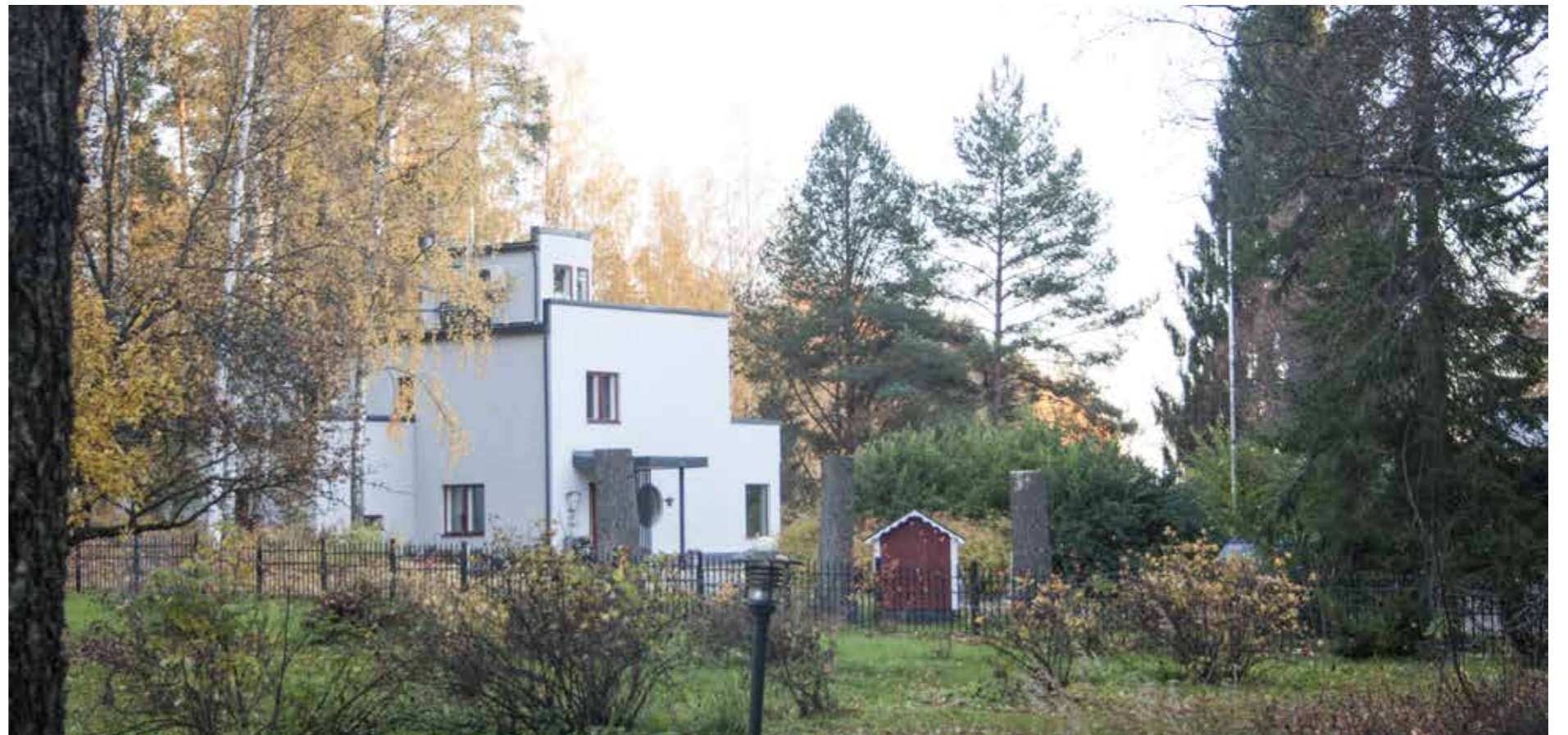
117D Valkaman uudelleenrakennettu funkishuvila.
