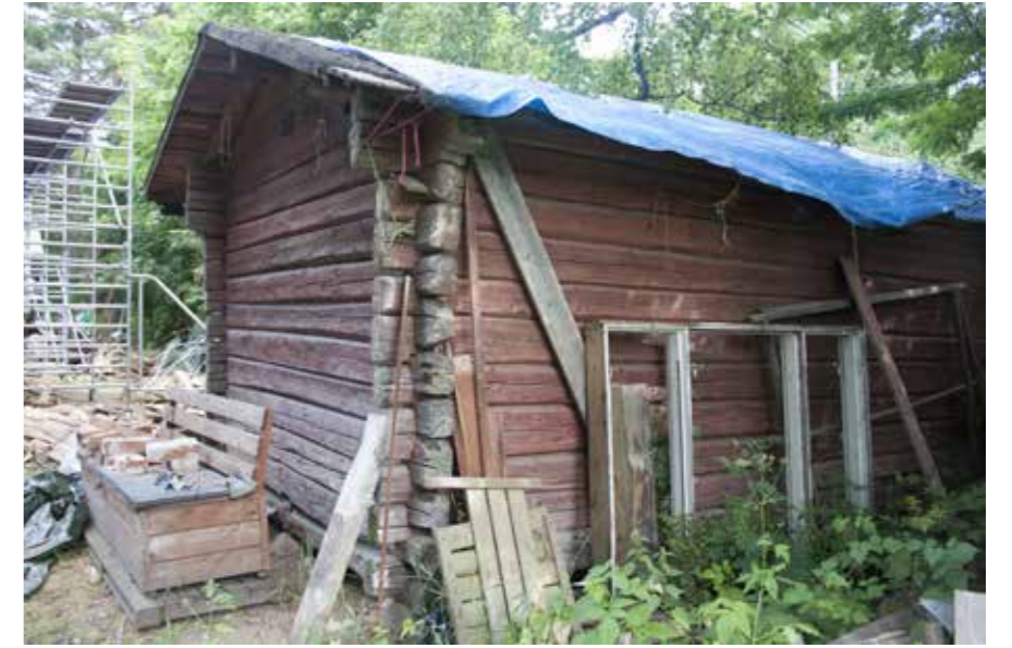
118A Laurin aitta 2012 kesken kunnostustöiden.
