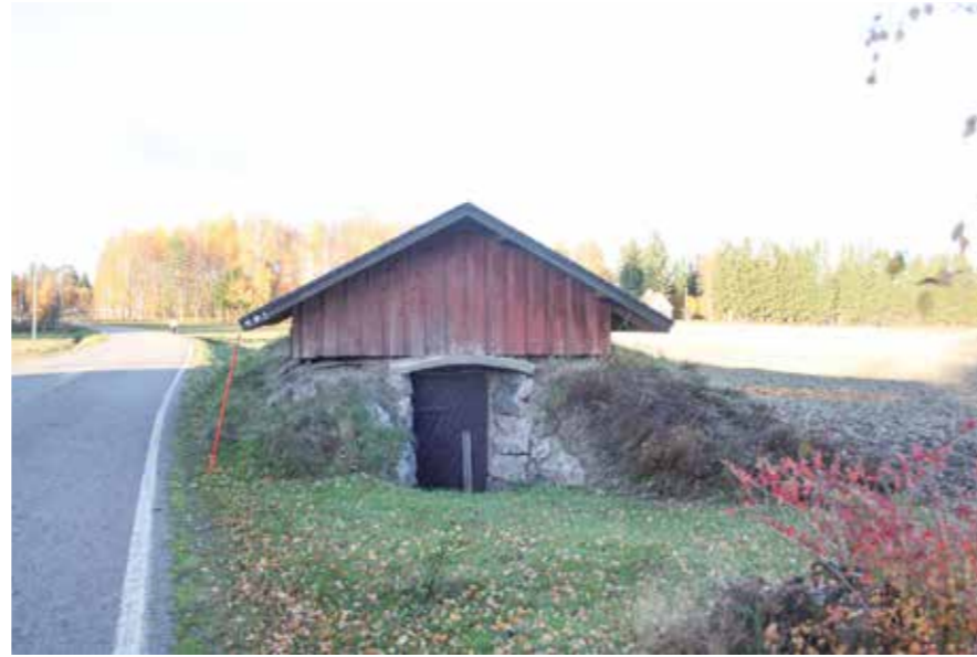
223B Katilan kivrakenteinen perunakellari.
