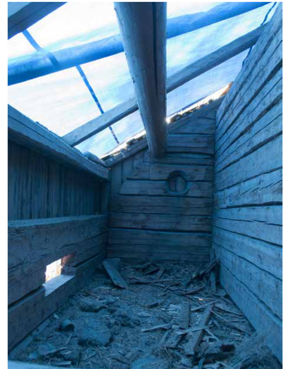
118 Laurin ullakko kesällä 2012. Taitekattoa on korotettu räystäältä viimeistään 1900-luvun alussa harjakatoksi. Huomaa päädyn hirsiseinän pyöreä ikkuna ja päätyseinän pyöreähkö profiili
