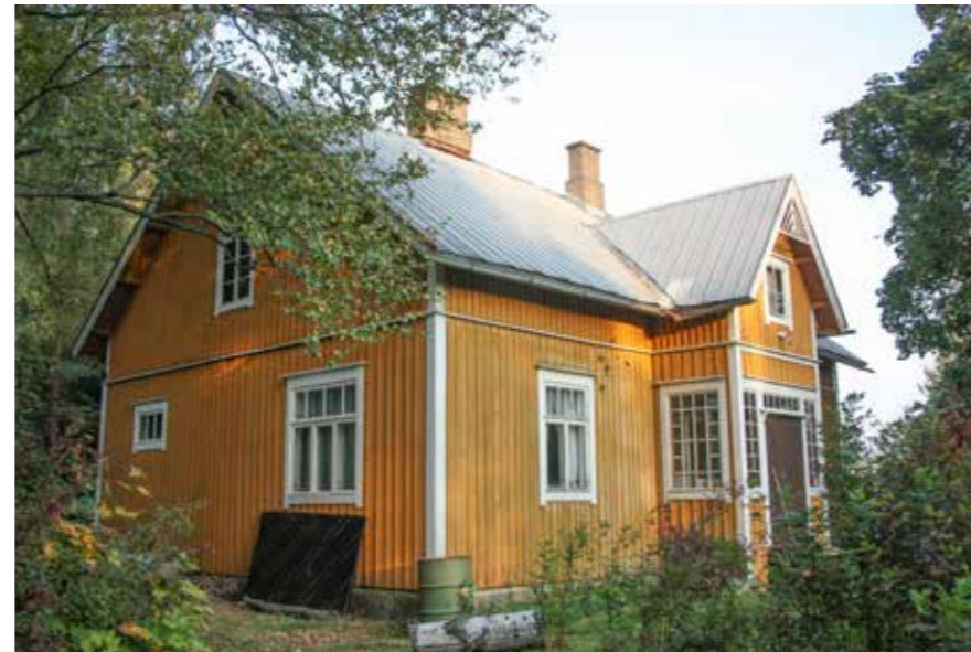
105D Lepomäen päärakennus.
