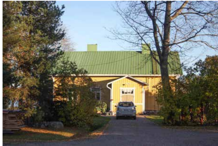
223 Katilan päärakennus pihatien päästä nähtynä. Pieni umpikuisti noudattaa vanhaa jäsentelyä: ikkunat oven päällä.
