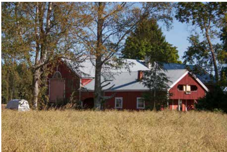
115A Päivölän navetta ja aittarakennus.
