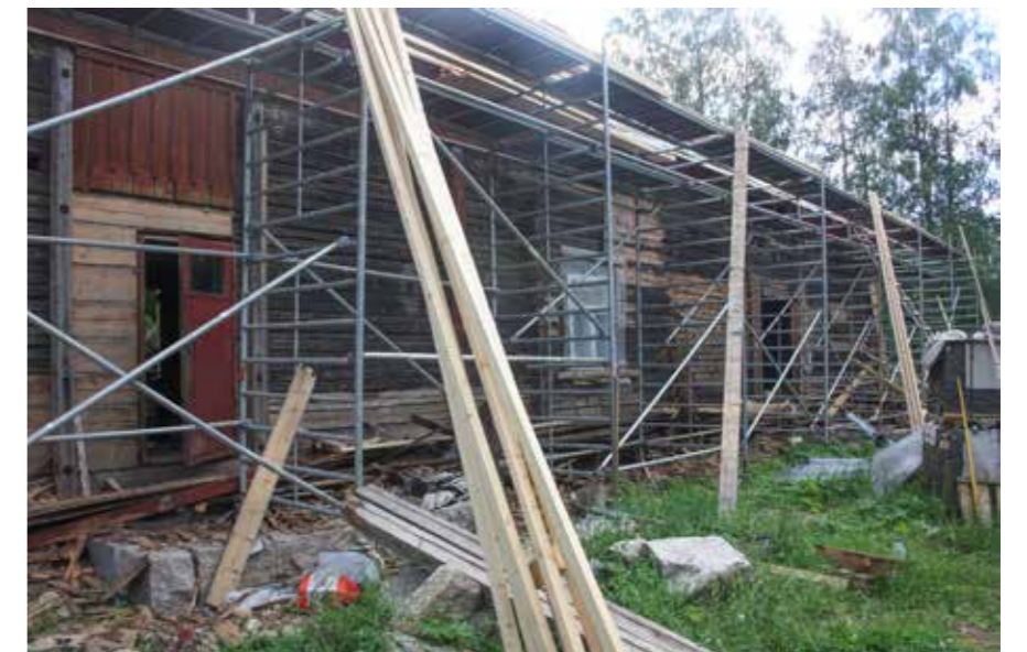
118 Laurin sisäpihanpuolta hirsipaikkauksia tehty.
