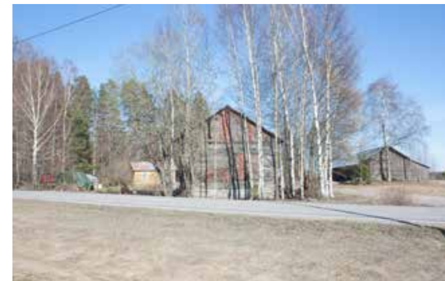
Fram-Vesterbyn mökki 1F ja riihi 1E on purettu ja korvattu uusilla rakennuksilla, oikealla näkyvä Bak-Vesterbyn riihi on vielä jäljellä.
