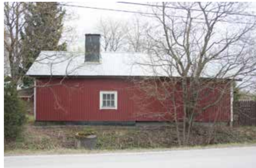
18I Åbackan sauna- ja kärryvajarakennus tien varrella.
