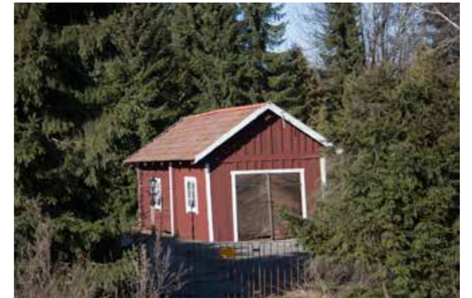
20H Jussilan pihavaja ja autotalli muodostuu vanhasta hirsikehikosta ja uudisosasta.
