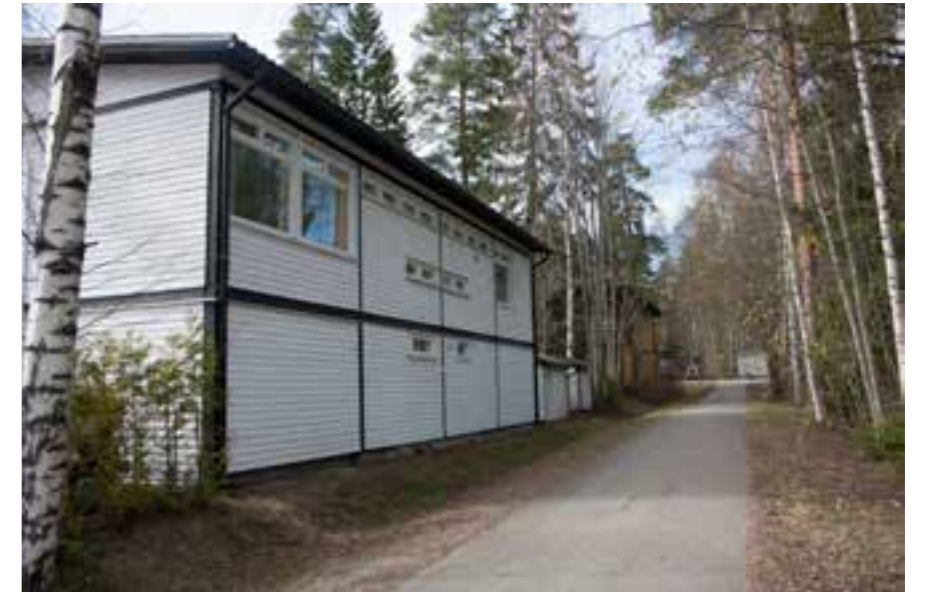
41 Sinivuokontie 8, kaksikerroksinen kokonsa ja muotonsa säilyttänyt, Bungalow-talo takapuolelta. Ainoastaan tasakatto on korvattu harjakatolla vuonna 1998.
