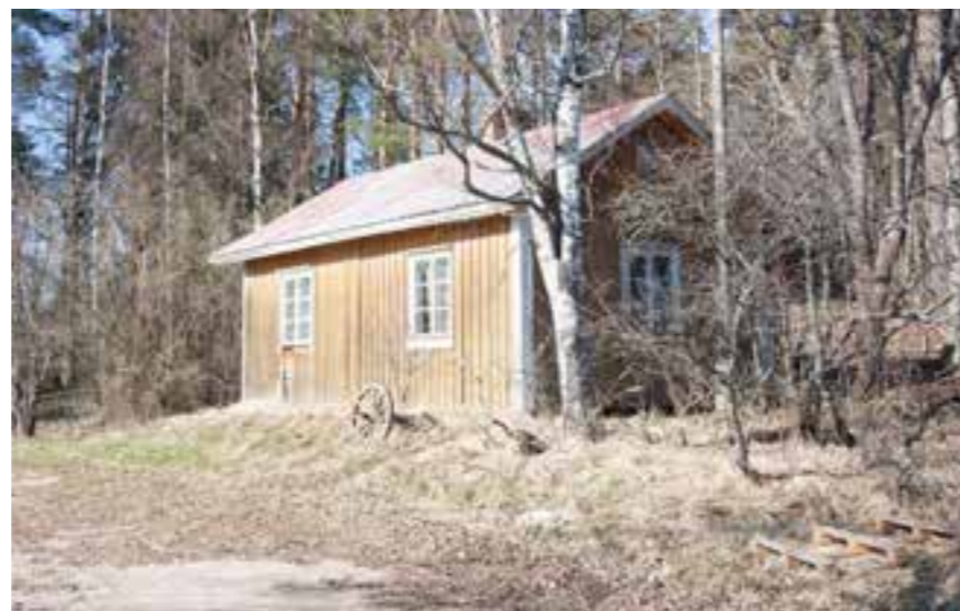
Fram-Vesterbyn mökki 1F on purettu ja korvattu uudisrakennuksella.
