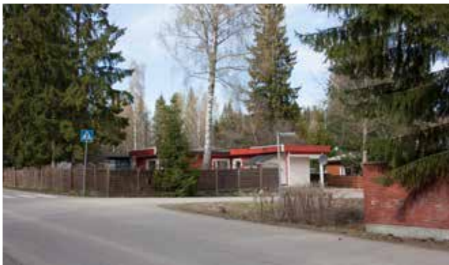
41 Sinivuokontie 2 on edelleen tasakattoinen, mutta julkisivut on muutettu täysin alkuperäisestä poikkeavaksi niin ikkunajaoltaan, jäsentelyltään kuin väritykseltään.
