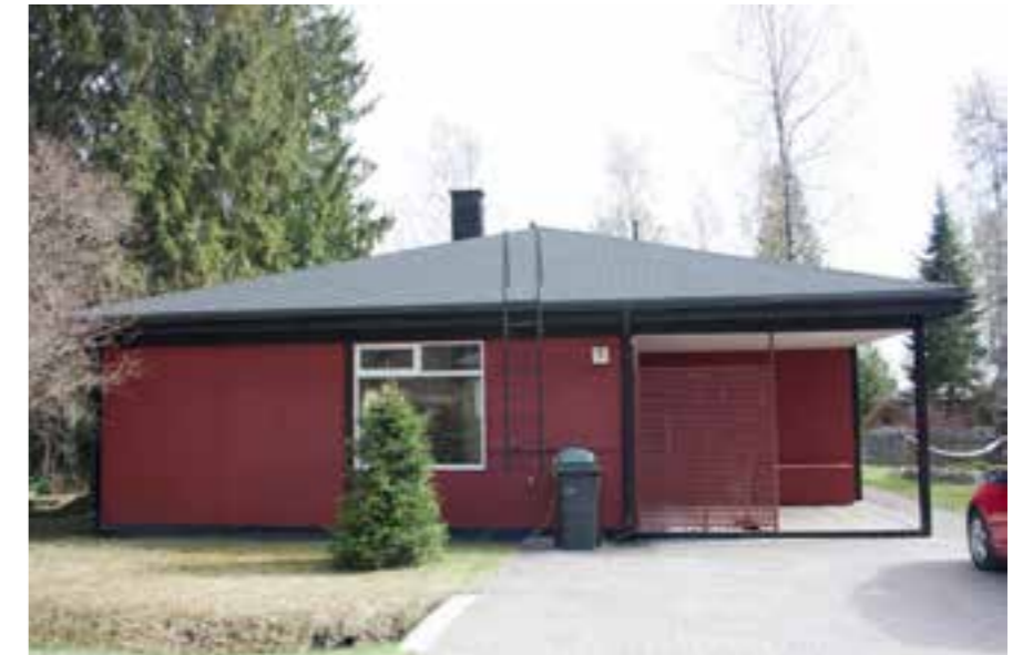
41. Kanervatie 5:n pieni Bungalow-talo on säilyttänyt laajuutensa, arkkitehtoniset julkisivudetaljinsa ja muotonsa hyvin - pieni laajennus on tehty takapihan puolelle ja tasakatto on korvattu aumakatolla.
