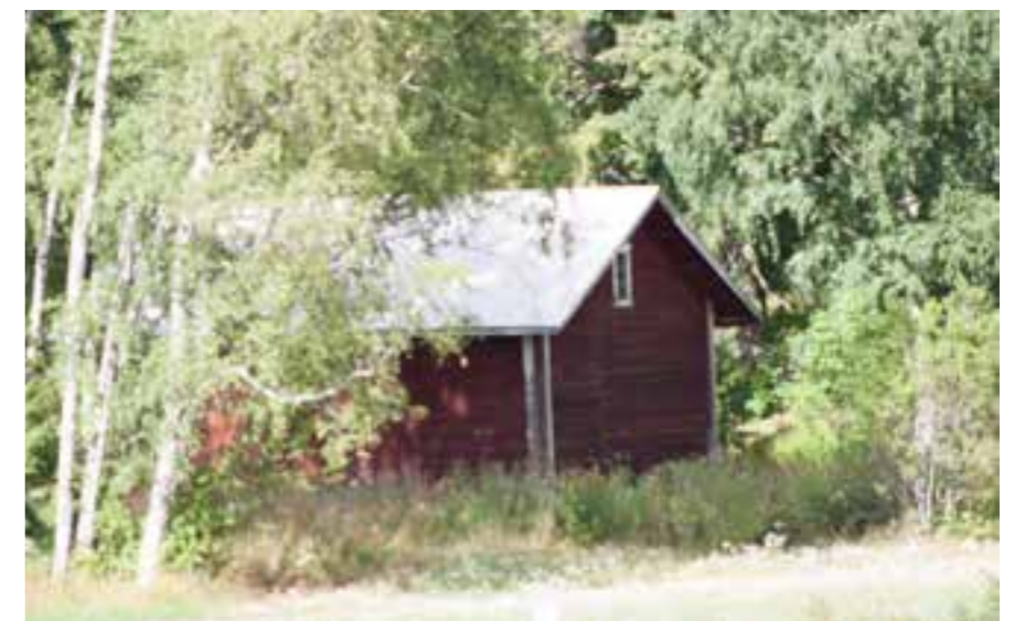
10D Väfvarsin pitkänurkkainen ja kaksikerroksinen vilja-aitta.
