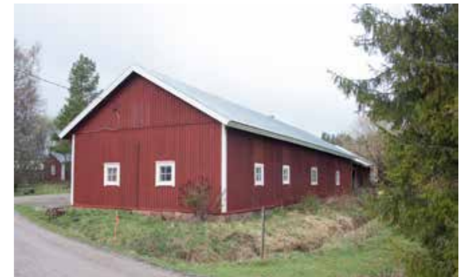
12A Nedre-Gummin navetta takapuoleltaan ja yhtenäisen lautaverhoiltu seinä.
