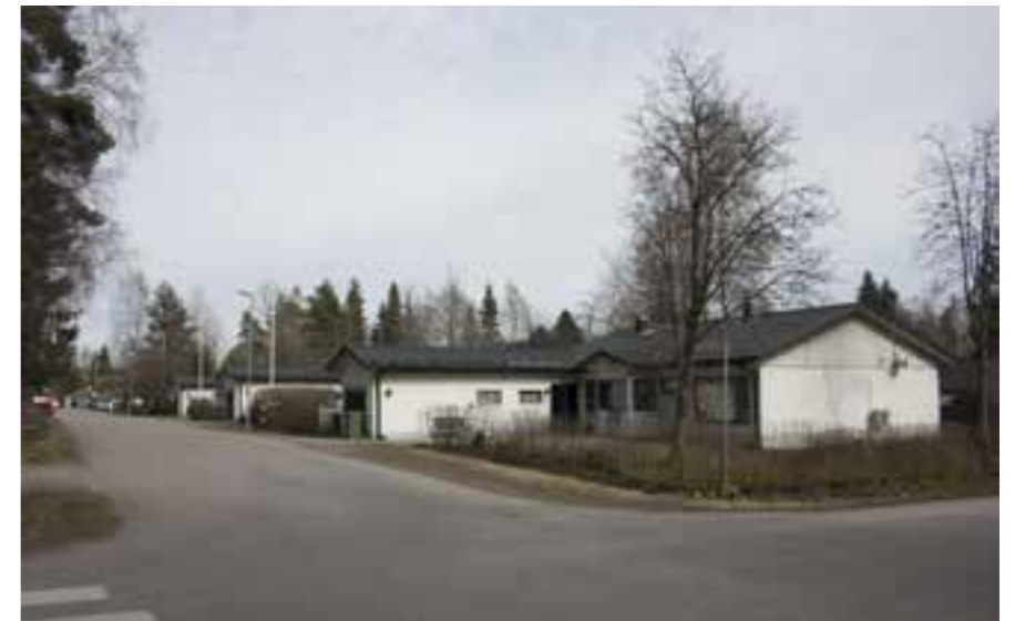
41. Valkovuokontien Pirkka-talojen omakotiversiot ovat kaikki saaneet jo harjakatot ja osaa on myös muutettu hieman mm suurentamalla ikkunoita.
