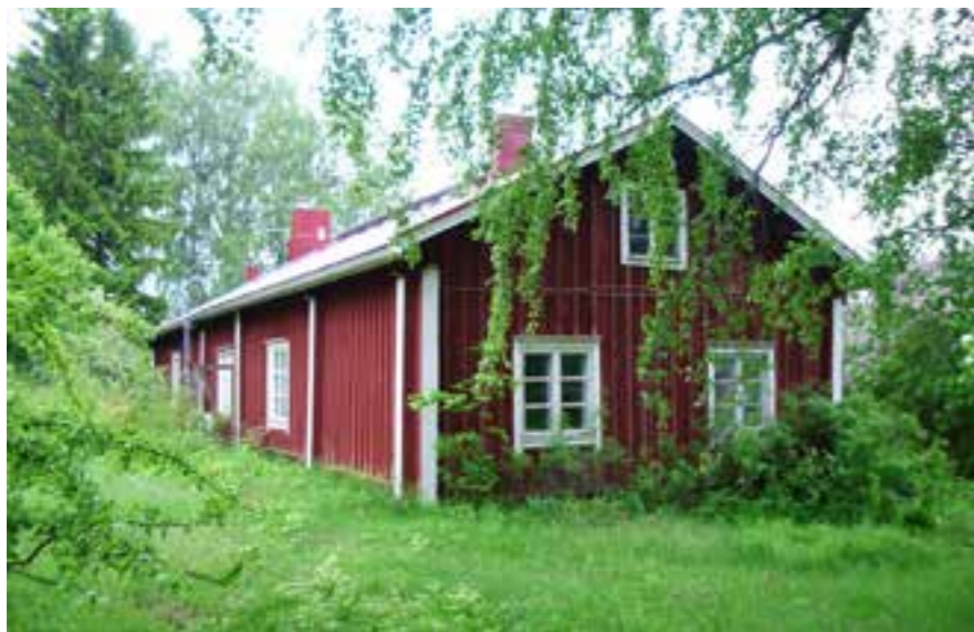
Bak-Vesterbyn päärakennuksen takajulkisivu. PS.
