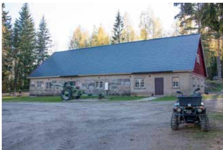
26E Mäkelän kivinavetta, jota on jatkettu betoniosalla.
