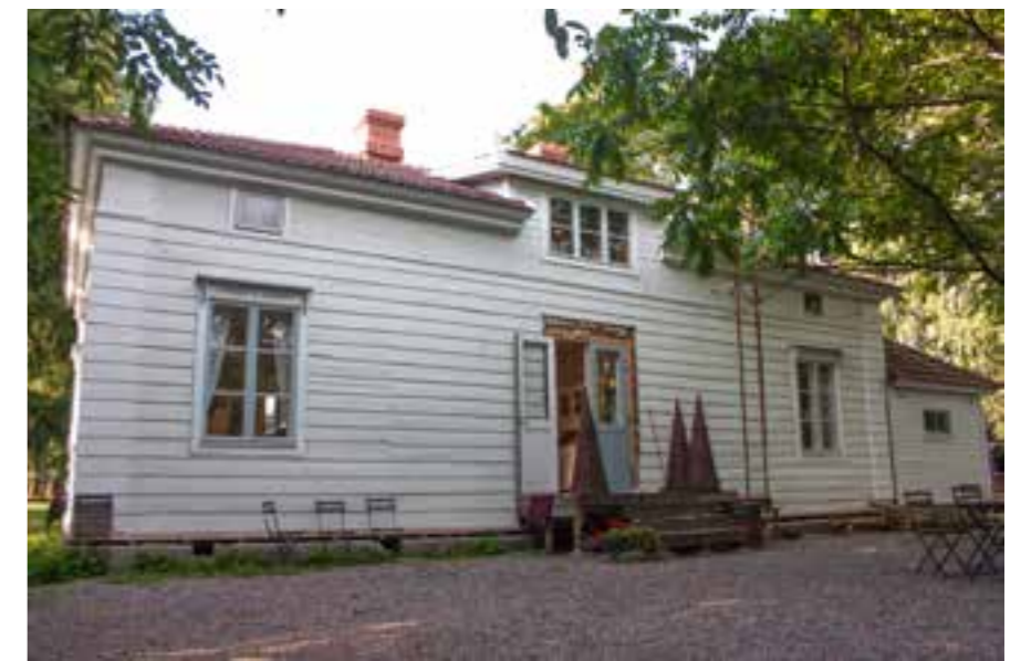
20A Jussilan uusi päärakennus uusi lisäsisäänkäynti puutarhan puolelle.
