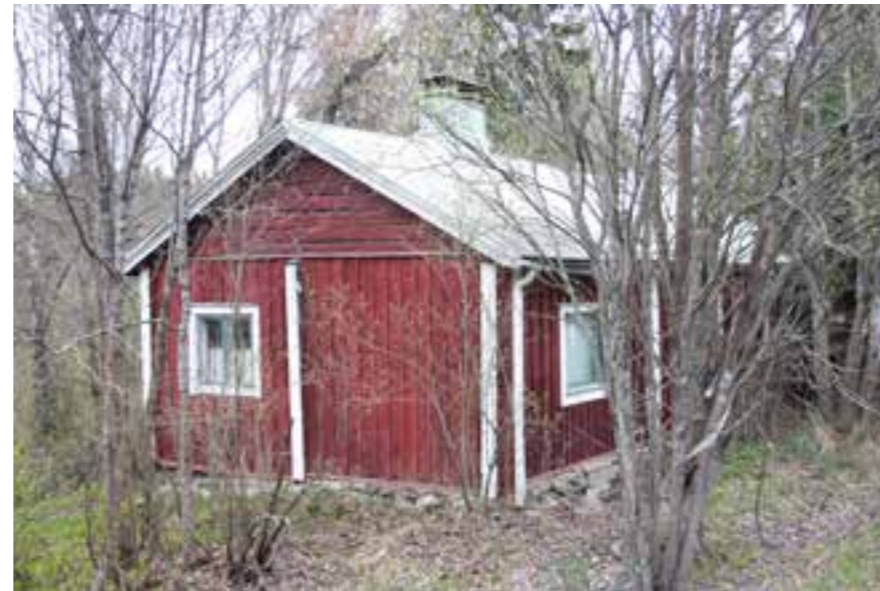
19A Myllytuvan eteläpäätty paljastaa talon olevan iäkäs.
