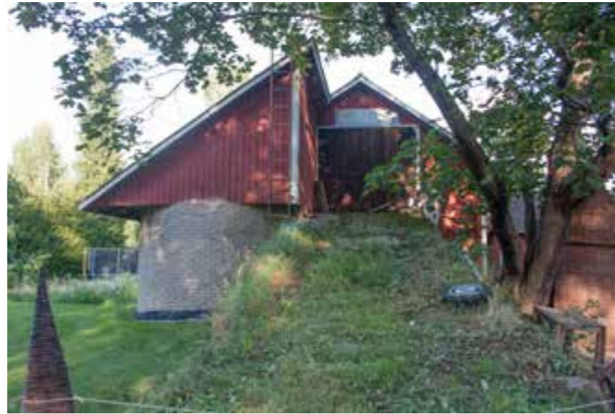
20E Jussilan navetan rehusiilo ja ylisten silta.
