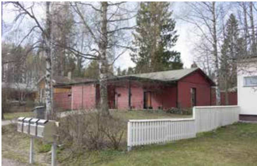
41. Valkovuokontie 6 on toinen Lahelan messualueelle rakennettu Domino-talo. Yksikerroksinen talo säilyttänyt kaikki arkkitehtoniset piirteensä lukuunottamatta kattoa: tasakatto on vaihdettu harjakatoksi vuonna 1998.
