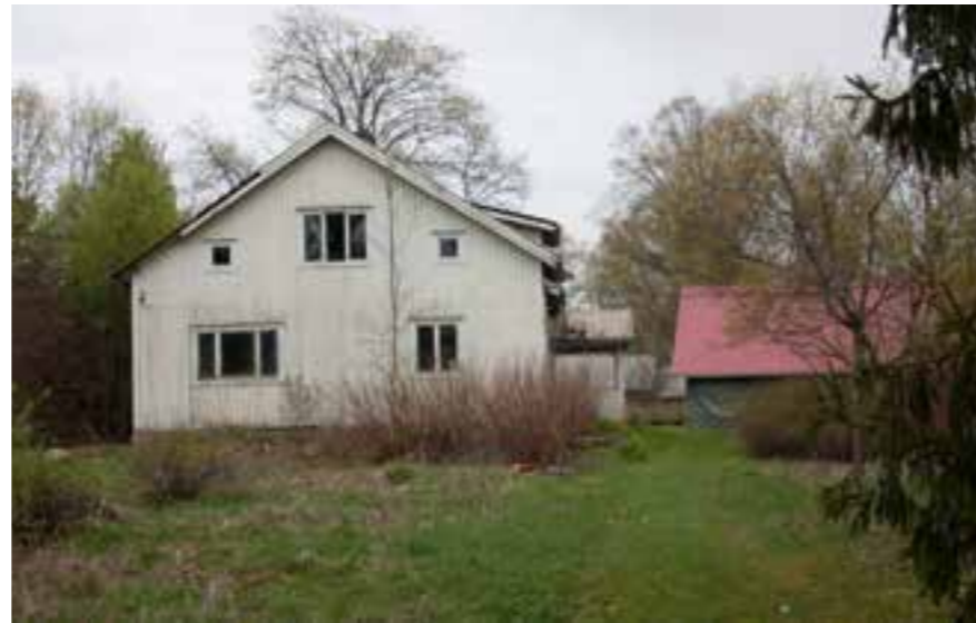
25B Ali-Seppälän asuinrakennus, 25A Tuhkalan aittaa ja 25D Ali-Seppälän liiteri- ja aittarivi.
