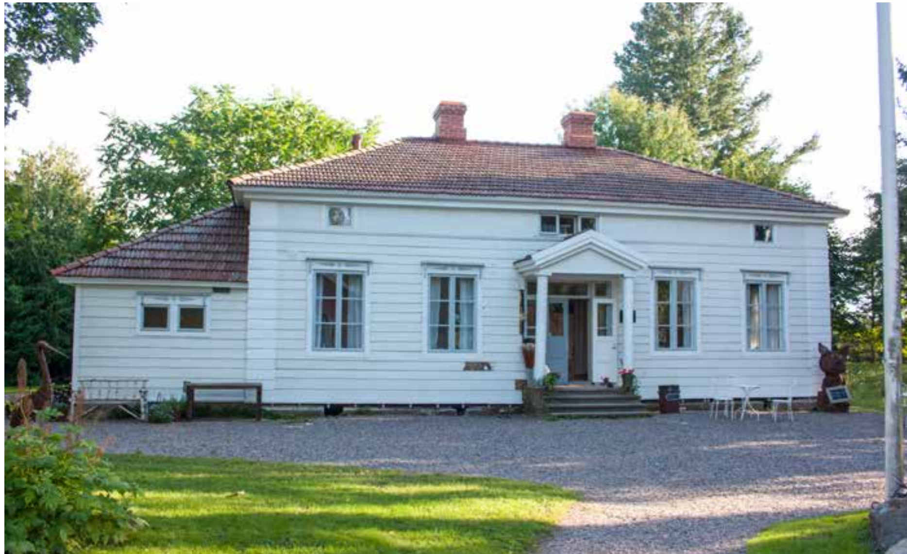
20A Jussilan päärakennus ja pääsisäänkäynti.
