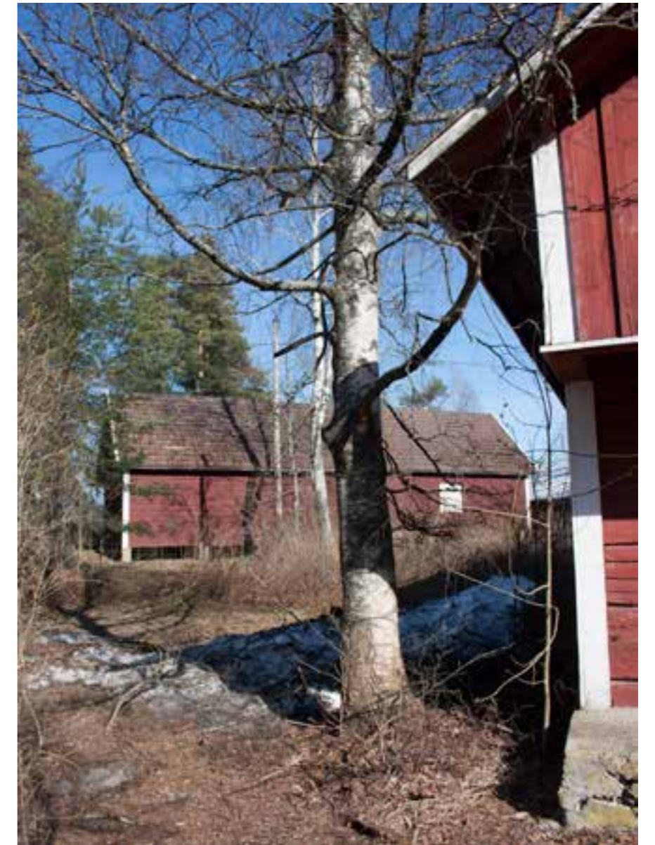
Karlsron aitta ja liiterirakennus 3C Fram-Västerbyn aitan nurkalta kuvattuna.
