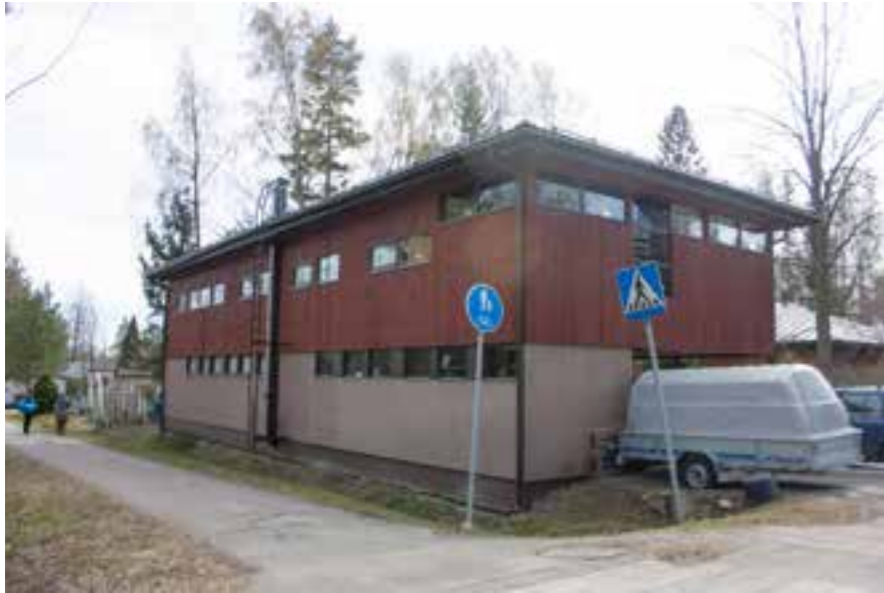
41 Sinivuokontie 7, kaksikerroksinen Domino-talo on saanut uuden, pystyyn asennetun julkisivuverhoilun ja aumakaton. Talon avoin maantasokerros on suljettu ja otettu käyttöön mineriittiverhoilu seinin vuonna 1976 ja harjakatto on rakennettu 1984. Ikkunajako on vielä alkuperäistä tyyliä.
