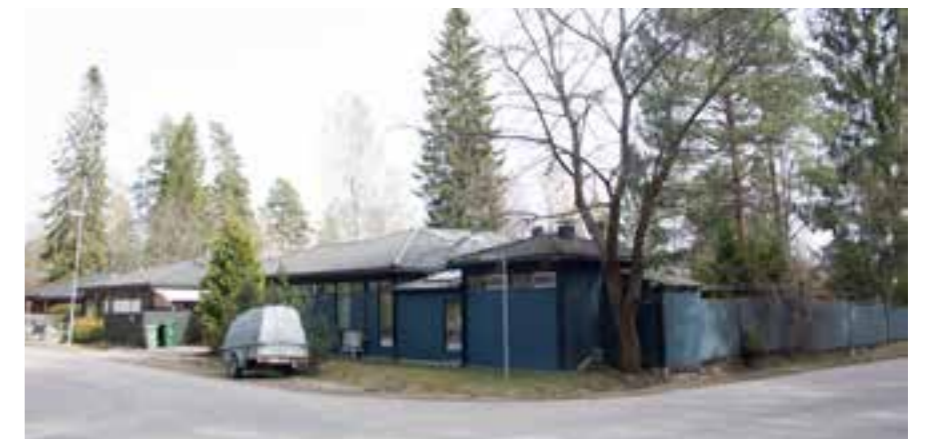
41 Kanervatie 1, yksikerroksinen Bungalow-talo, johon on myöhemmin lisätty erillinen noppamainen lisärakennus ja kulkuyhteys rakennukseen. Kulmatonttia rajaa rakennuksen tyyliä noudatteleva lauta-aita. Tasakatto on muutettu aumakatoksi.
