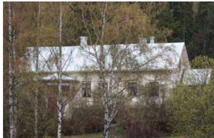
10 Väfvarsin päärakennus piiloutuu pihakoivujen taakse.
