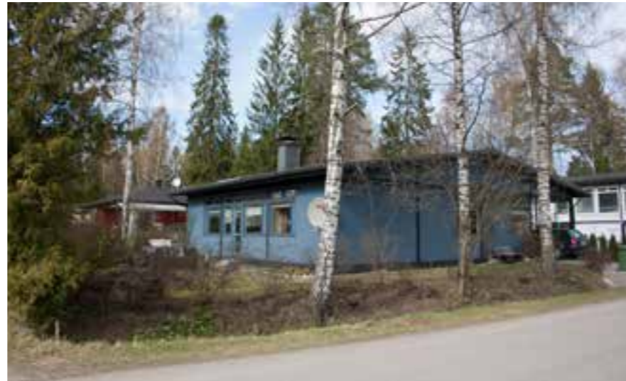
41 Sinivuokontie 6, yksikerroksinen yhdenperheen Bungalow-talo on säilyt- tänyt ominaispiirteensä pääjulkisivuillaan hyvin: laajennus on tehty pihan puolelle jo vuonna 1973 ja harjakatto on lisätty 1990-luvun puolessavälissä.
