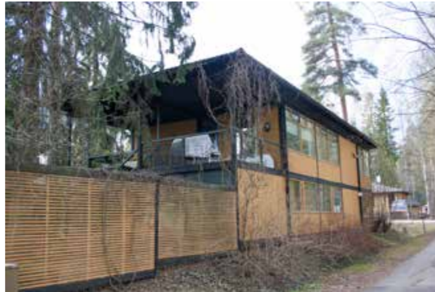
41 Kanervatie 7:n kaksikerroksinen Bungalow-talo on säilyttänyt ulkoasunsa kattomuodon muutosta lukuunottamatta varsin hyvin. Taloa on laajennettu, mutta siten, ettei sitä erityisemmin huomaa.
