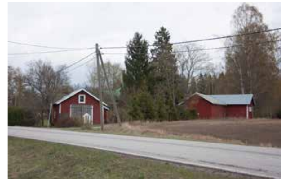
18I Åbackan talousrakennukset rajaavat pihapiirin.
