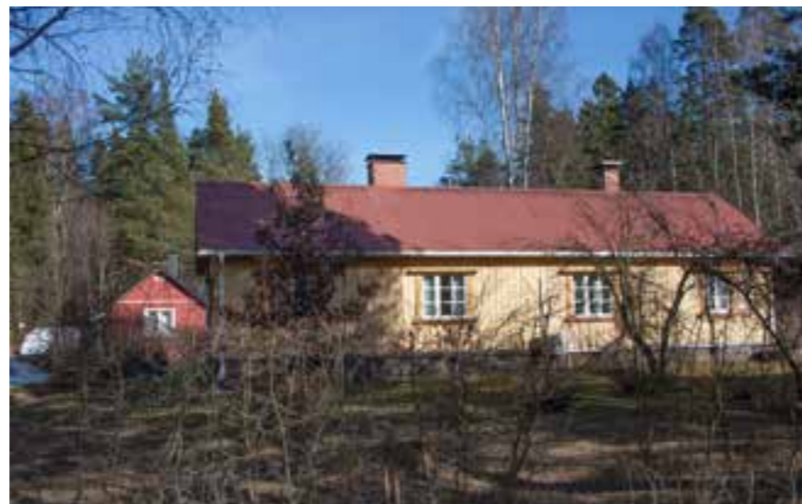
21 Högbegsbackan pitkä ja matala päärakennus.
