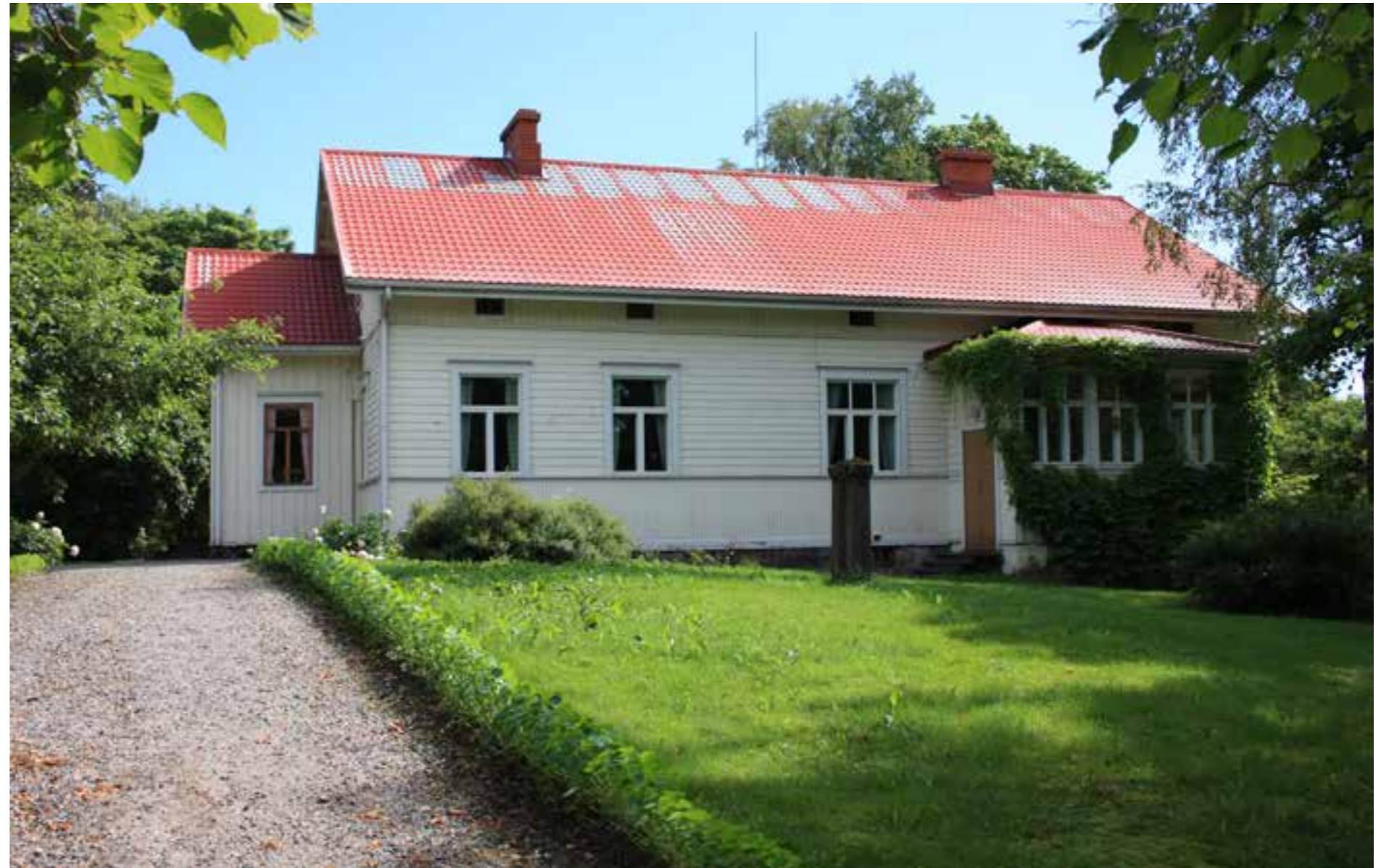
6 Mangsin päärakennus kuisteineen pihan puolelta.
