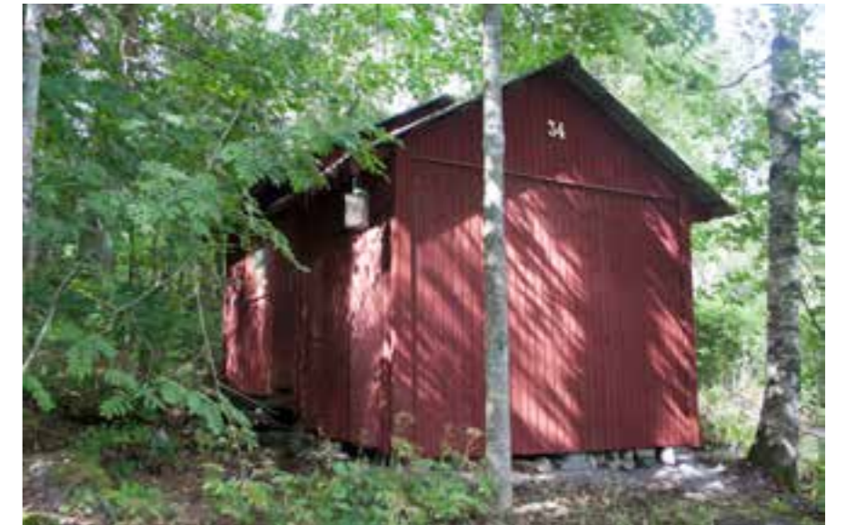
7F Rävkullan osittain uusittu vajakennus. 7F Rävkullan uusi ulkovaja.
