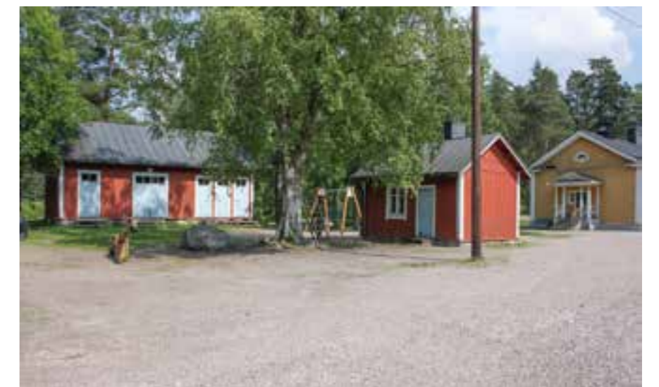
16C Koulun pihavarasto käymälöineen ja 16B opettajan sauna.
