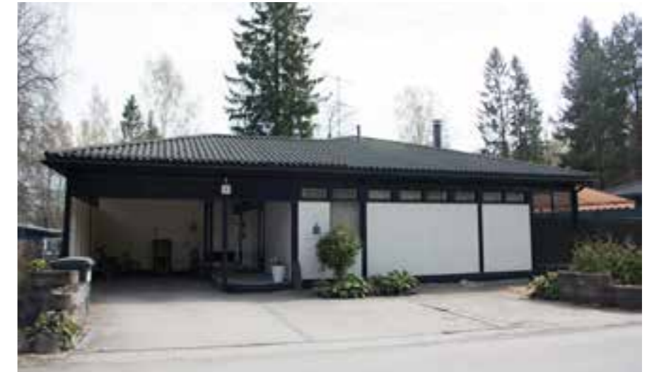
Yksikerroksinen Bungalow-talo, Kanervatie 3. Talon tasakatto on muutettu aumakatoksi ja taloa on myös laajennettu.
