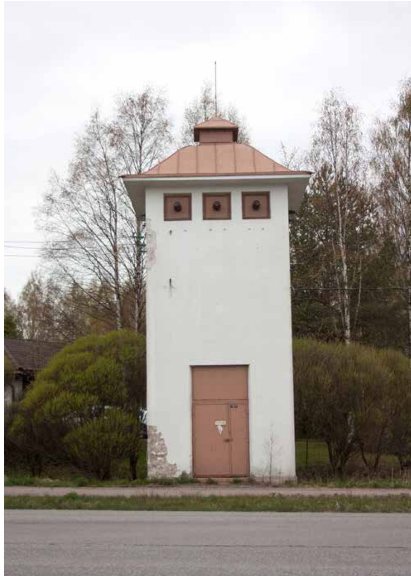
245A Lahelan muuntajatorni on Tuusulanseudun sähkölaitoksen ikioma malli.
