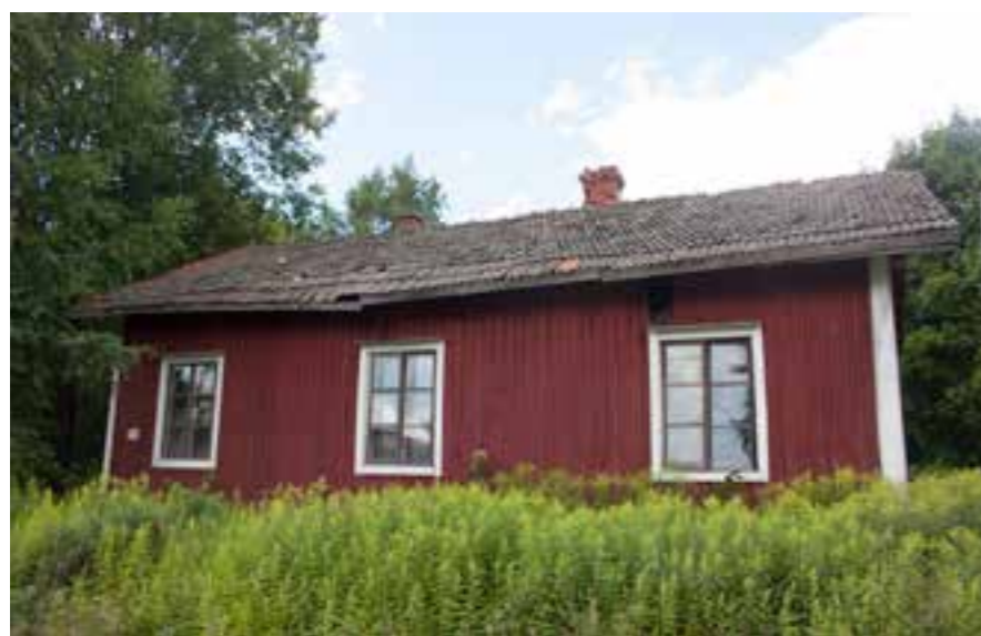
6F Mangsin työväentupa vuonna 2010 ennen kunnostusta.
