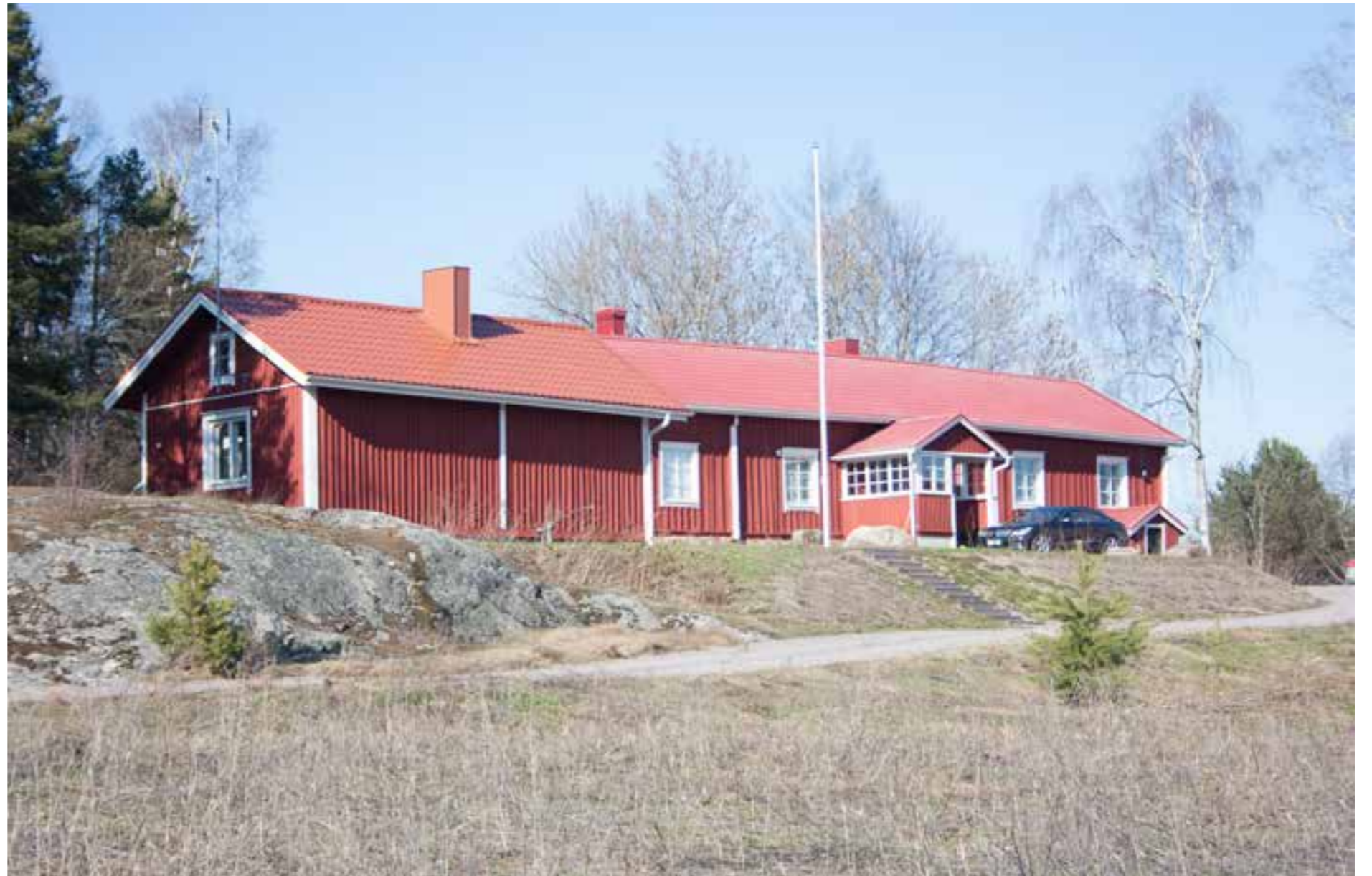
Bak-Vesterbyn syytinkimökki 2B ja päärakennus.
