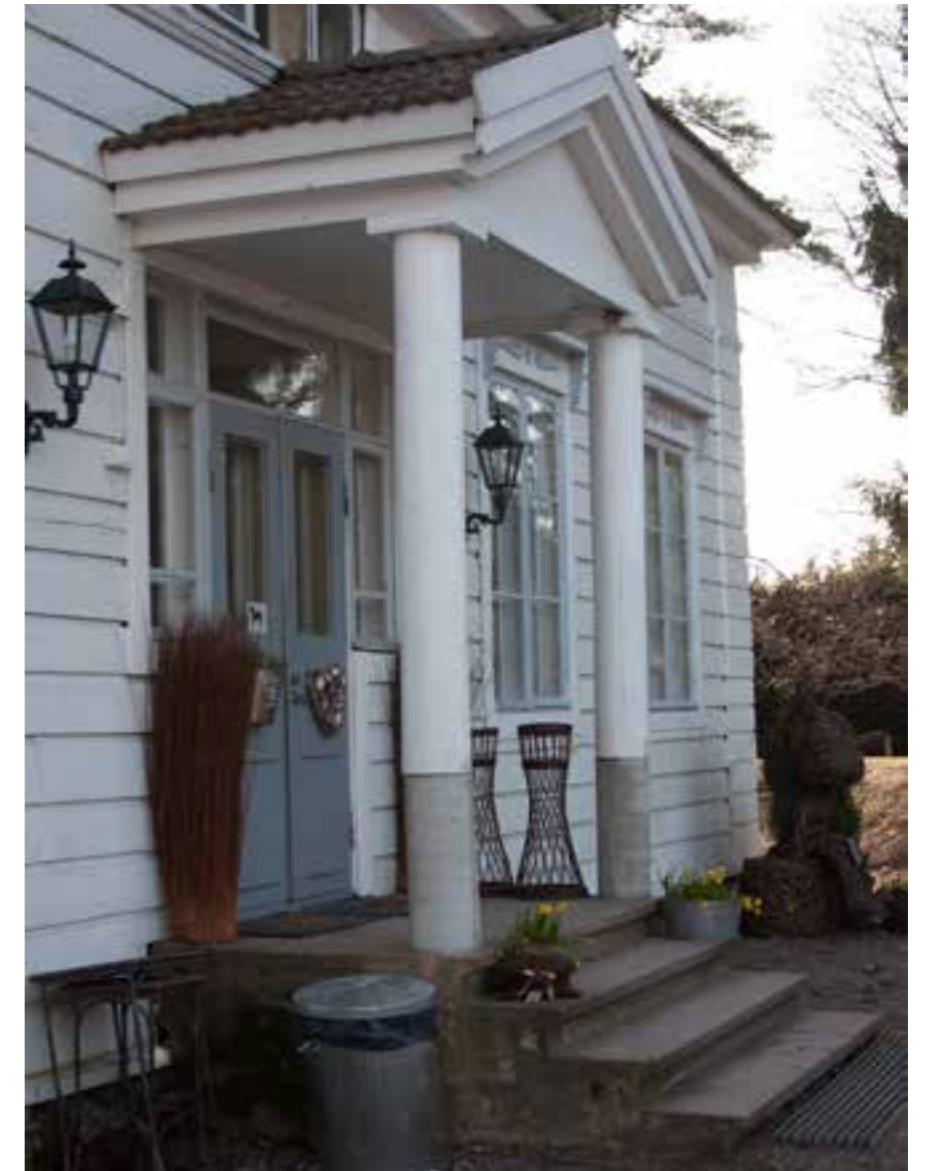
20A Jussilan pääkuisti korjauksineen.
