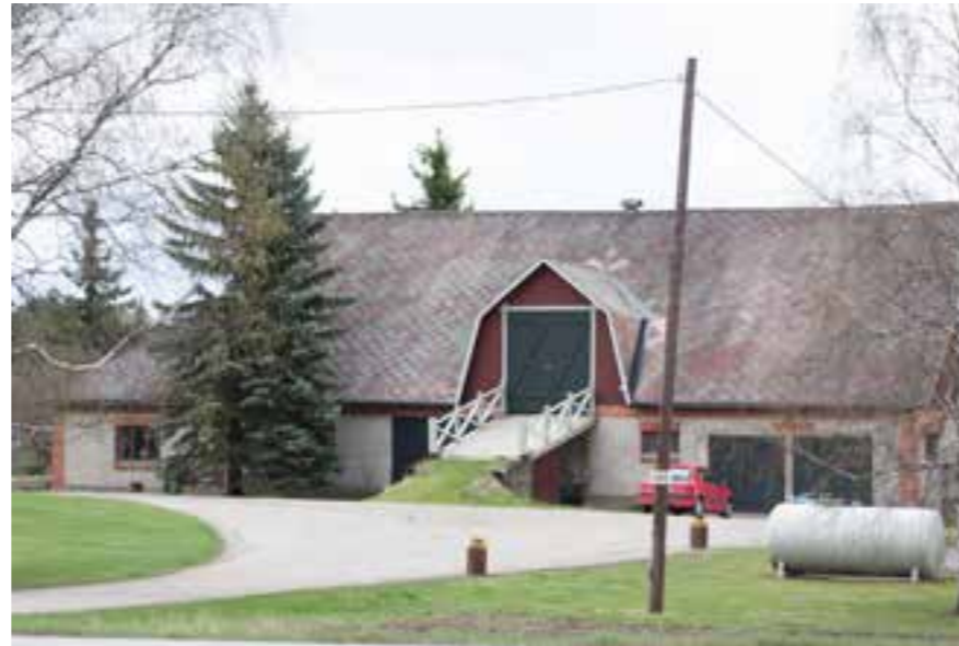
18B Annebergin betoni- ja savitiilistä tehty navetta.
