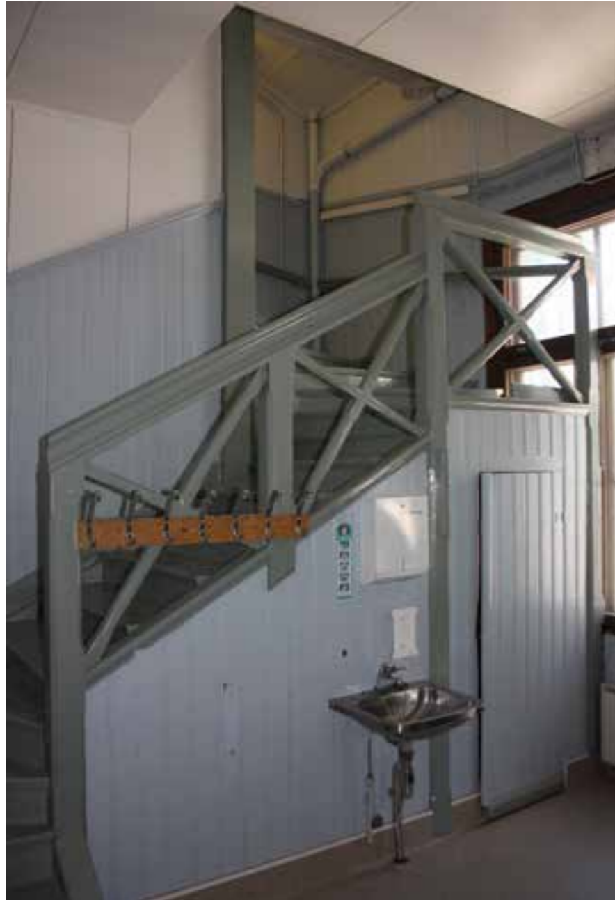
7 Koulun sisätiloissa on vielä havaittavissa alkuperäisiä sisustuselementtejä kuten sisäporras toiseen kerrokseen kaiteineen.
