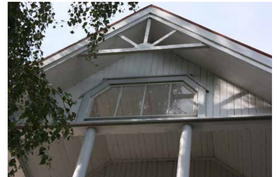
95 Villan avoimen yläkuistin yläosan ikkuna.
