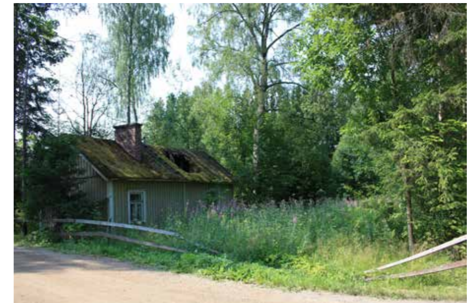
92T Kylänpään sauna, purettu.
