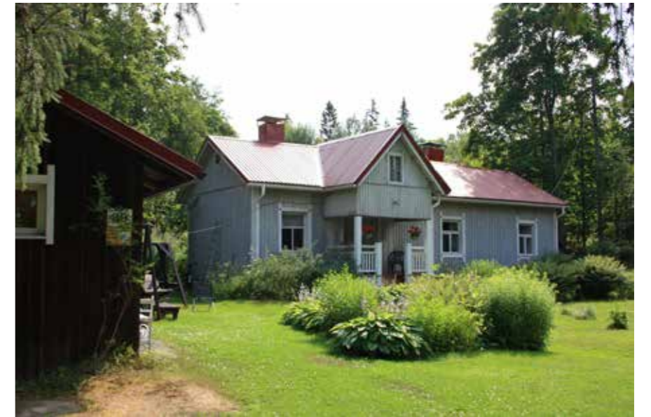
92A Koivikon päärakennus, jossa avokuistin päällä on vinttikamari.
