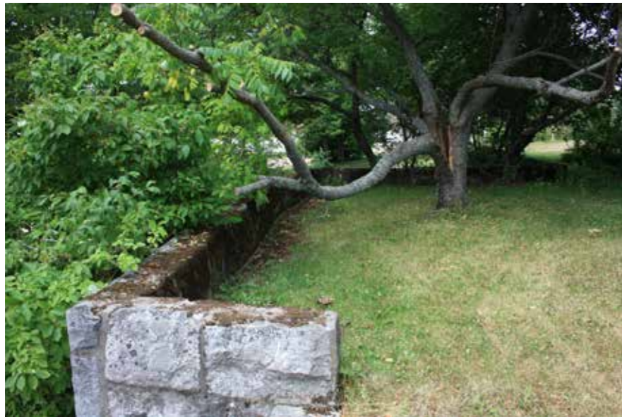
209A Anttilan kiviterassia murtaa puusto.
