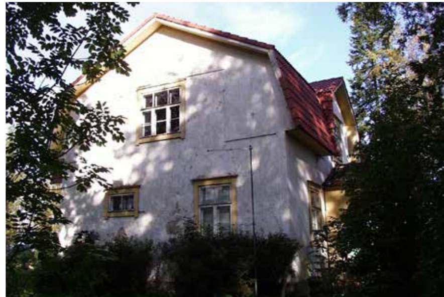
102A Lammaskallion uusi päärakennus, rapattu hirsitalo pohjoispääty. PS.
