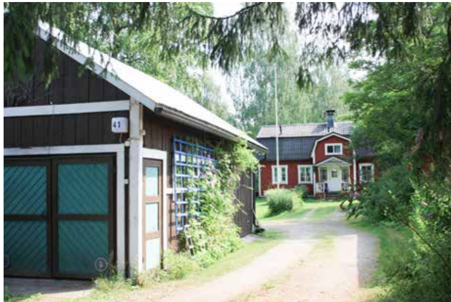
92D Pihlajamäen ulkorakennus ja päärakennus.
