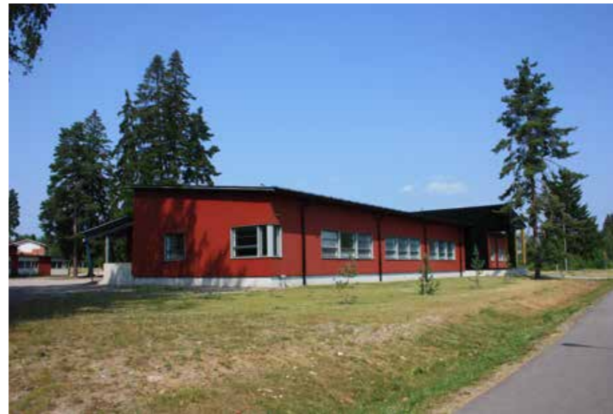
91 Paijalan alakoulun uudisrakennus ennen lisäosaa etelästä nähtynä.
