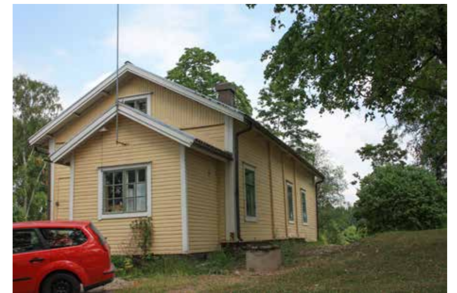
210 Vanhan Rannankoukun eteläpääty ja umpinainen päätykuisti.
