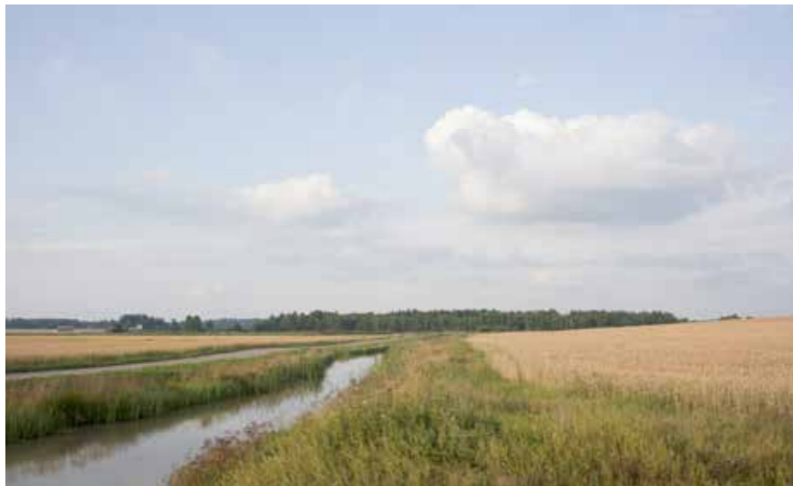
229 Ruskelan vanhaa kylänmäkeä Rantamon ja Seittelin kosteikkeijoa yhdistävä kaivanto.
