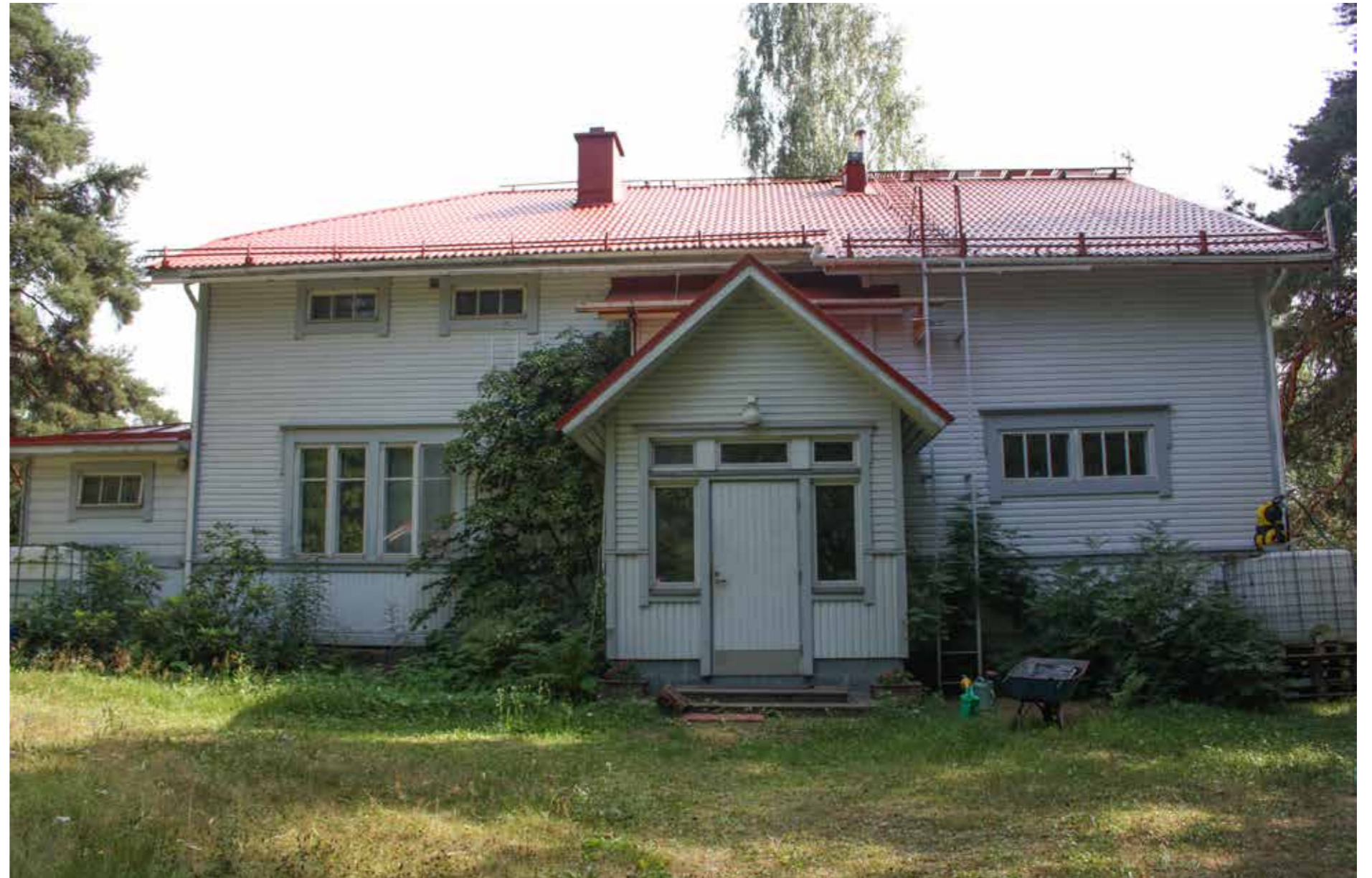
95 Villan päärakennus lännestä, pääsisäänkäynti.
