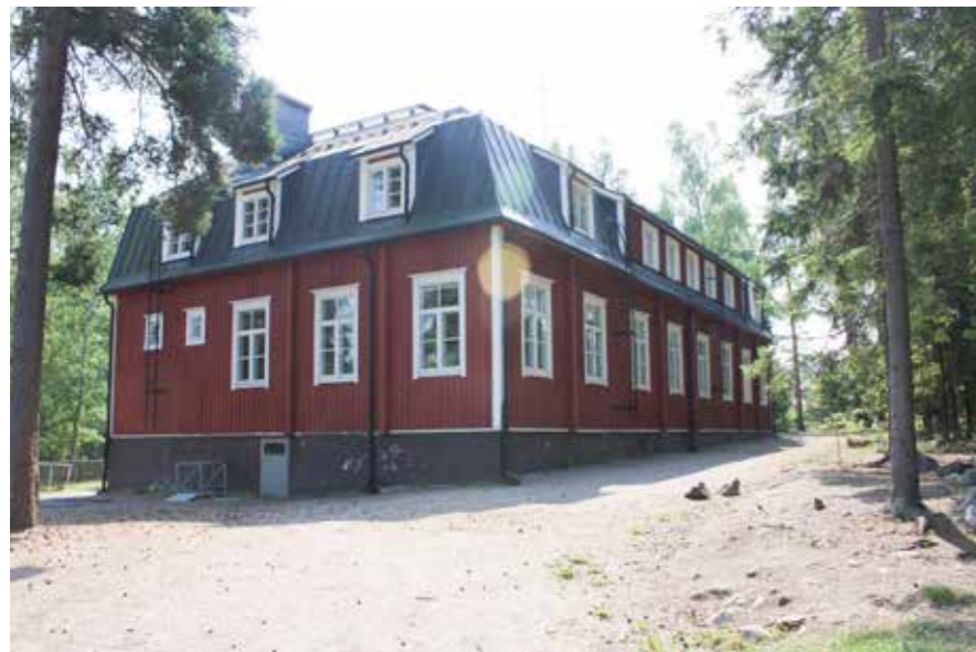
91 Paijalan ala-aste pohjoisen suunnasta. Koulussa on mansardikatto.
