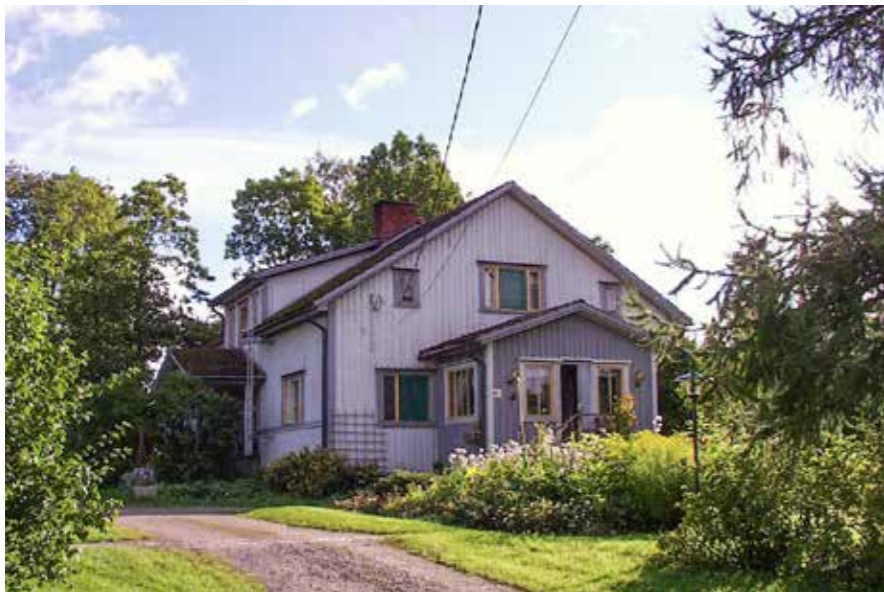
102 Lammaskallion vanha päärakennus etelästä. PS.
