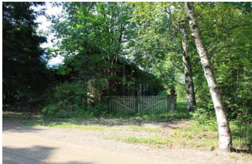
94 Kylänpään hirsinavetta ja talouspihaan vievä portti, joka toistaa pääportin aihetta.
