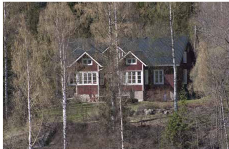
97 Syrjän päärakennus on suurehko, perinteistä maalaistaloa ja klassismia yhdistelevä huvila.
