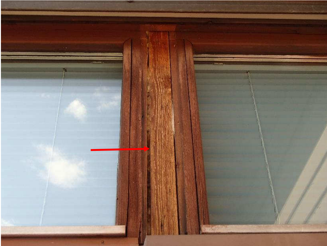
Kuva 110. Paikoin ikkunoiden apukarmit ovat esillä.
