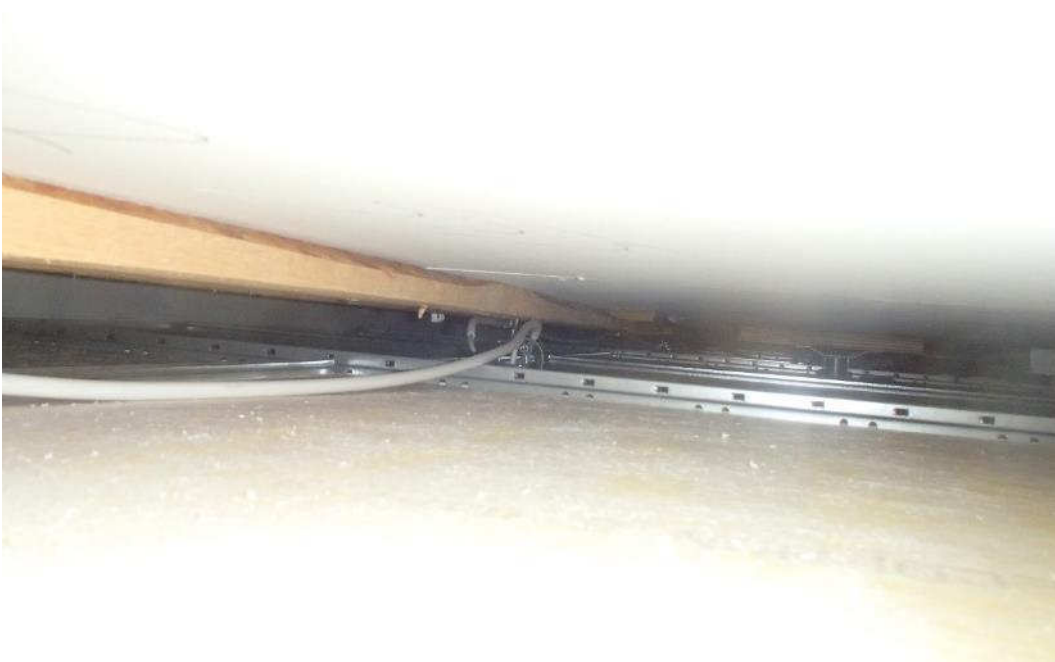
Kuva 56. Uuden alakaton rakenteen ripustukset.
