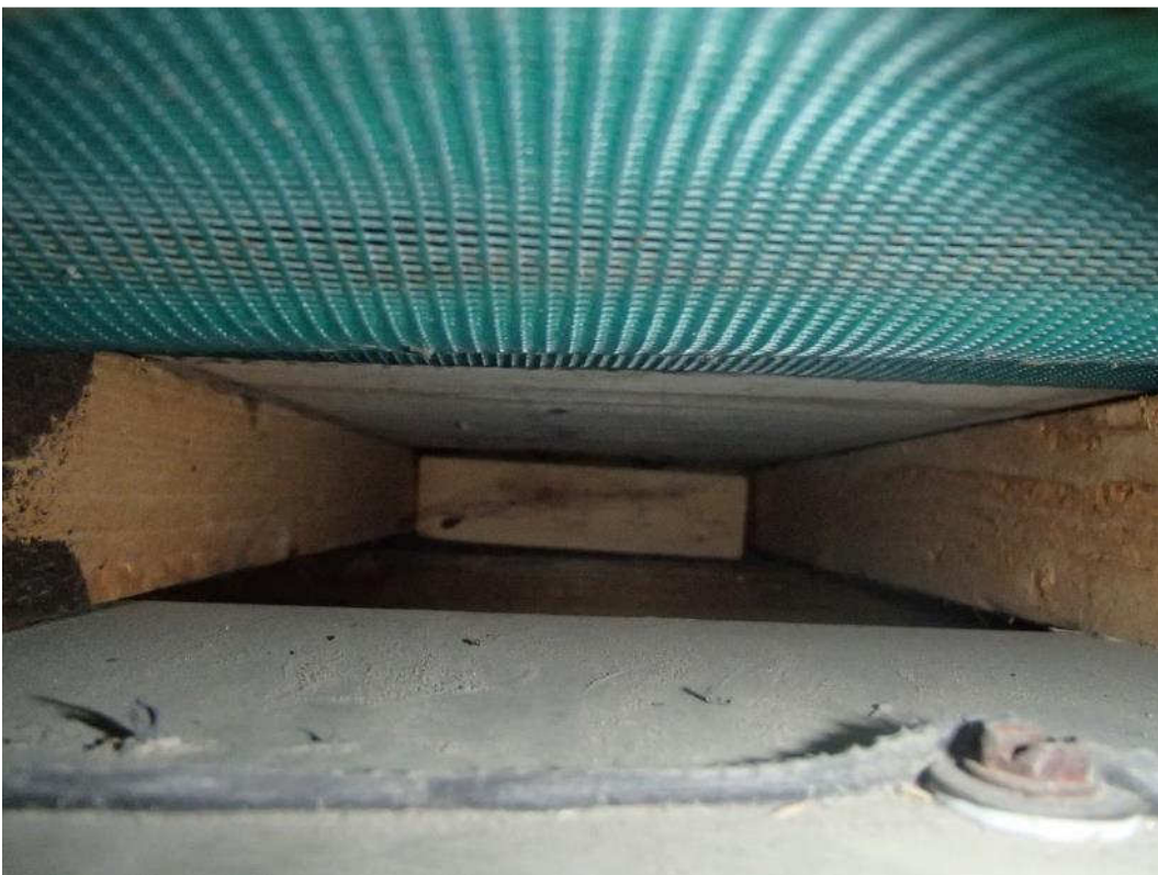
Kuva 53. Räystääiden tuletusrako. Kuvassa näkyy räystääiden rakenteita.
