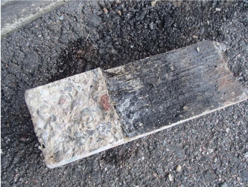
Kuva 98. Sokkelin sisäpinnat on sivelty bitumilla.
