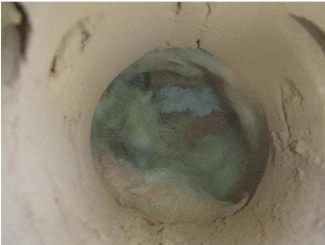
Kuva 4. Rakenneavaus vuonna 1967 rakennetun osan ulkovaipparakenteeseen.
