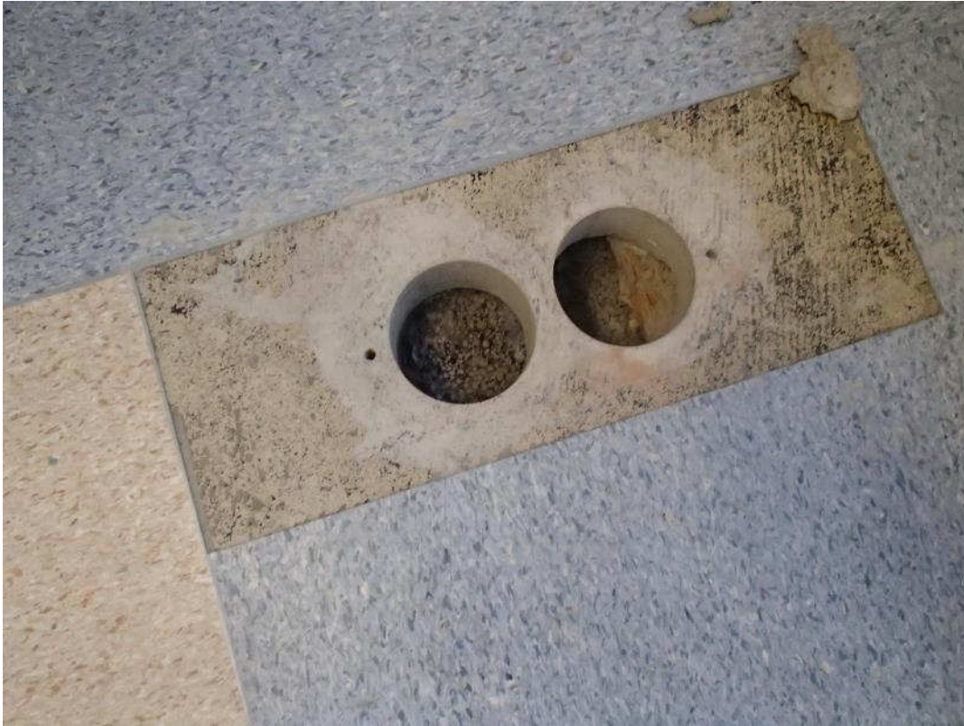
Kuva 76. Rakenneavaus luokkahuoneen 54 alapohjaan ulkovaipparakenteiden viereen.
