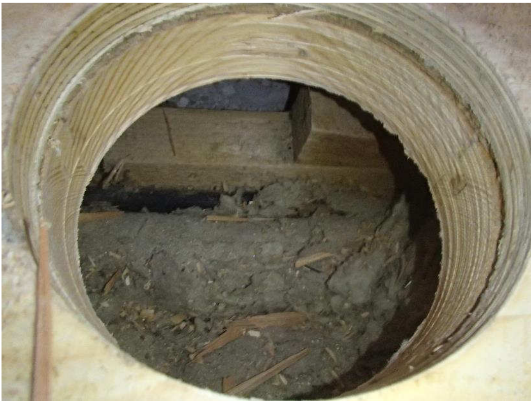
Kuva 84. Rakenneavaus kotitalousluokan alapohjaan.
