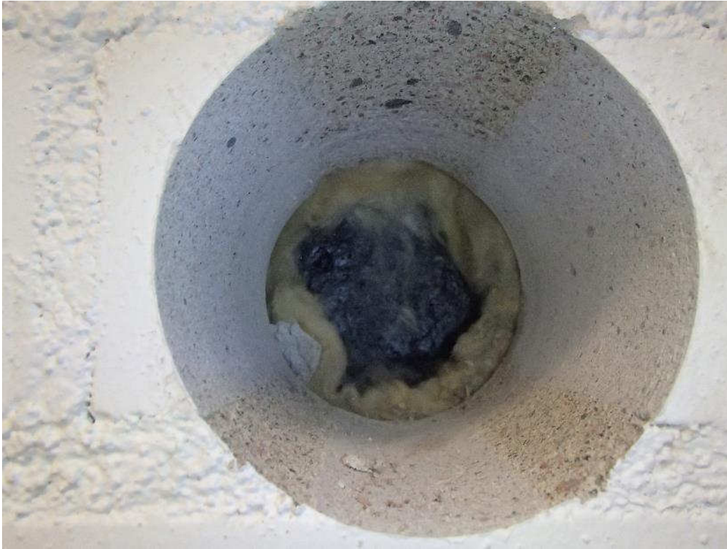
Kuva 87. Rakenneavaus maanastaiseen seinään naisten pukuhuoneesta.
