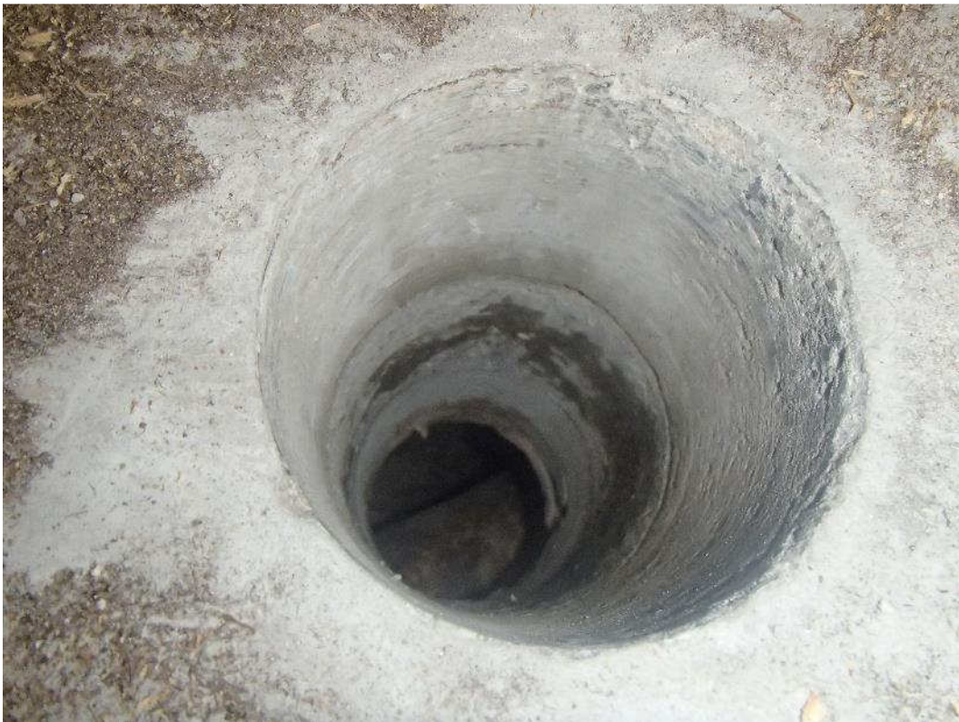
Kuva 126. Rakenneavaus työtilan 58 alapohjaan putkikanaalin kohdalta.
