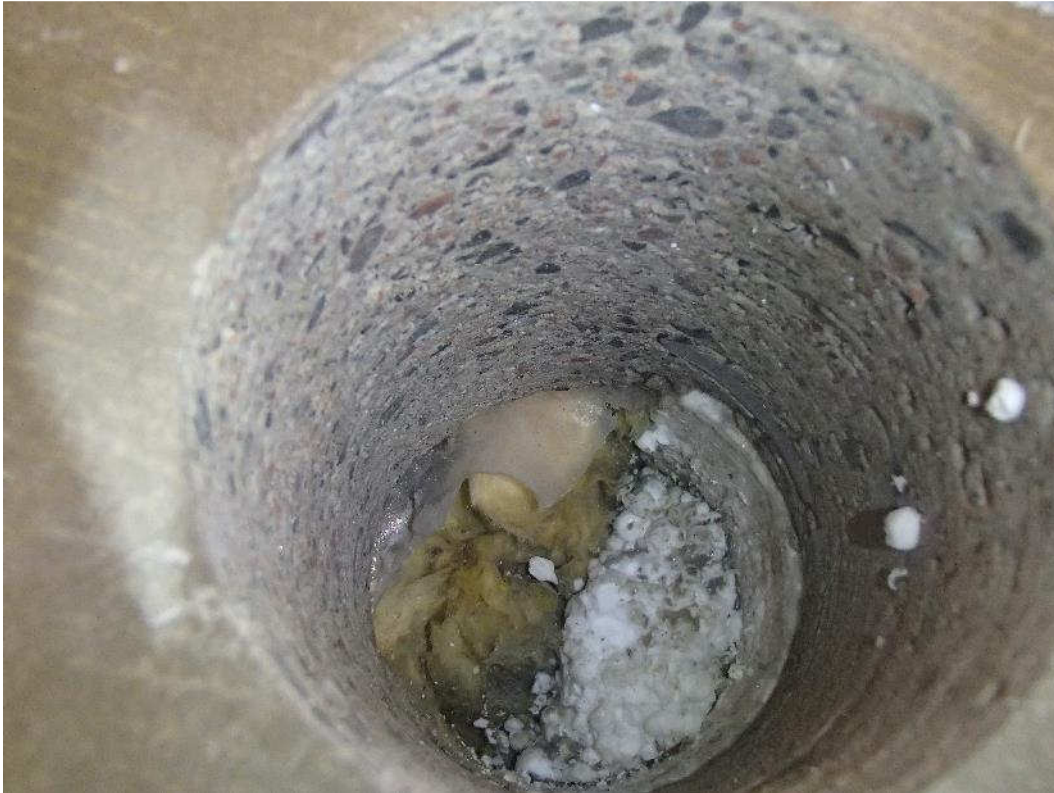
Kuva 129. Rakenneavaus luokan 62 alapohjaan ulkovaipparakenteen vierestä.
