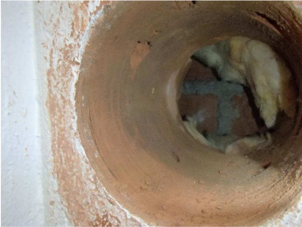
Kuva 6. Rakenneavaus vuonna 1967 rakennetun osan julkisivurakenteeseen luokkahuoneen 7 sisäpuolelta.
