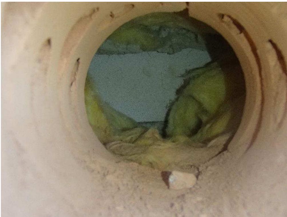
Kuva 96. Rakenneavaus vuonna 1976 rakennetun osan ulkovaipparakenteeseen.
