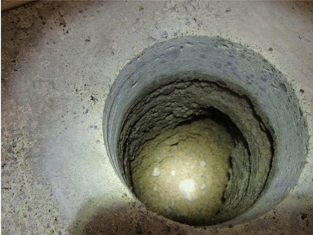
Kuva 78. Rakenneavaus luokkahuoneen 54 alapohjaan luokan keskiosalla.
