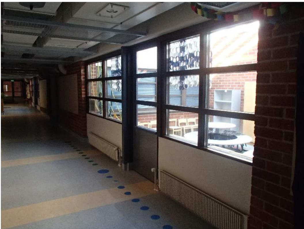
Kuva 44. Yleiskuva valopihojen väliseinästä.
