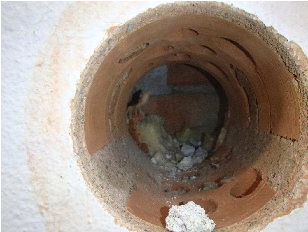
Kuva 7. Rakenneavaus vuonna 1967 rakennetun osan julkisivurakenteeseen luokkahuoneen 3 sisäpuolelta.
