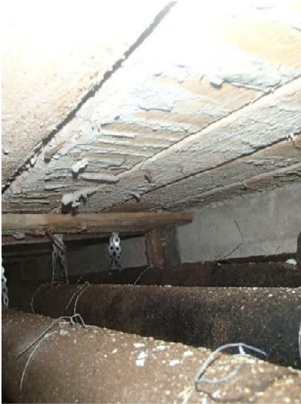
Kuva 130. Putkikanaalin sisällä on betonikannen muottilaudat.
