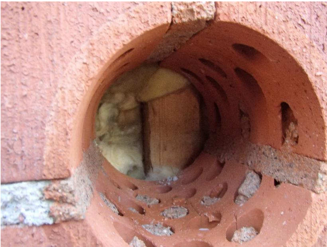
Kuva 109. Ikkunoiden apukarmit on tuettu sokkelin päälle.
