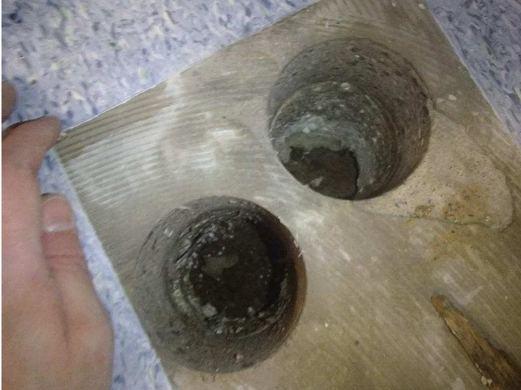
Kuva 127. Rakenneavaus työtila 58 alapohjaan ulkovaipparakenteen vierestä.
