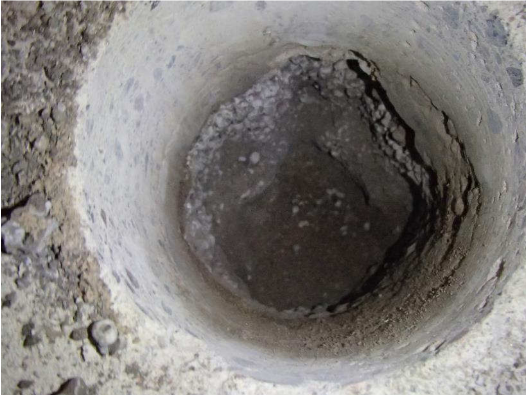
Kuva 82. Rakennearaus luokkahuoneen 54 alapohjaan eteisen reuna-alueella.
