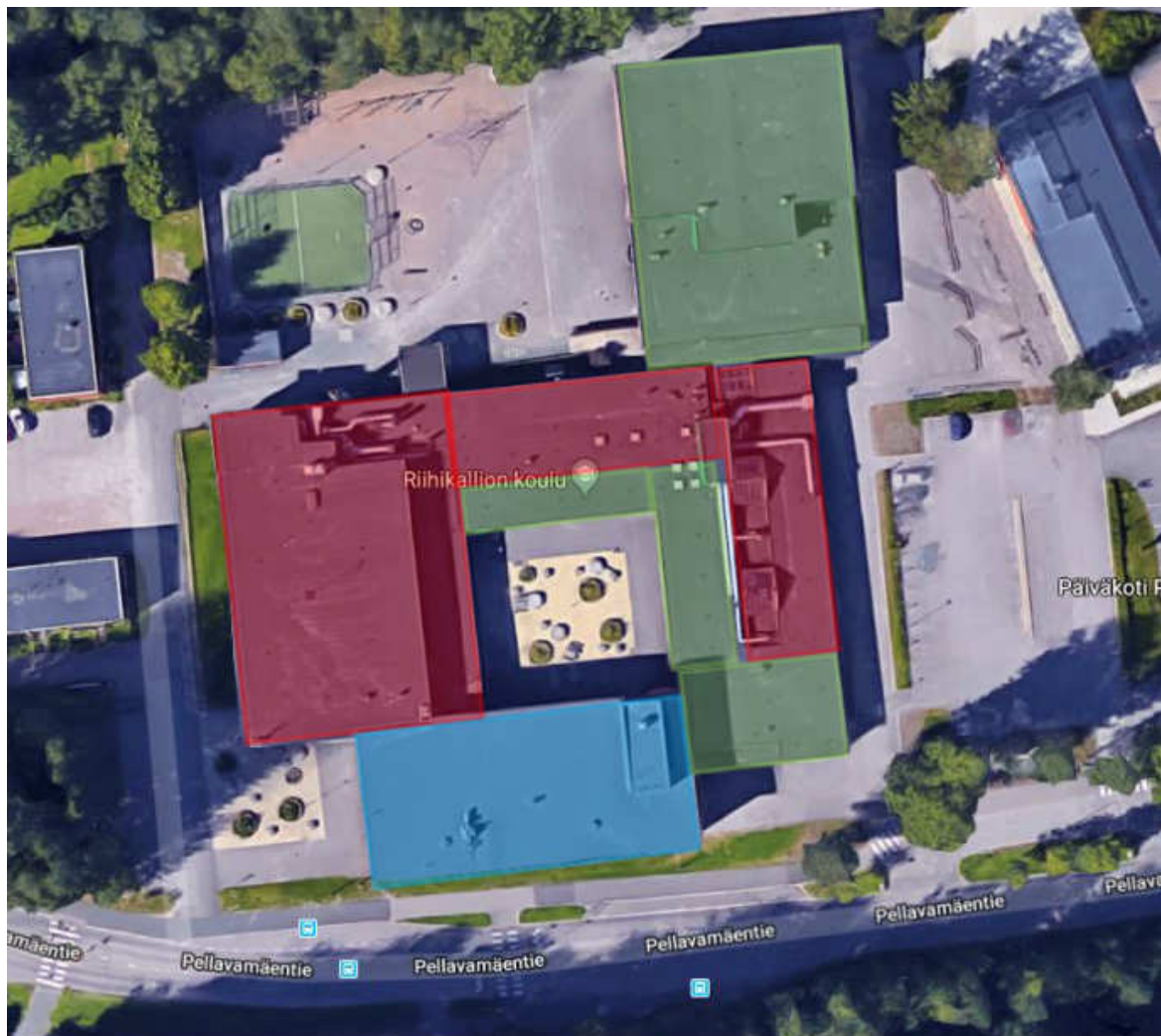
Kuva 1. Koulurakennuksen rakennusvaiheet on varjostettu eri väreillä. Punainen 1967, vihreä 1976 ja sininen 2006.
