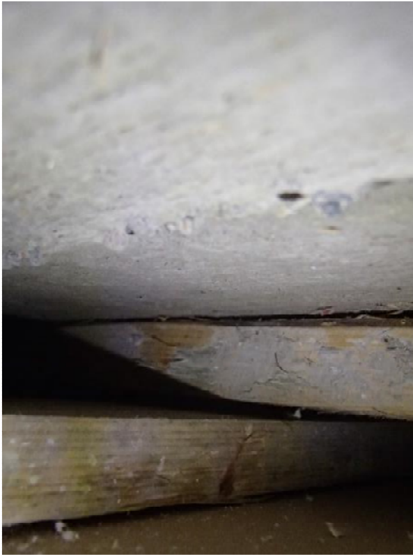
Kuva 55. Alkuperäisen alakaton rakenteet.
