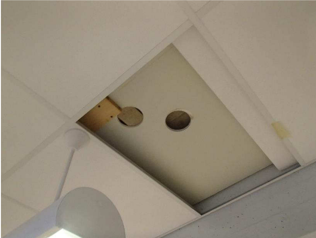
Kuva 54. Rakenneavaus alakattoon
