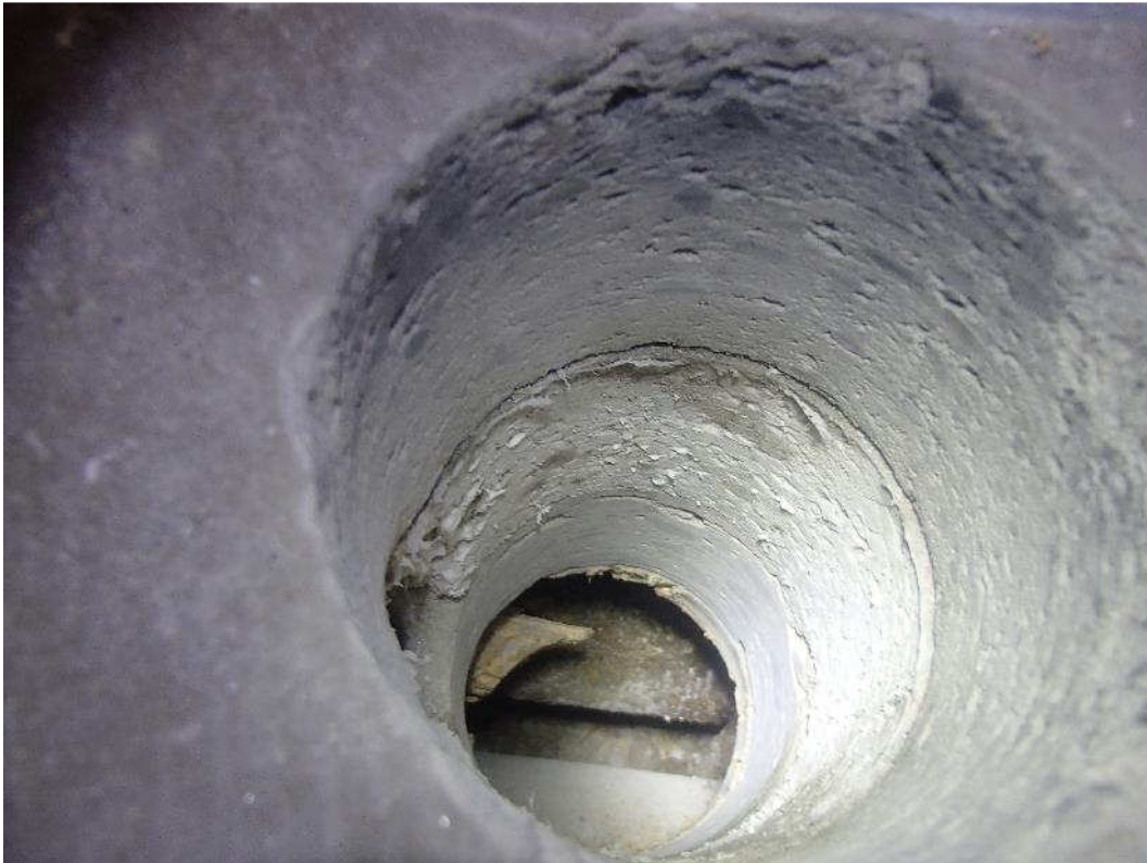
Kuva 128. Rakenneavaus luokan 62 alapohjaan putkikanaalin kohdalta.
