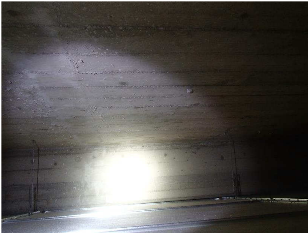
Kuva 57. 2.kerroksisen osuuden 1.kerroksen alakattojen ripustus.
