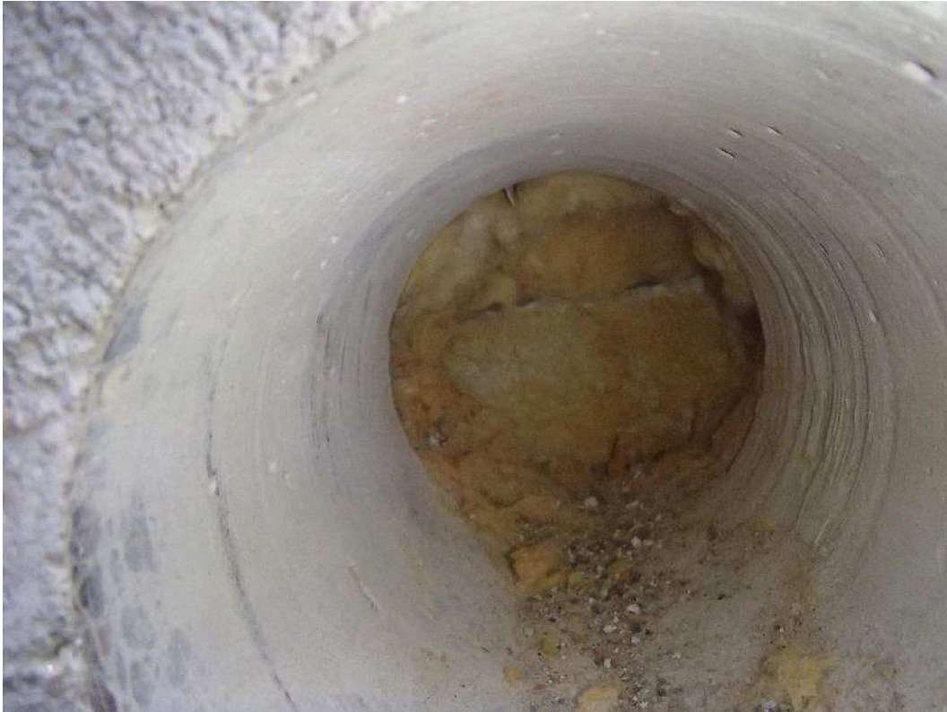
Kuva 35. Rakenneavaus vuonna 1967 rakennetun osan vanhaan sokkelirakenteeseen.
