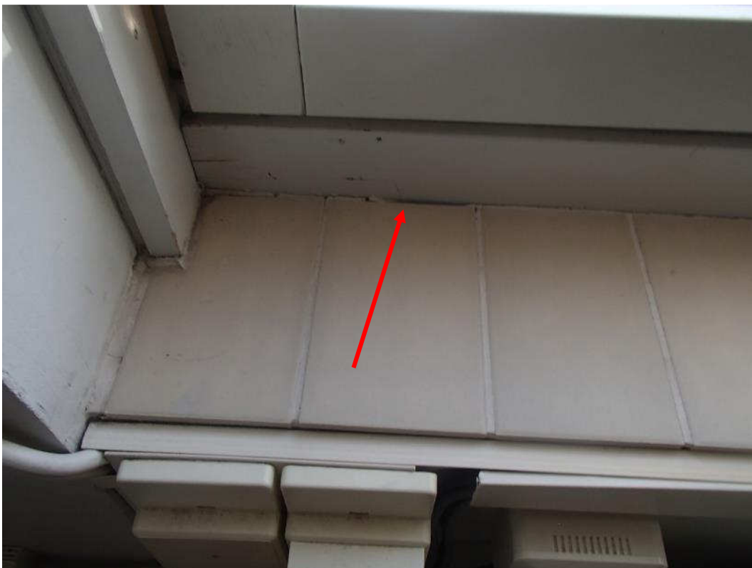
Kuva 19. Ikkunoiden ja klinkkerilaattojen välistä on eristetilasta ilmayhteys sisäilmaan.
