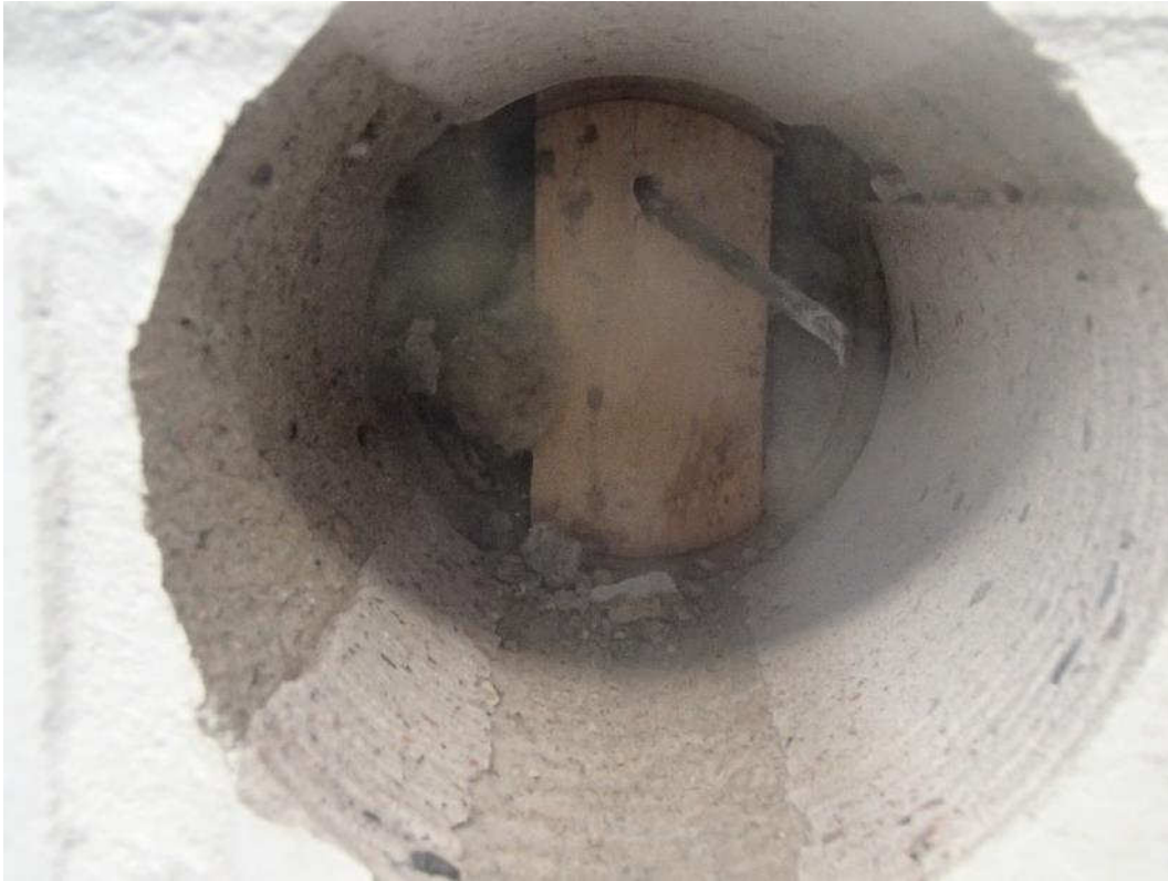
Kuva 26. Ulkoseinärakenteen sisällä kulkevat ikkunoiden apukarmien puutolpat.
