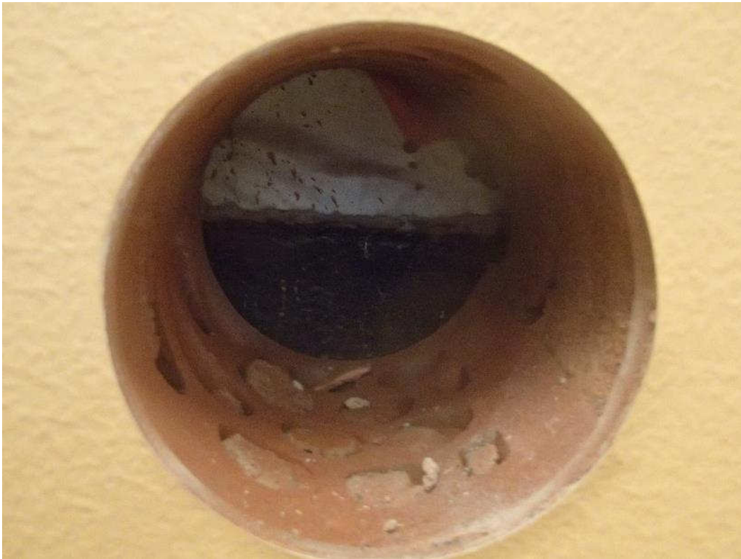
Kuva 95. Rakenneavaus vuonna 2012 rakennetun osan ja vuonna 2001 rakennetun osan väliseen vanhaan ulkoseinärakenteeseen luokkahuoneen 1121 puolelta.
