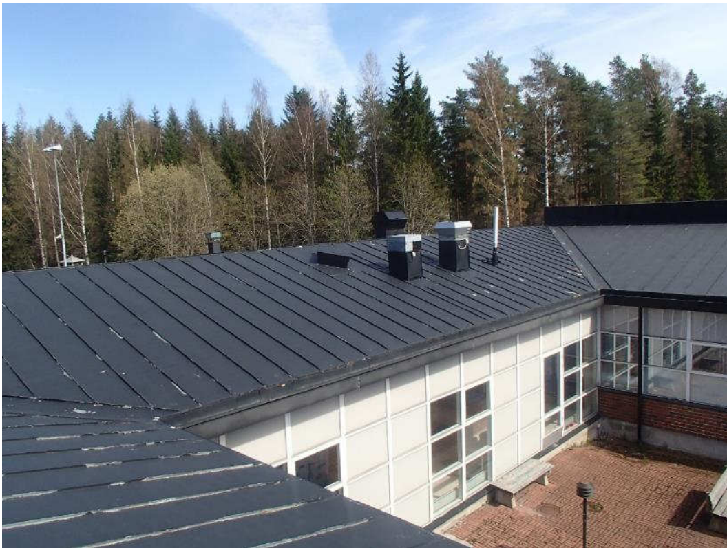
Kuva 41. Yleiskuva konesaumapeltikatosta.
