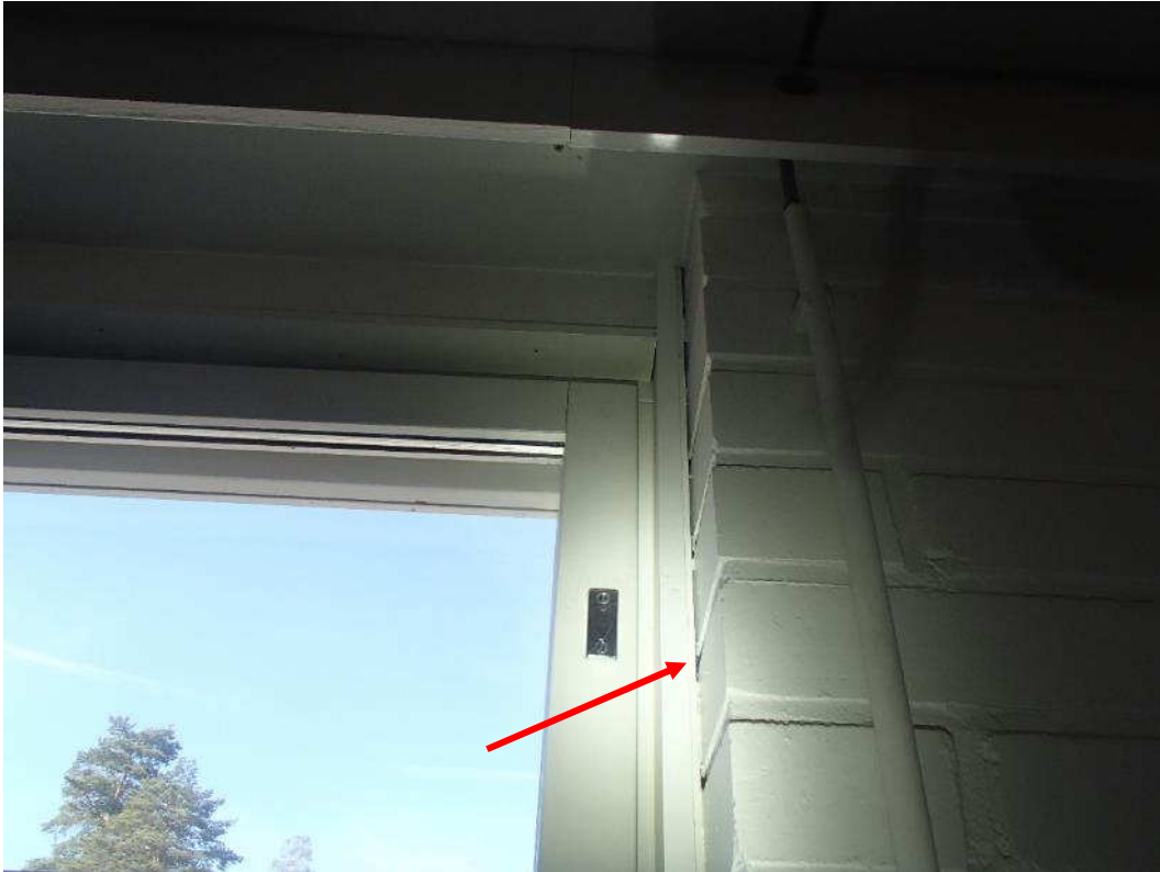
Kuva 20. Ikkunoiden peitelistan ja sisäverhousmuurauksen välistä on eristetilasta ilmayhteys sisäilmaan.
