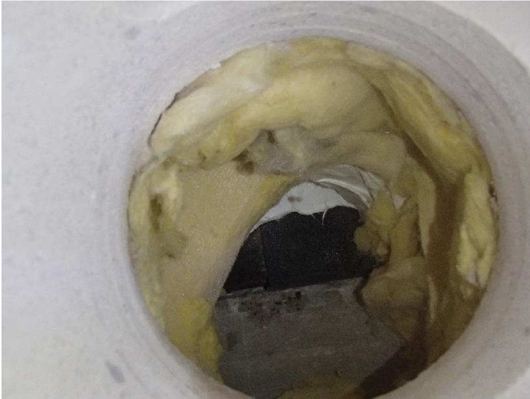
Kuva 76. Rakenneavauksen perusteella ulkovaipparakenteet vastaavat alkuperäisiä suunnitelmia.
