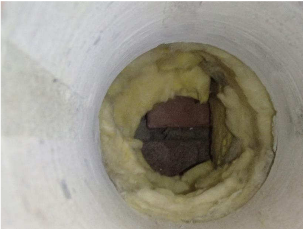
Kuva 7. Rakenneavaus vuonna 1985 rakennetun osan ulkoseinärakenteeseen.
