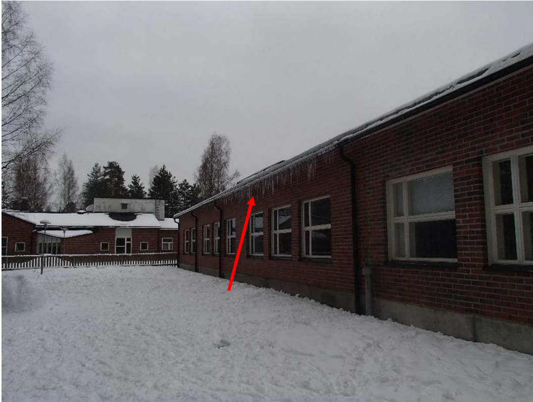
Kuva 84. Rästyllä havaittiin voimakasta jääpuikkojen muodostumista.
