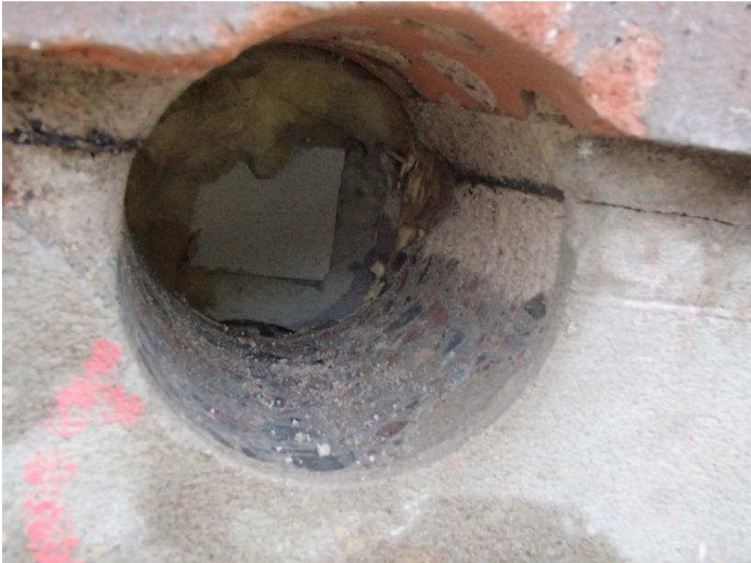
Kuva 8. Rakenneavaus vuonna 1985 rakennetun osan sokkelirakenteeseen.
