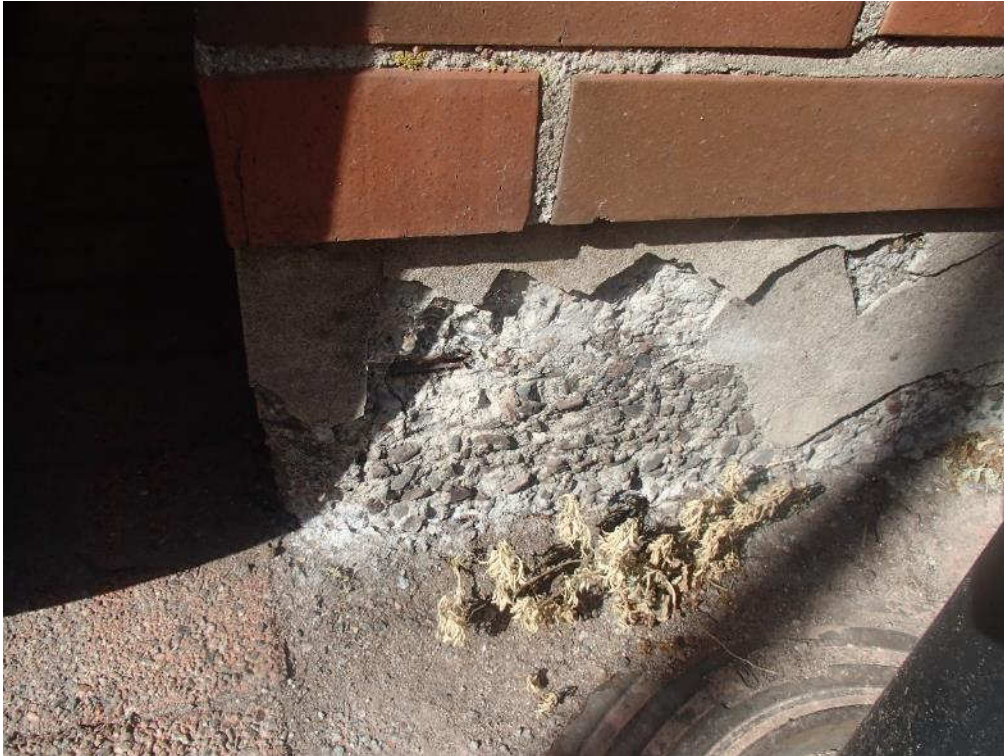
Kuva 30. Sokkelit ovat paikoin pahoin rapautuneet.
