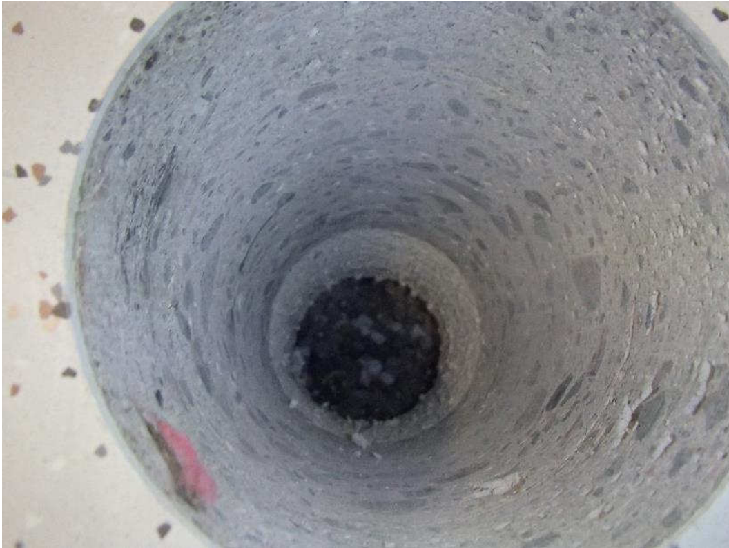
Kuva 89. Rakenneavaus rakennuksen alapohjaan.
