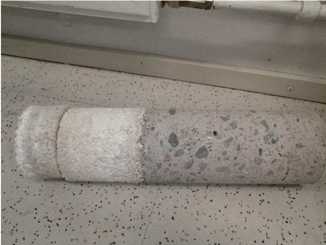
Kuva 88. Rakenneavaus rakennuksen alapohjaan.
