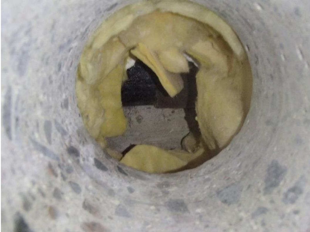
Kuva 75. Rakenneavaus vuonna 2001 rakennetun laajennusosan ulkoseinärakenteeseen sisäpuolelta luokkahuoneessa 1103.
