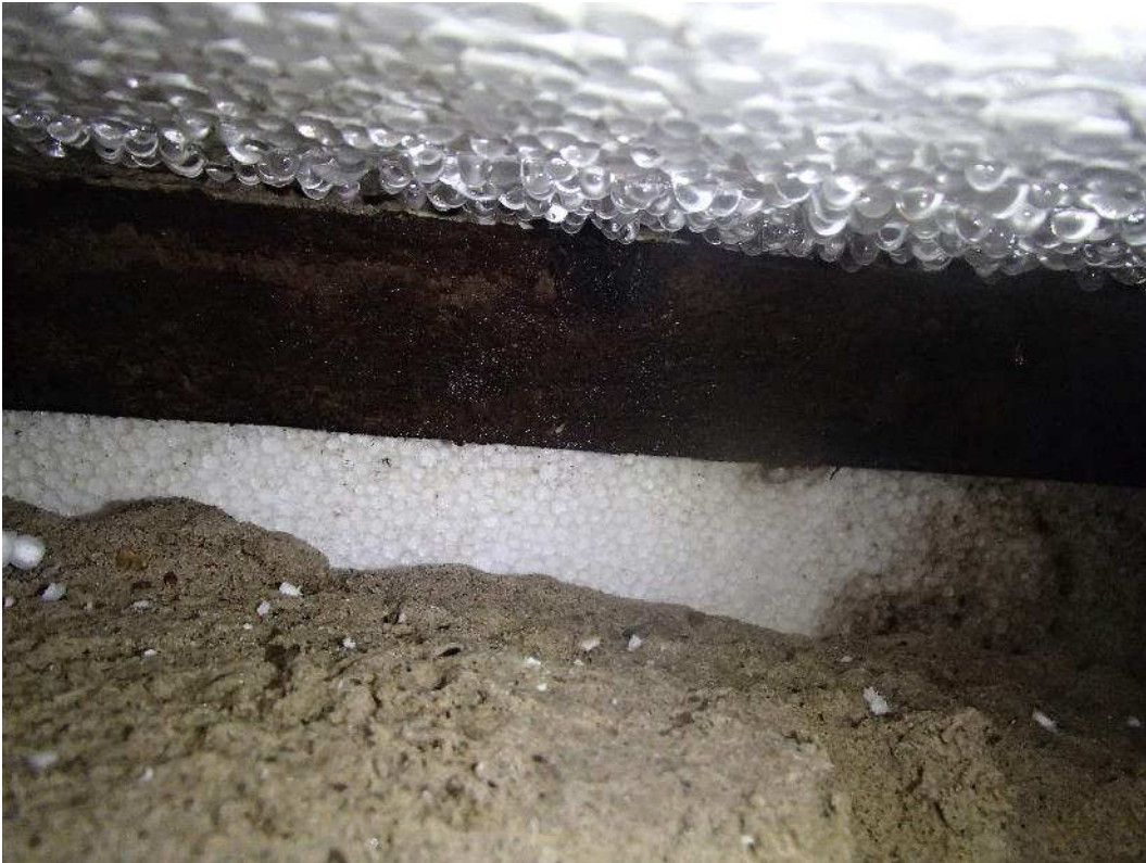
Kuva 64. Alapohjan maa-ainekset ovat painuneet sokkelin vierestä sekä EPS-eristeen alapintaan tiivistyy kosteus ja alapohjan ulkolaidassa kulkee lahonnut puurima.
