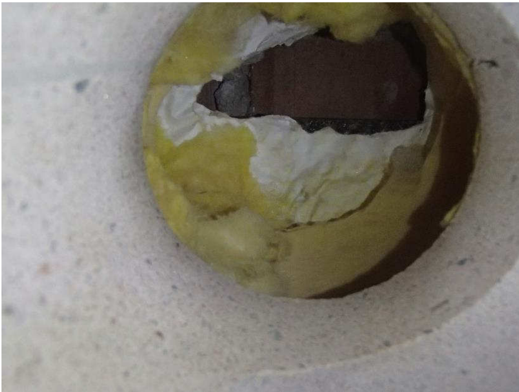
Kuva 74. Rakenneavaus vuonna 2001 rakennetun osan ulkoseinärakenteeseen sisäpuolelta
