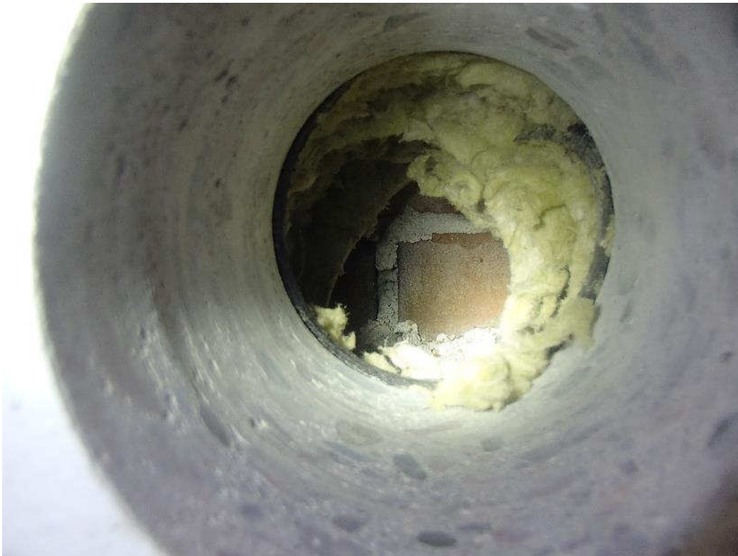
Kuva 94. Rakenneavaus vuonna 2012 rakennetun osan ulkoseinärakenteeseen luokkahuoneessa 1121.
