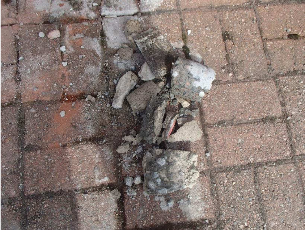
Kuva 32. Sokkelit ovat paikoin pahoin rapautuneet.
