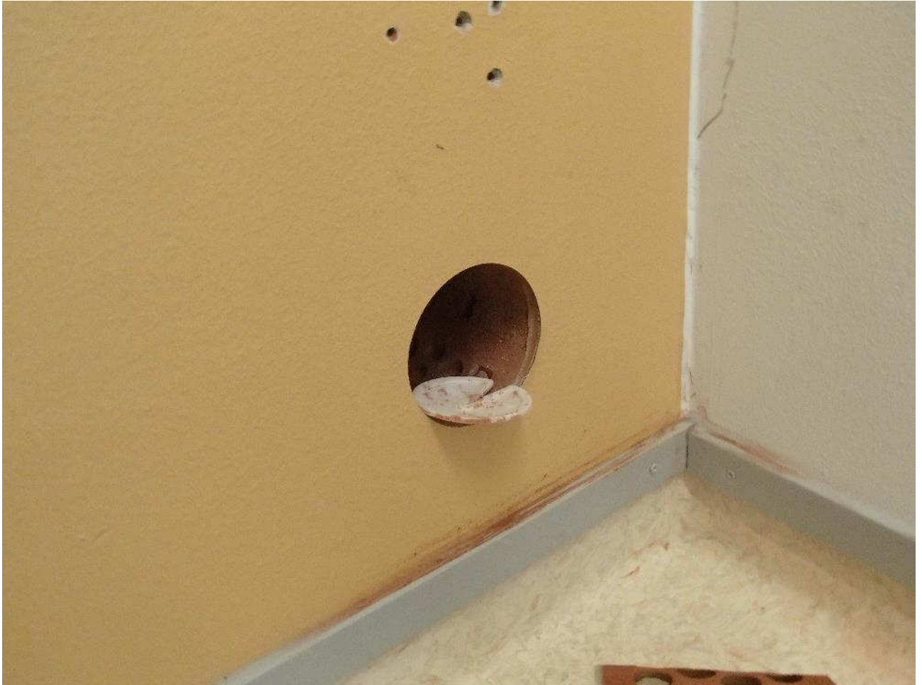
Kuva 100. Yleiskuva luokkahuoneen 1121 alapohjan pintamateriaalista.
