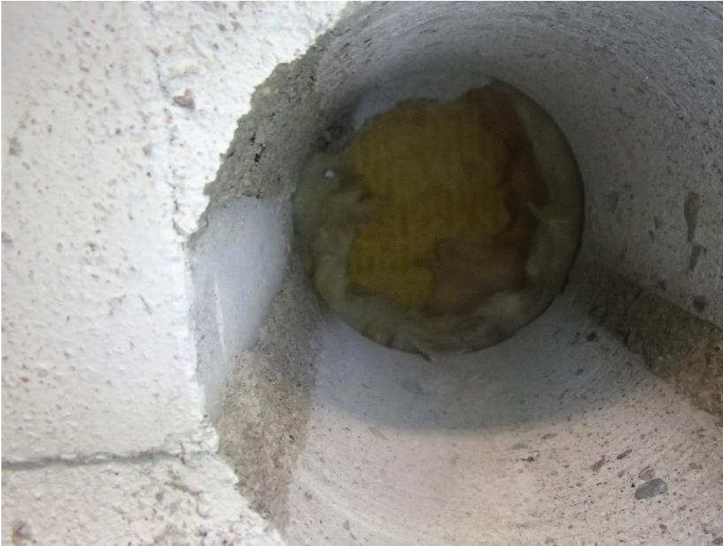
Kuva 6. Rakenneavaus vuonna 1985 rakennetun osan ulkovaipparakenteeseen.
