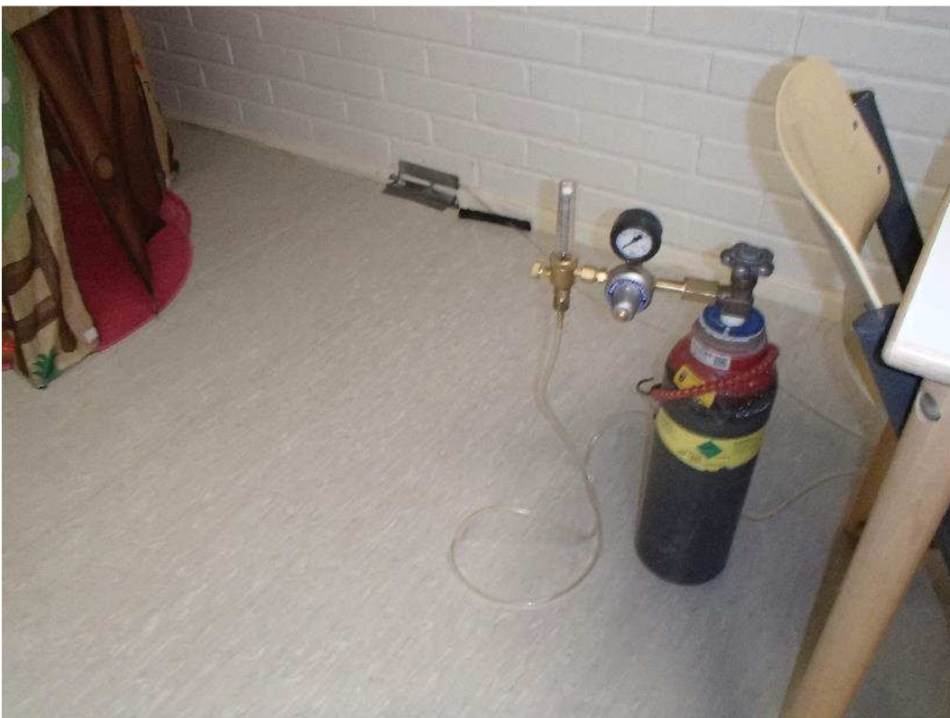
Kuva 62. Korvausilmaventtiiliin laskettiin merkkikaasua tuulettuvan lattiamaton toimivuuden varmistamiseksi.
