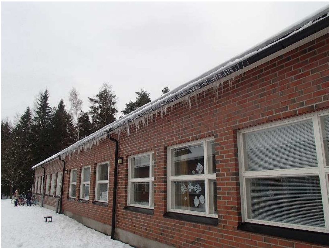
Kuva 85. Rästyllä havaittiin voimakasta jääpuikkojen muodostumista.
