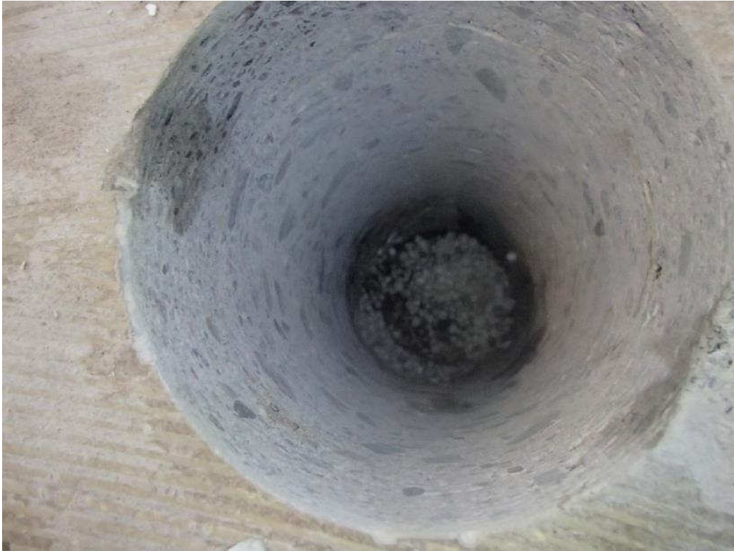
Kuva 59. Rakenneavaus luokkahuoneen alapohjaan.
