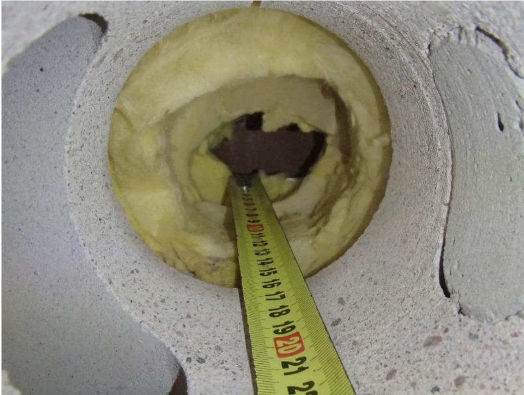
Kuva 73. Rakenneavaus vuonna 2001 rakennetun osan ulkoseinärakenteeseen sisäpuolelta.
