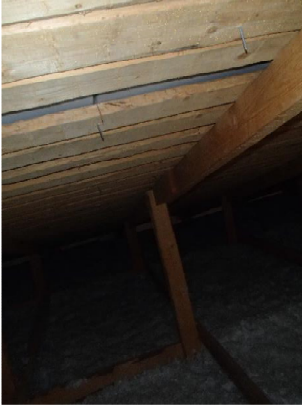
Kuva 56. Vesikatteen alapuolella ei ole asennettu aluskatetta.
