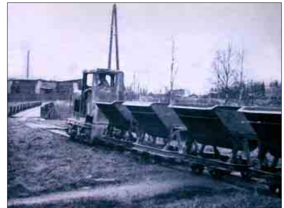
Kuva 12 Palojoen yli kulki savikuormia varten rakennettu silta. Taustalla tiilitehdas
