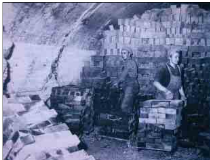
Kuva 14 Tiilenteko oli tehtaan alkuvaiheessa käsityötä: tiilet lyötiin yksitellen puumuotteihin ja vetohärät pyörittivät saviranoja joissa savimassa sekoitettiin. 1900 luvun alussa Jokelan Tiilitehdas oli kasvanut Suomen suurimmaksi tiilitehtaaksi joka tuotti parhaimmillaan 8 miljoonaa tiiltä vuodessa..
