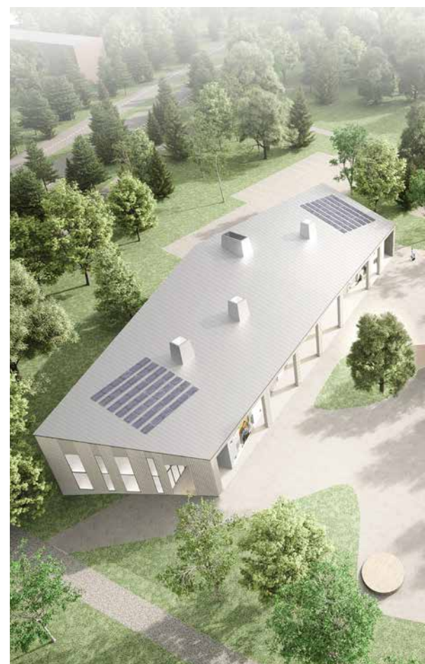
Havainnekuva Martta Wendelin -päiväkoti: Martta Wendelin -päiväkodin rakennusmateriaaleina toimivat ympäristöystävälliset, massiivipuiset CLT-elementit.
